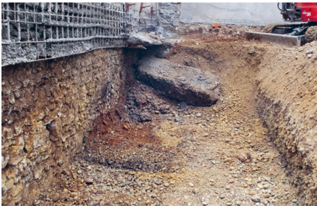
ABB. 23 Aushubarbeiten an der Kontermauer. Im oberen Bereich ist die Mauer mit Ankern und Spritzbeton gesichert, unten ist das regelmässige Mauerwerk sichtbar. Foto: Benedikt Wyss.
