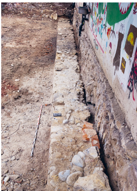
ABB. 11 Der freigelegte Teil der Stadtmauer am Klingentalgraben, links davon die Verfüllung des Stadtgrabens. Foto: Roman Schmidig.
