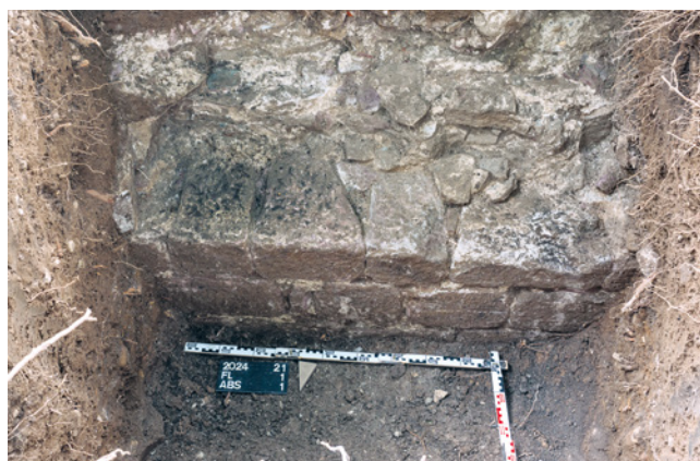
ABB. 31 Die präzise gemauerte Kontermauer und deren harter Mörtel wiesen – verglichen mit anderen Mauerabschnitten – eine erstaunlich hohe Qualität auf. Foto: Fabian Bubendorf.
