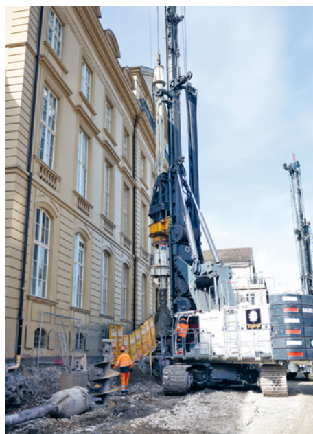
ABB. 9 Vor der hinteren Fassade des Markgräflerhofs, dem ältesten Barockpalais der Schweiz, wurden Bohrungen für Pfahlwände einer grossen Baugrube vorgenommen. Die Bauarbeiten auf dem Gelände des Unispitals wurden archäologisch überwacht. Foto: Sharath Mohan.
