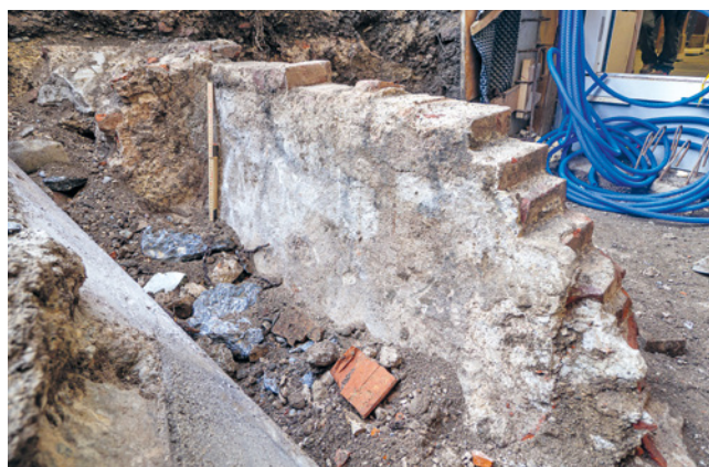
ABB. 39 Die nachträglich eingezogene Backsteinmauer ist auf der linken Seite stark mit Verputz verkleidet. Foto: Michael Ketzler.
