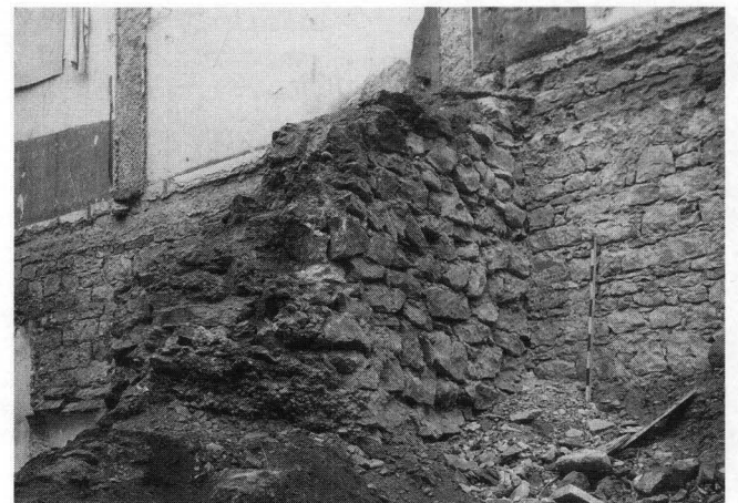
Abb. 8. Petersgraben 15, 1965/19, Fundstelle Nr. 11. Die Innere Stadtmauer während des Abbruchs. Blick Richtung Nordwesten an die innere Mauerfront im Bereich des ehemaligen Hauses Nr. 15. Die Abbruchkante entspricht der Höhe des Strassenniveaus. Ca. 2 m tiefer ist die Fundamentzone im Bereich der Mauerfront immer noch nicht erreicht. Die Hausfundamente des 19. Jh. stossen beidseits an die Stadtmauer an. – Dokumentation 1965/19: Foto 7.
