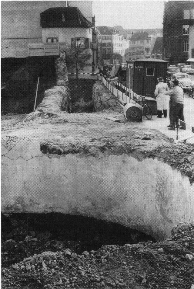
Abb. 15. Petersgraben 35, Bärenfelserhof; Fundstelle Nr. 22a. Blick nach Süden auf die Fundamente des abgerissenen Schalenturms (vorn) und auf die Abbruchkante der Inneren Stadtmauer (hinten). Im Hintergrund der noch stehende Schalenturm Petersgraben 43 und links anschliessend die Wallhinterschüttung (unter dem Bretterzaun). Im Erdprofil ist keine Stadtmauer zu erkennen, die Burkhardtsche Stadtmauer verlief dort auf der Flucht der nachmaligen Inneren Mauer. – Foto: P. Heman.
