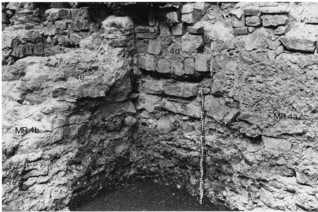
Abb. 22. Blick in die südöstliche Ecke im Innern von Haus IV, mit Türzumauerung 4e und verblendeter Türblattnische 4d. – Foto: Basler Denkmalpflege.
