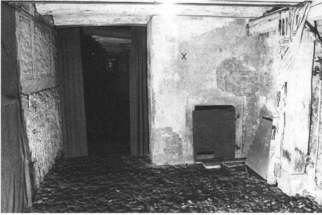
Abb. 38. Der «Hitzkasten» X der Seidentrocknungsanlage von 1857 im Souterrain der Kapelle vor dem Abbruch im Frühjahr 1987. Links der gemauerte Sockel des Treppenhauseunterbaues T. Ansicht von Osten her. – Foto: Basler Denkmalpflege.
