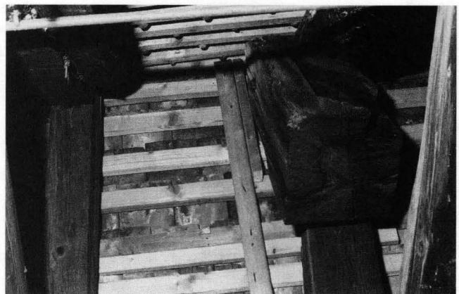
Abb. 33. Pfostenstummel des 1539 abgebrochenen Glockenstuhls im Firstgebälk der Deutschritterkapelle. – Foto: Basler Denkmalpflege.
