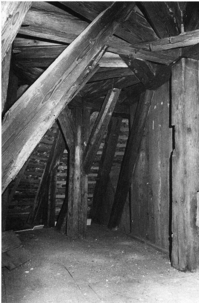
Abb. 32. Die Chorabwalmung des Dachstuhls der Kapelle von 1417. – Foto: Basler Denkmalpflege.
