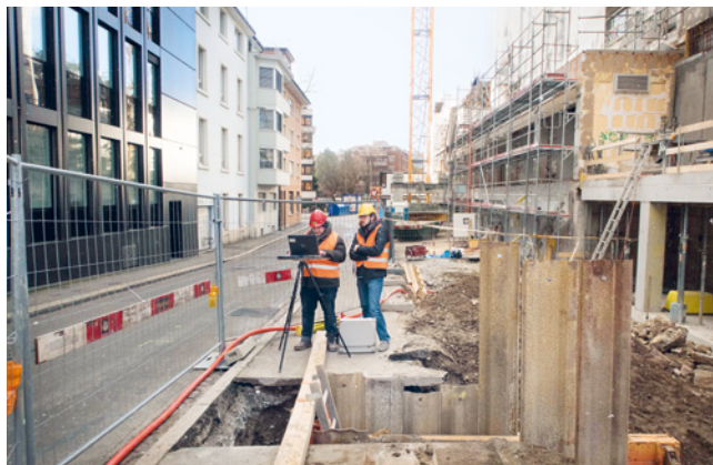
ABB. 28 Der durch den Leitungsgraben aufgedeckte Abschnitt des Rümelinbaches wird vom Trottoir aus eingemessen. Foto: Martin Allemann.
