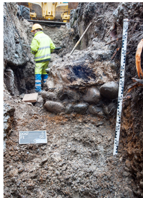
ABB. 3 Für das Verlegen der neuen Leitungen am Schlüsselberg wurden tiefe und enge Gräben angelegt. Foto: Martin Allemann.
