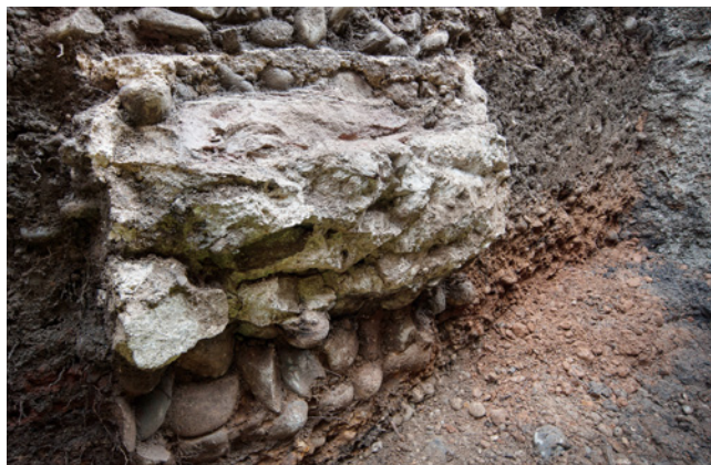
ABB. 4 Das Pfeilerfundament des spätantiken Grossbaus ist in den roten Verwitterungshorizont gegründet. Auf drei trocken gesetzte Kieselwackelagen folgt hartes, gemörteltes Mauerwerk, in das einst ein grösserer Sandstein gebettet war. Foto: Martin Allemann.
