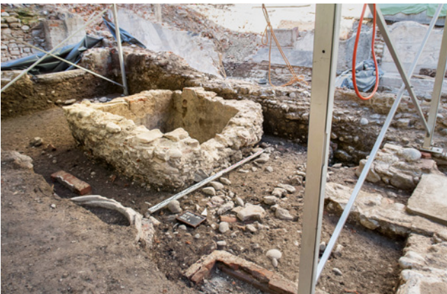
ABB. 13 Überblick vom Steinenbachgässlein auf die vier schmalen, in der Struktur mittelalterlichen Parzellen. Foto: Birgit Lißner.
