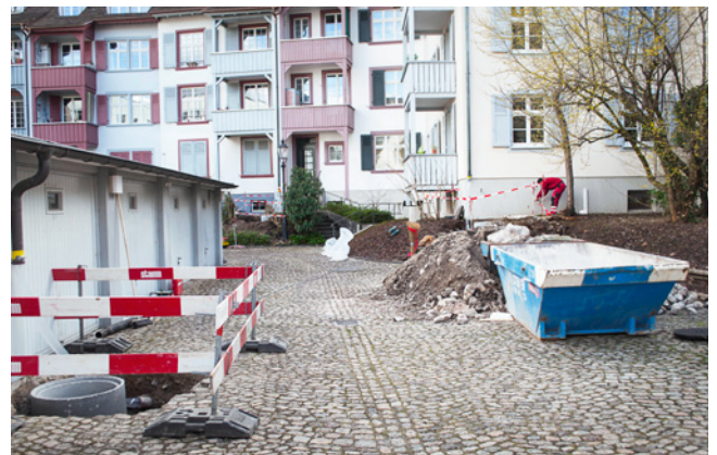
ABB. 36 Der Innenhof besteht in dieser Form erst seit dem Abbruch des grossen Lager- und Gewerbehäuses Platzgässlein 1, zu dem der aufgedeckte Keller wohl gehört hatte. Foto: Susan Steiner.
