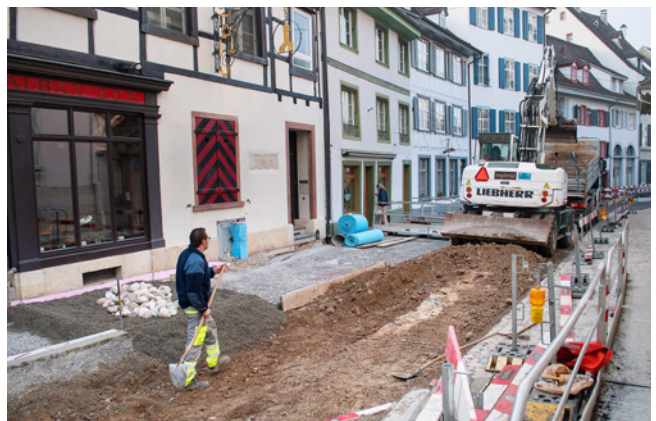
ABB. 16 Strassenmittig kam unter der Malzgasse eine aus Kalkbruch- und roten Buntsandsteinen errichtete Mauer zum Vorschein, die vereinzelt auch Baukeramikfragmente enthält. Es handelt sich um die Kontermauer der Vorstadtbefestigung aus dem 13. Jahrhundert. Foto: Susan Steiner.
