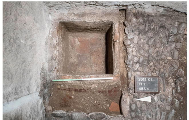
ABB. 26 Der sorgfältig gesetzte, sehr ebene Kieselboden des Kellers in der Haushälfte Heuberg 26. Oben rechts ist der noch zugemörtelte Schacht zu erkennen. Foto: Birgit Lißner.
