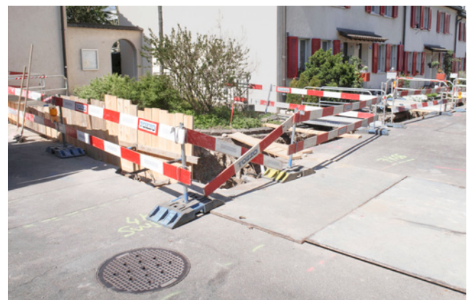
ABB. 40 Übersicht der Leitungsgräben, in denen der Keller angeschnitten wurde, und der Genossenschaftswohnhäuser, die das Landgut ersetzen. Foto: Michael Ketzler.
