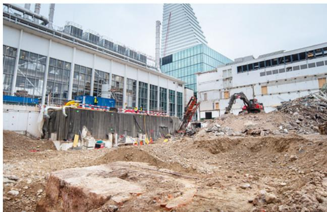
**ABB. 43** Blick in die Baugrube während des Rückbaus von Bau 49. Im Vordergrund das Fundament des Industrieofens des ehemaligen Rohmaterial-Bahnhofs der Badischen Bahn. Foto: Sven Billo.
