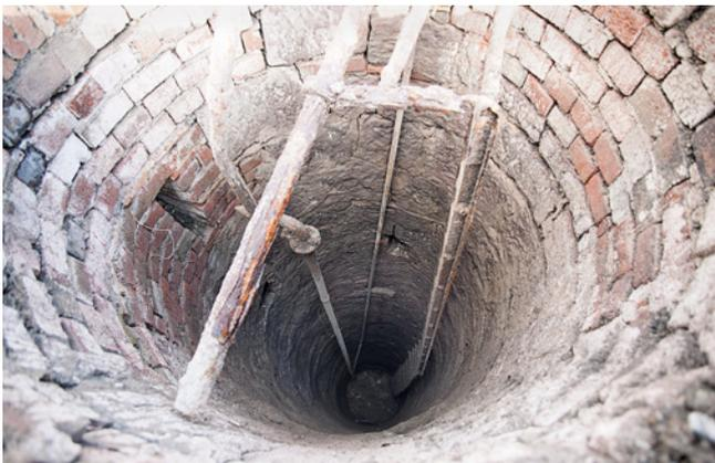
**ABB. 17** Blick in den Brunnen aus Backsteinen und roten Sandsteinen. Die Leitungen dürften nachträglich für die Nutzung als Sickerschacht eingebaut worden sein. Foto: Margit Dauner.
