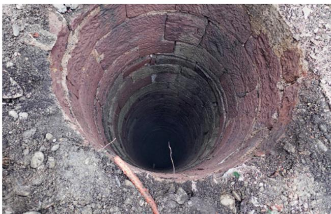
ABB. 23 Aufsicht auf den neuzeitlichen Sodbrunnen aus grossen Sandsteinquadern mit einem Innendurchmesser von 1,05 m und einer Tiefe von rund 16 m. Foto: Martin Allemann.
