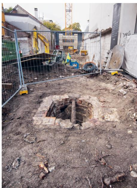
**ABB. 35** Ein etwa rechteckiges Mauerwerk aus Ziegeln bildet den obersten Teil des Brunnens. Foto: Christian Stegmüller.
