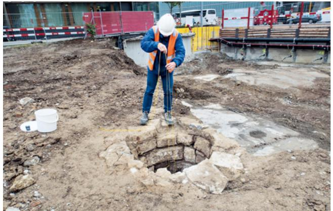
**ABB. 34** Filmaufnahmen des Brunneninnern mittels einer Kamera, die an Schnüren in den Schacht abgesenkt wird. Foto: Christian Stegmüller.
