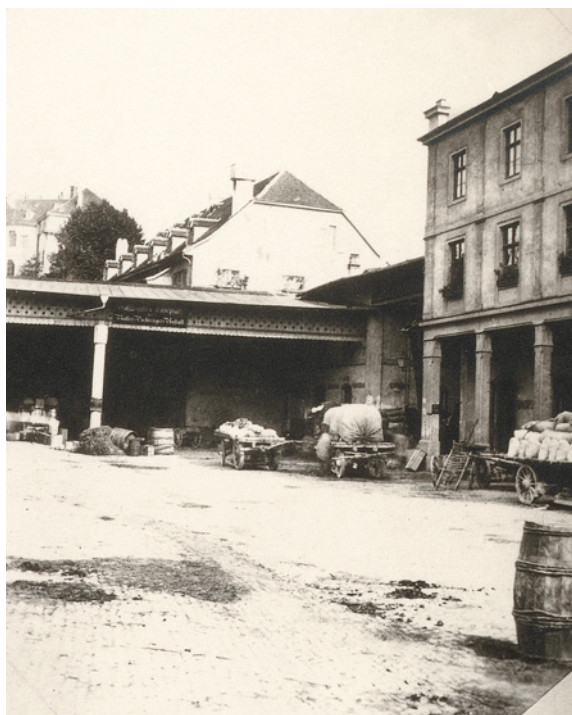
ABB. 8 Aufnahme vom Innenhof des Kaufhauses. Rechts im Bild die schlicht gehaltene Rückseite des Verwaltungsgebäude mit Pfeilerkolonnade. Das mondäne Äussere beschränkte sich auf die Fassade am Steinenberg. Foto: StABS, AL 45, 2-90-2.
