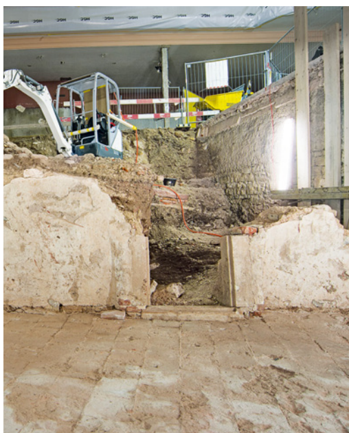
ABB. 19 Ein Stück des freigelegten Kreuzganges, der den Friedhofsbereich umgab. Das Mörtelbett der Tonplatten hat sich gut erhalten, ebenso die verputzte Rückwand mit einer Fensteröffnung. Foto: Benedikt Wyss.
