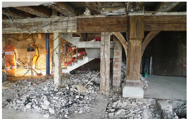
ABB. 1 Übersicht Richtung Rheinsprung im 3. UG: Im Vordergrund Holzbauteile der Kornschütte, im Hintergrund Bohrarbeiten zur Sicherung. Foto: Martin Allemann.
