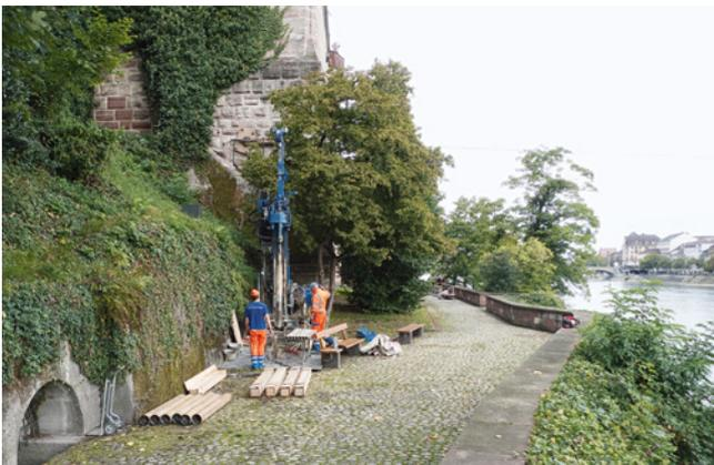
**ABB. 3** Übersicht nach Norden mit der mächtigen Pfalzstützmauer links und der Bohrmaschine für die Sondierungen. Entlang der unteren Stützmauer (rechts) wurden zudem kleine Handsondagen geöffnet. Foto: Martin Allemann.
