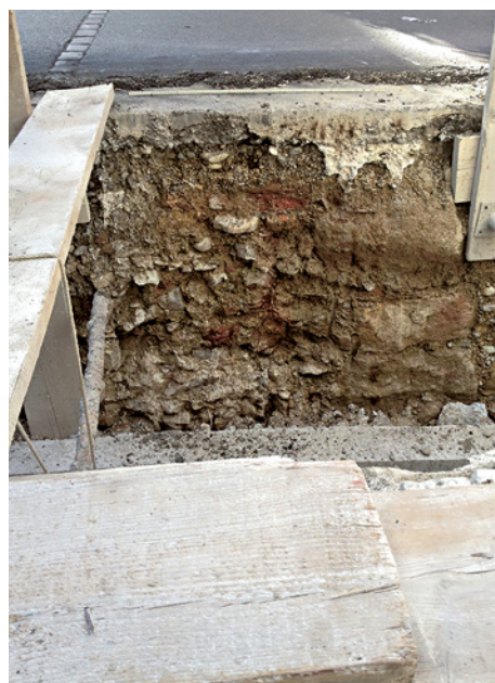
ABB. 11 Mitten in der Schneidergasse werden Reste der ehemaligen Bebauung sichtbar. Foto: Norbert Spichtig.
