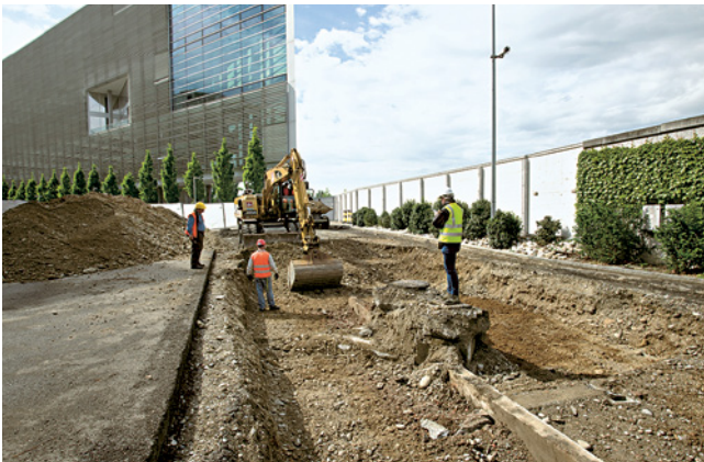
ABB. 31 Bereits beim maschinellen Voraushub werden natürliche, gelbe Lehme unter den modernen Auffüllungen erreicht. Foto: Margit Dauner.
