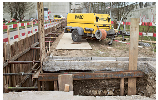
ABB. 35 Aushub eines Schachtes zwischen bestehendem Energieleitungstunnel und dem Gebäude WSJ-127. Foto: Benedikt Wyss.
