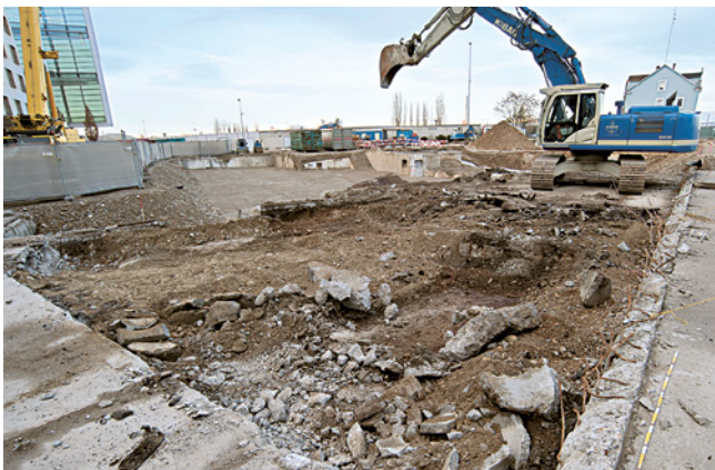
ABB. 37 Maschineller Abtrag der modernen Einbauten und Auffüllungen entlang der bereits bodeneben rückgebauten Arealmauer. Foto: Benedikt Wyss.
