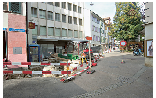
ABB. 22 Grabungssituation an der Ecke Gerbergasse / Rümelinsplatz. Foto: Christian Stegmüller.
