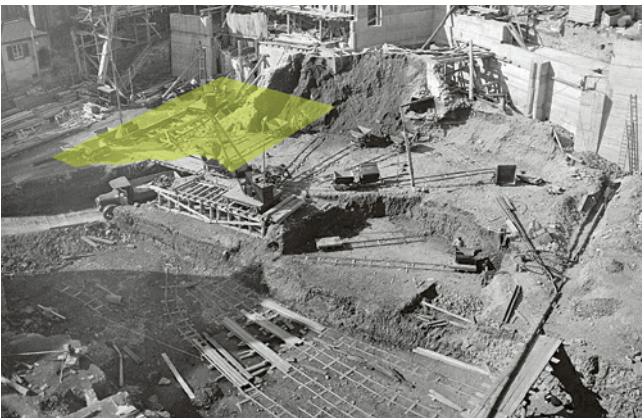
ABB. 15 Blick auf die Baugrube anlässlich der Erstellung des Spiegelhofes Ende der 1930er Jahre. Die Markierung umgrenzt die von der Umgestaltung betroffene Fläche. Foto: StABS Neg 05041, Bearbeitung: Peter von Holzen.
