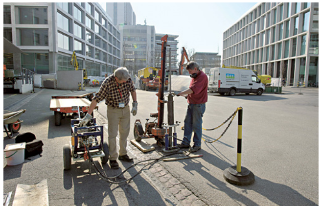
ABB. 30 Eine Rammkernsondierung wird im Bereich der ehemaligen Hünigerstrasse herausgezogen. Foto: Margit Dauner.
