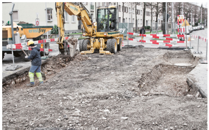
Abb. 38 Unter der entfernten Strassenkoffierung zeichnet sich in der Bildmitte das helle Band des mit Wandkies verfüllten Kanalisationsleitungs-Grabens ab, während in den übrigen Bereichen Abbruchschutt von Gebäuden des 19. Jh. liegt. Foto: Christoph Matt.
