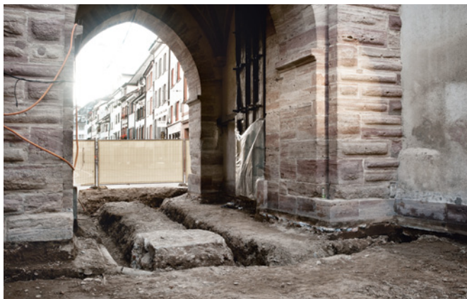
Abb. 28 Blick in die Torkammer und die offenen Leitungsgräben. Foto: Christian Stegmüller.
