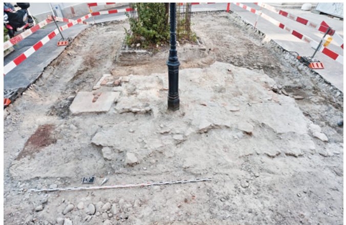
Abb. 4 Bis zur Umgestaltung des Martinskirchplatzes im Jahr 1851 stand hier der Martinsbrunnen. Sein Fundament hat sich bis heute unter der Platzoberfläche erhalten. Foto: Till Scholz.
