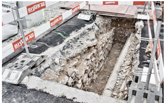
Abb. 25 Das unverputzte Fundamentmauerwerk eines Hauses aus dem 19. Jh. Foto: Christoph Matt.
