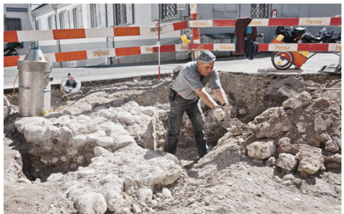
Abb. 5 Das Fundament des Anbaus an den Kleinen Eptingerhof wird durch Roman Rosenberger freigelegt. Foto: Marco Bernasconi.
