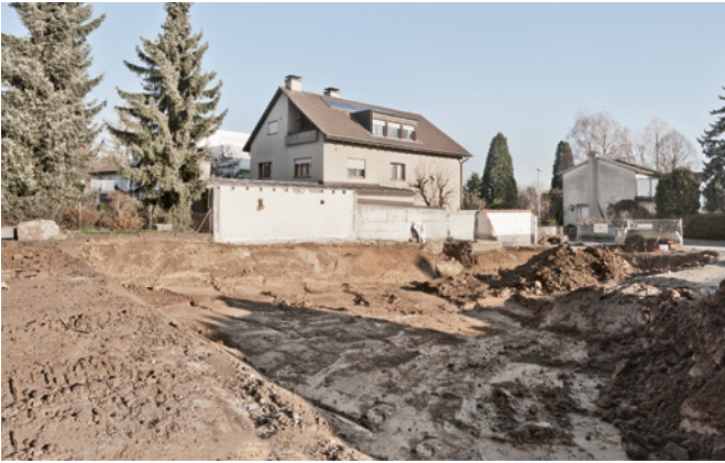
Abb. 46 Blick auf das Aushubgelände. Foto: Christian Stegmüller.
