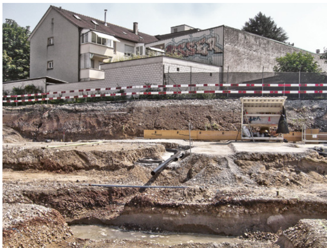
Abb. 41 Blick in die Baugrube. Die hinten sichtbaren Baugrubenwände bestehen zum grössten Teil aus modernen Anschüttungen. Foto: Christoph Matt.
