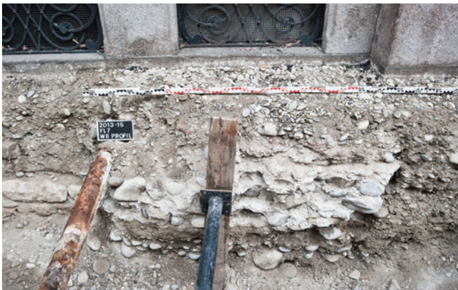
Abb. 24 Dieser Fundamentstummel blieb vom Vorgängerhaus des Restaurants zur Mägd übrig, weil die neue Baulinie nach Westen verschoben wurde. Foto: Christian Stegmüller.
