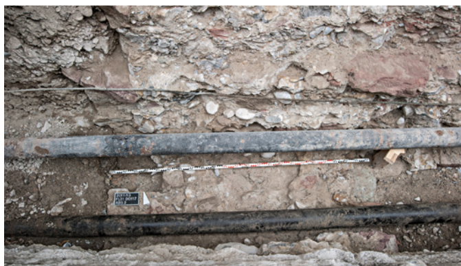
Abb. 36 Was vom Spalenschwibbogen übrig blieb: Das über 2 m mächtige Frontmauer-Fundament (unter dem Massstab) ist neben den Leitungen noch bis unters Trottoir erhalten. Foto: Christian Stegmüller.
