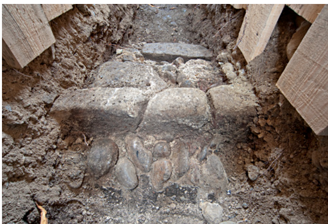
Abb. 5 Südlich des Kirchturms freigelegtes Schalenmauerwerk mit zerbrochener Schwelle. Foto: Jan Baur.
