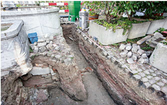
Abb. 25 Die rötlichen Planien vorwiegend aus Sandstein-Bauabfällen können dem Bau des Blauen Hauses zugeschrieben werden. Die Sandsteinblöcke gehören zum Fundament des Brunnens. Foto: Fredy von Wyl.
