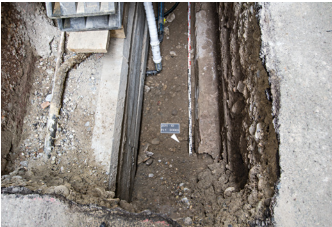
Abb. 34 Blick auf die Baustelle: am rechten Grubenrand die eine Wange des freigelegten Abwasserkanals aus dem 18./19. Jahrhundert. Foto: Christian Stegmüller.
