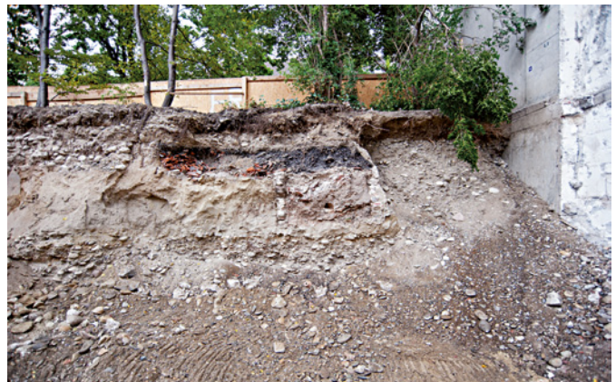
Abb. 40 Das spätmittelalterlich-frühneuzeitliche Kellerchen. Von links stösst das Fundament der Arealmauer an, über dem Keller liegt eine dunkle Schicht mit fabrikzeitlichem Material, rechts anschliessend die verfüllte Baugrube des benachbarten grossen Einkaufsmagazins. Foto: Martin Block.
