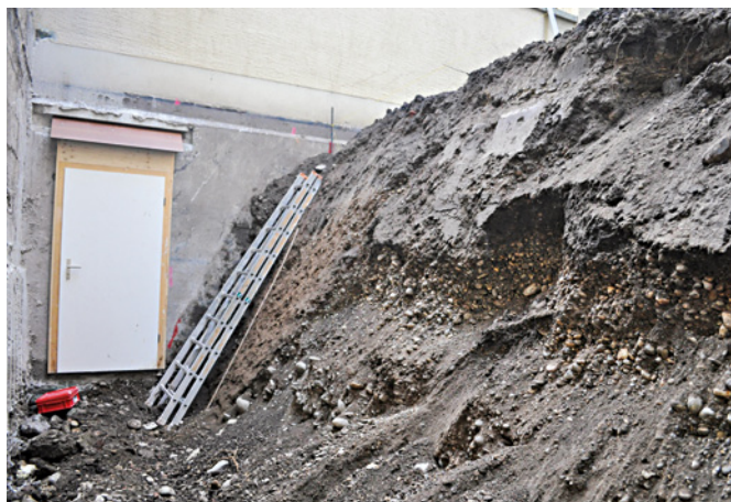
Abb. 48 Der ausgehobene Graben, aus dessen oberen Planieschichten die Skelettfunde stammen. Foto: Christoph Matt.
