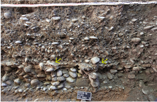
Abb. 13 Die keltische Strasse auf den Münsterhügel: Über einen mächtigen Koffer aus Geröllen war eine Schicht aus Kalkguss (Pfeile) aufgebracht worden. Die Strasse wurde so überaus fest und wetterbeständig. Die Technik stammt vermutlich aus dem Mittelmeerraum. Foto: Jan Baur.
