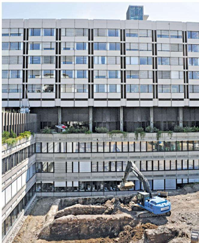
Abb. 45 Die vom Bagger freigelegten Fundamente des alten Spitals aus den Jahren 1838–42. Foto: Christoph Matt.
