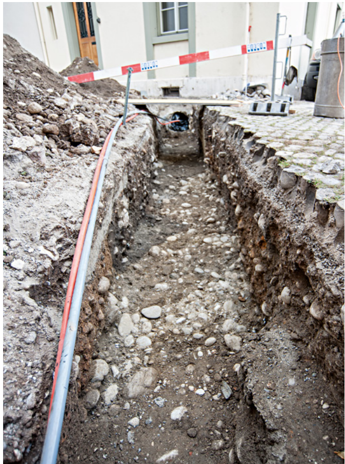
Abb. 26 Auf der Grabensohle werden die vicus -zeitlichen Strukturen sichtbar. Foto: Fredy von Wyl.
