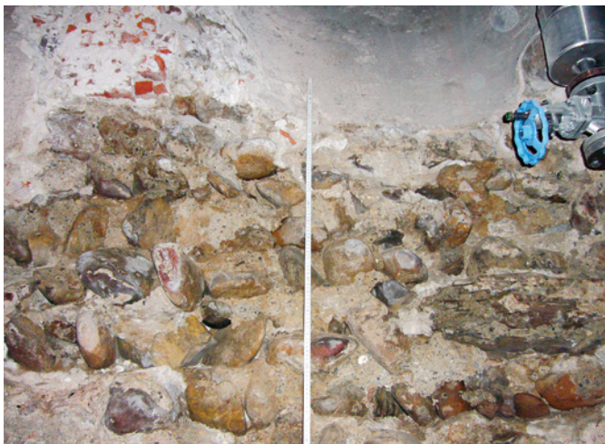
Abb. 48 Die Burkhardtsche Stadtmauer auf der Stadtinnenseite an der durch einen Fensterschacht gestörten Stelle. Foto: Christoph Matt.
