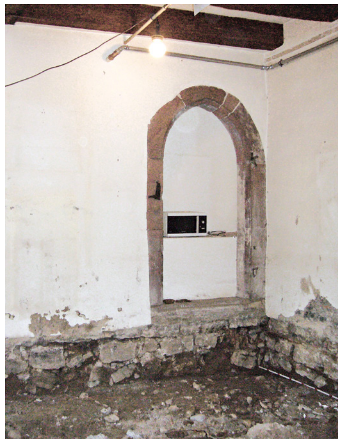
Abb. 55 Nordöstlicher Raum im Gebäude der Rheinpolizei mit abgetieftem Boden und einem ins Kleine Klingental führenden gotischen Portal (Blick nach Nordwesten). Foto: Christoph Matt.
