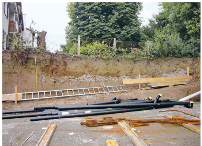
Abb. 92 Blick auf die Baugrubenböschung mit der in die Profilwand auslaufenden Magerbeton-Unterlage eines Schwimmbassins. Foto: Christoph Matt.
