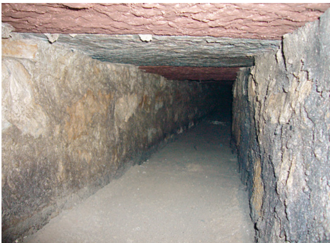
Abb. 47 Der unverfüllte Abwasserkanal am südlichen Ende der Aeschenvorstadt. Foto: Lukas Scherer.
