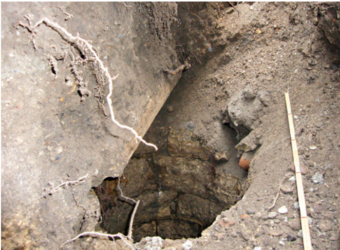
Abb. 46 Der mit Kalkplatten abgedeckte Sickerschacht. Rechts hinten mündet ein rötliches Steingutrohr. Foto: Christoph Matt.
