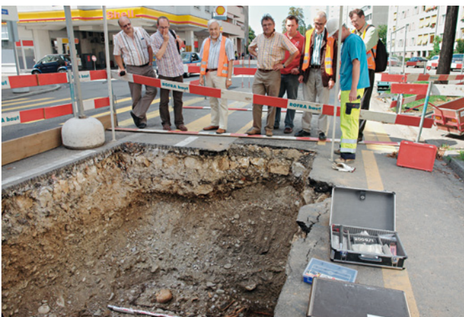
Abb. 86 Die Bauleitung zu Besuch auf der Baustelle nahe der Kreuzung Kleinhüningeranlage/Weilerweg: Zu ihren Füßen das beigabenlose, weil wahrscheinlich geplünderte Grab 280. Foto: Maja Viazzoli.
