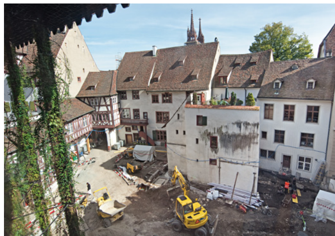
Abb. 21 Das Grabungsgelände im Schürhof-Areal. Von links nach rechts: Münsterplatz 20 (Rollerhof), Münsterplatz 19 (Schürhof), Schlüsselberg 17 (Burghof), Schlüsselberg 15 und Schlüsselberg 13. Foto: Sven Straumann.
