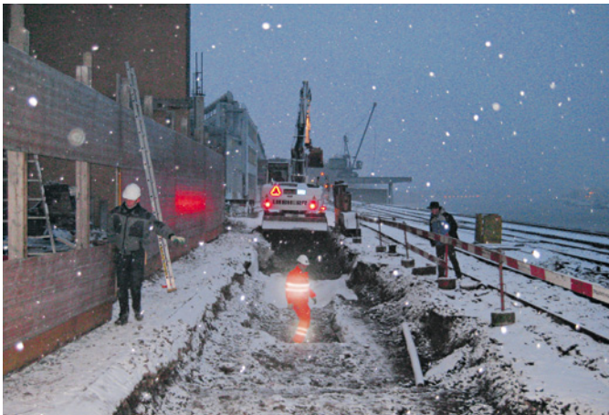
Abb. 71 Maschineller Voraushub im Schneetreiben während der Dämmerung. Foto: Norbert Spichtig.
