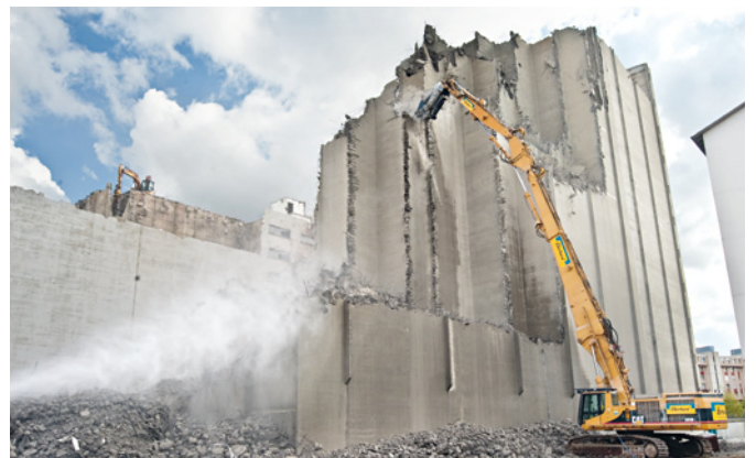
Abb. 70 Die gleiche Stelle wenige Monate später nach geglückter Blockbergung: das über 50 m hohe Ultra-Brag-Silo wird abgebrochen. Foto: Denise Grossenbacher.
