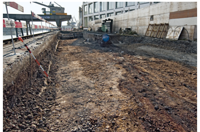
Abb. 84 Die schwärzlichen, unregelmässigen Strukturen aus kohlehaltigen und stellenweise grau-kiesigen Materialabfolgen im Bildzentrum zeugen von Schuttdeponien im 19. Jahrhundert. Zum Bau des Rheinweges St. Johann hatte der Grosse Rat die Bevölkerung aufgefordert, Material aufzuschütten. Foto: Denise Grossenbacher.
