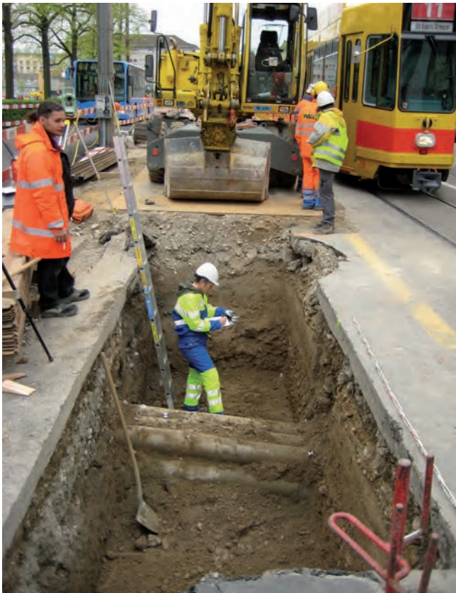
Abb. 4 Elsässerstrasse (A), Kanalisation Lichtstrasse–Votaplatz, 2007/63. Blick nach Süden. Baubegleitende Profildokumentation im oberen Teil des noch unverspriessten Kanalisationsgrabens. – Foto: Adrian Jost.
