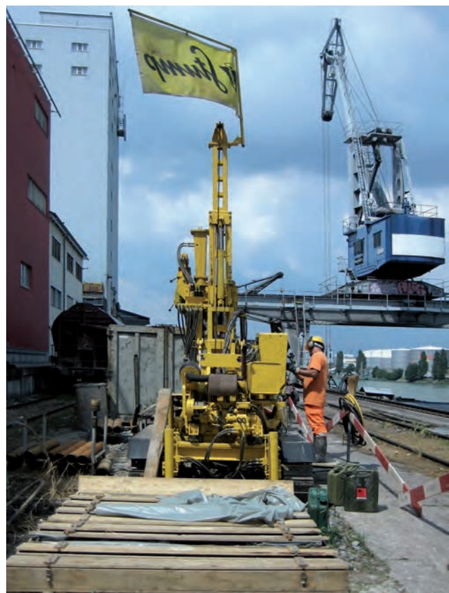
Abb. 8 Rheinhafen St. Johann, Rammkernsondierungen, 2008/9. Blick nach Norden. Bohrsondierung bei laufendem Hafenbetrieb, im Vordergrund die Holzkästen für die Hohlkerne. – Foto: Adrian Jost.
