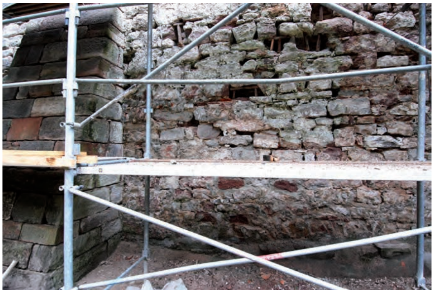
Abb. 5 Mühlenberg 12 / St. Alban-Vorstadt 65, 69, 71. Ausschnitt von Teil 2 der Mauer mit Strebepfeiler. – Foto: Bernard Jaggi.
