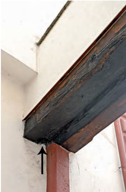
Abb. 4 Tor zur Vesalgasse zwischen den Häusern Spalenvorstadt Nr. 14 und 16. Auf der Torrückseite sind an der Unterseite des Balkens die Löcher für die Angeln der Torflügel zu sehen. Die Torflügel wurden vermutlich 1883 ausgebaut. – Foto: Stephan Tramèr.
