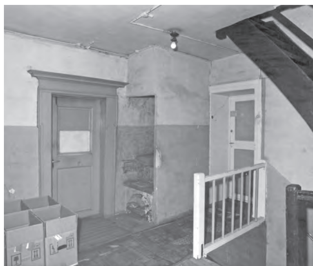
Abb. 4 Unterer Heuberg 7. Treppenhauszone mit Feuerstelle im 2. OG des schmalen Hausteils. Blick zu barocker Türe (wohl 1711) zum strassenseitigen Raum. Rechts die Türe zum breiten Hausteil West, davor die Treppenläufe vom 1. OG bzw. ins 3. OG (ehemals DG). – Foto: Christoph Teuwen, 1978, Archiv DPFBS.
