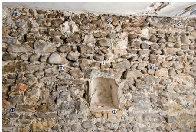
Abb. 9 Klosterberg 9. EG, Ostbrandmauer mit originaler Lichtnische im vorderen Hausbereich. Links der Nische sieht man Brand-schäden: Verfärbungen und gespaltene Steine. – Foto: Hans Ritzmann.
