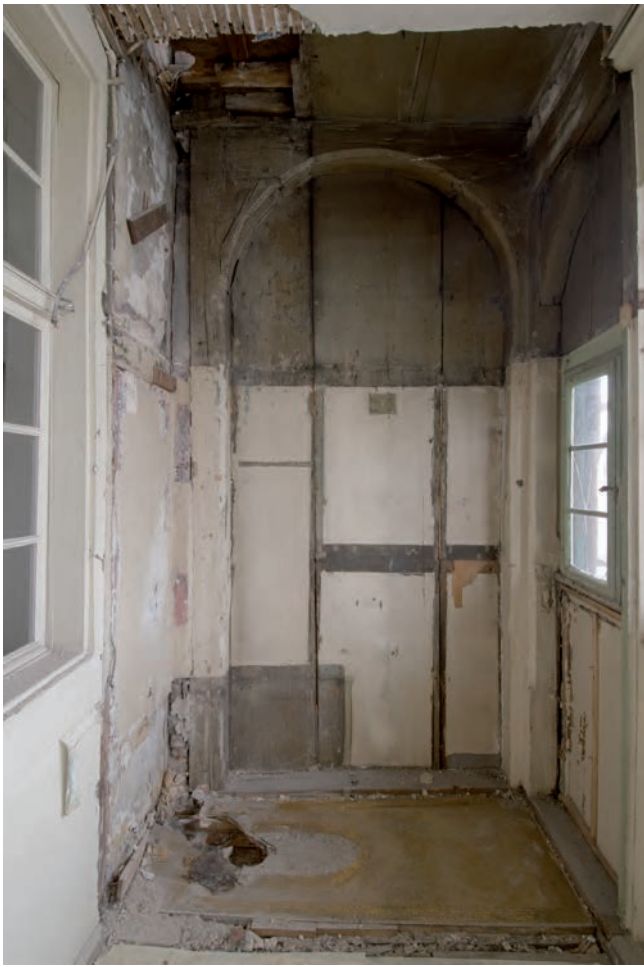
Abb. 26 Blumenrain 28. Rahmengerüst der Laube im 1. OG (rheinabwärts gewandte Seite). Der seitliche Rahmen besteht aus sich bis ins 2. OG ziehenden Ständern und bildet unter dem 2. Laubenboden einen dekorativen Rundbogen (siehe Kapitel 3.18). Ein ursprünglich vorhandener Brüstungsriegel wurde später entfernt. Die Laube war einst nicht nur vorne, sondern auch zur Seite hin offen; das Nachbarhaus Nr. 30 hatte hier damals noch keine Laube. – Foto: Conradin Badrutt.
