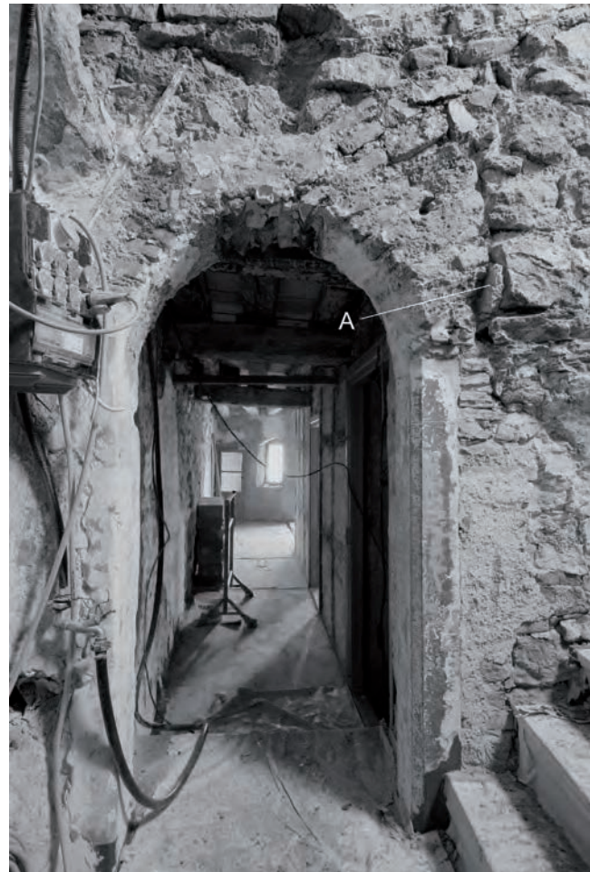
Abb. 15 Blumenrain 28. Eingeflickte Rundbogentür B im Mauerzug A (Freilegung an der Binnenmauer im strassenseitigen Hausteil, 1. UG). Rechts des Rundbogens ist ein Putzflächenfragment (A) der rechten Leibung der ursprünglichen Öffnung erkennbar (siehe Kapitel 3.1). Der Einbau des Rundbogens stört und vermauert die ältere, höher gelegene Öffnung (siehe Kapitel 3.2). Das rechte Gewände der Rundbogentür wurde später ersetzt. – Foto: Conradin Badrutt.
