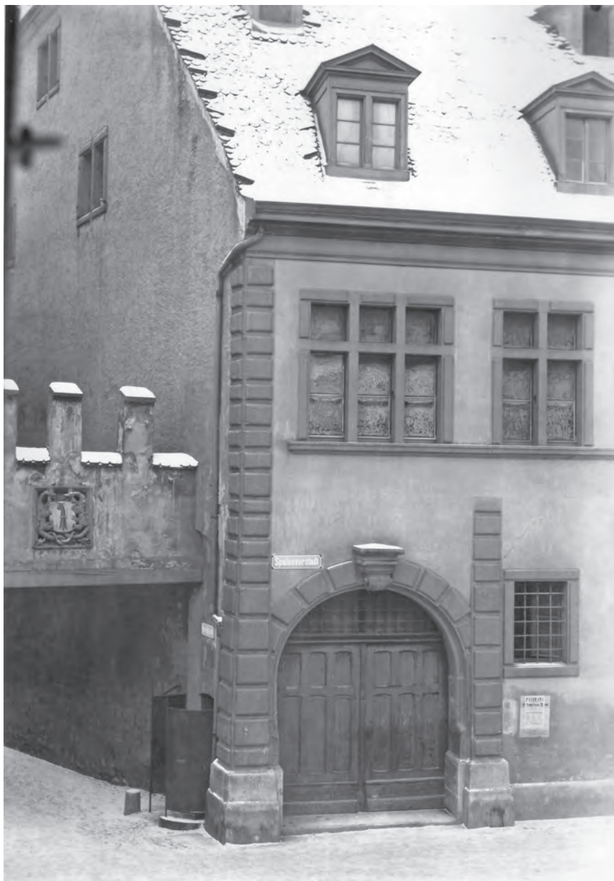
Abb. 7 Tor zur Vesalgasse zwischen den Häusern Spalenvorstadt Nr. 14 und 16. Das Tor kurz vor 1900. Noch ist die originale und ziemlich verwitterte Reliefplatte aus Sandstein von 1652 mit einem gemalten Baselstab vorhanden. Die Platte wurde 1916 durch eine Kopie ersetzt. Das originale Relief wird im Historischen Museum Basel aufbewahrt. Das «Mueshus» ist noch nicht zum Ladengeschäft umgebaut. Beim Torpfeiler ist ein Pissoir eingerichtet. – Foto: Archiv DPFBS.
