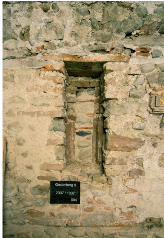
Abb. 13 Klosterberg 9, EG, Westbrandmauer. Originales Schartenfenster mit Sturzbrett über der Fensternische. Der Fensterschlitz ist deutlich schmaler und niedriger als die Nische. Im unteren Teil vermitteln Werkstücke aus Buntsandstein zwischen den Leibungen der Nische und des Fensterschlitzes. Die Einzüge sind breiter als die Falze, was vermuten lässt, dass der Verputz der Nischenwände vor allem links leicht trichterförmig und bündig mit den Falzen aufgemörtelt war. – Foto: Matthias Merki.
