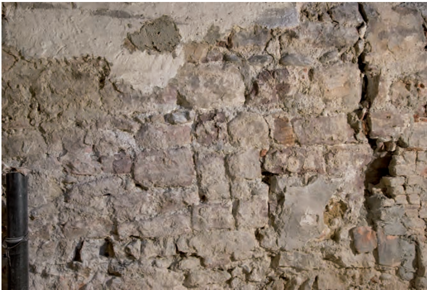
Abb. 7 Blumenrain 28. Äusseres Mauerbild des quer zum Fluss stehenden Abschnitts der Uferbefestigung A (Freilegung im 3. UG). Das lagige Mauerwerk besteht hier fast ausschliesslich aus grossen Bruchsteinen. Rechts die rheinseitige Abrisslinie, an die das Mauerwerk des Baukörpers C anschliesst. – Foto: Conradin Badrutt.
