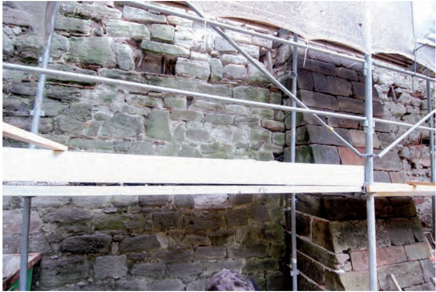
Abb. 4 Mühlenberg 12 / St. Alban-Vorstadt 65, 69, 71. Ausschnitt von Teil 1 der Mauer mit Strebepfeiler. – Foto: Bernard Jaggi.
