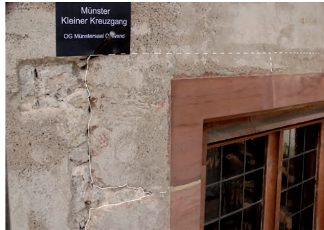
Abb. 4 Münster, Münstersaal-Ostfassade. Wandsondierung links des Sturzes beim mittleren Fenster. Die weissen Linien umreissen die im originalen Mauerwerk eingefügten Werkstücke. Die Schrägen zwischen den äusseren und dem mittleren Sturzstück bewirken eine Versperrung des Drucks von oben wie bei einem Entlastungsbogen. Im Bild sieht man die linke der beiden spiegelbildlichen Schrägen. – Foto: Matthias Merki.
