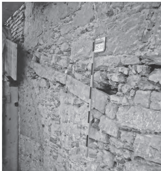
Abb. 19 Schützenmattstrasse 56. Sandsteinwerkstücke des ehemaligen Abwasserkanals aus dem Lavabo im Schützensaal (siehe Abb. 11 und 18). – Foto: Bernard Jaggi.
