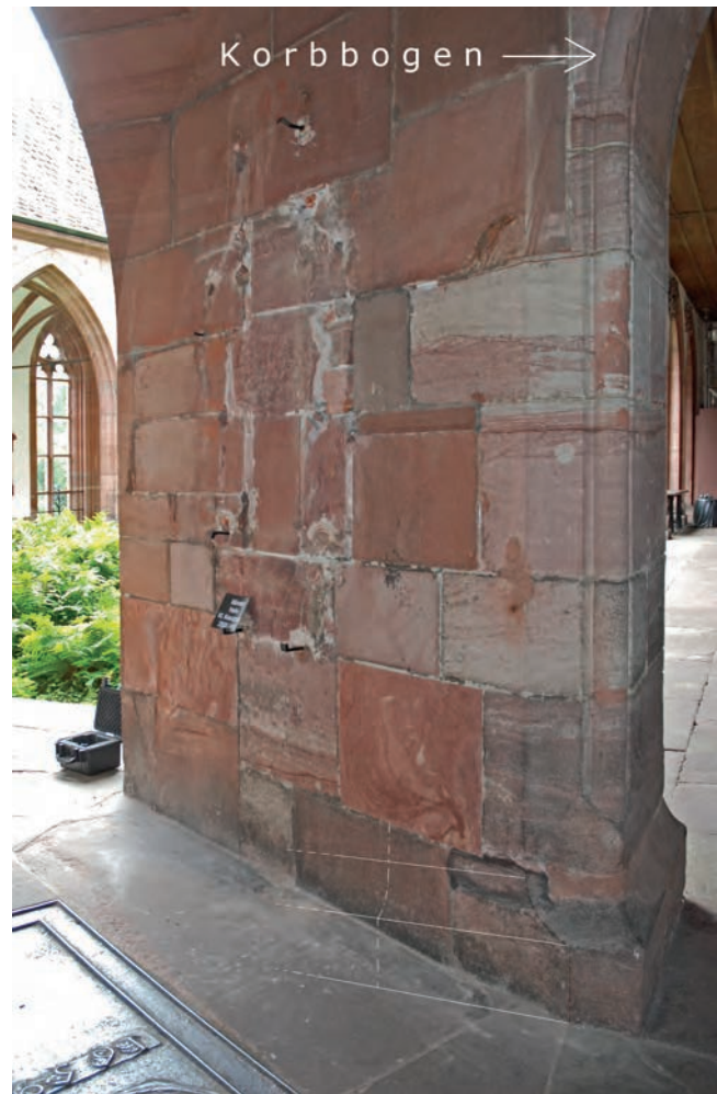
Abb. 4 Münster. Durchgang von der Halle zum kleinen Kreuzgang. Blick Richtung Osten zum kleinen Kreuzgang. Rechts die Nordwestecke des Pfeilers. Mit weißen Linien ist der ursprüngliche Verlauf der Sockelzone mit der Schmiege eingezeichnet (siehe Abb. 3, ursprünglicher Grundriss des Pfeilers). – Foto: Matthias Merki.
