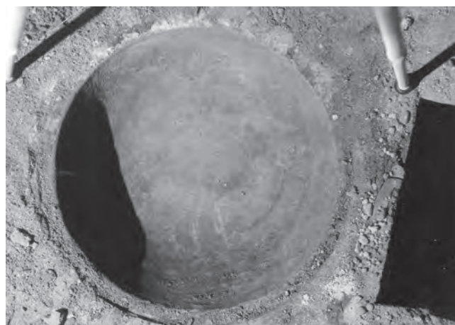
Abb. 12 Unterer Heuberg 7. Haus West, Keller. Sandsteinsammelbecken in der Mitte des abgesenkten Bodens. Das halbkugelförmig aus einem Werkstück ausgeschlagene Becken diente der Aufnahme von Schmutz und Oberflächenwasser und musste periodisch ausgeschöpft werden. – Foto: Bernard Jaggi, 1978, Archiv DPFB.
