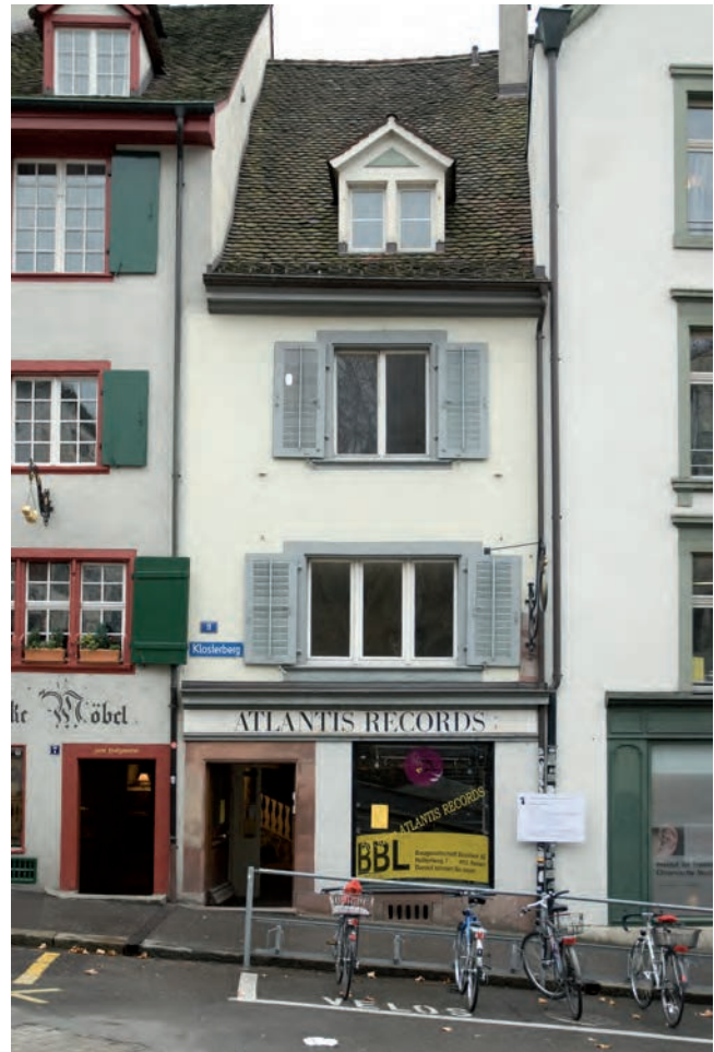
Abb. 2 Klosterberg 9. Strassenfassade, Zustand vor dem Umbau 2007/08. – Foto: Matthias Merki.
