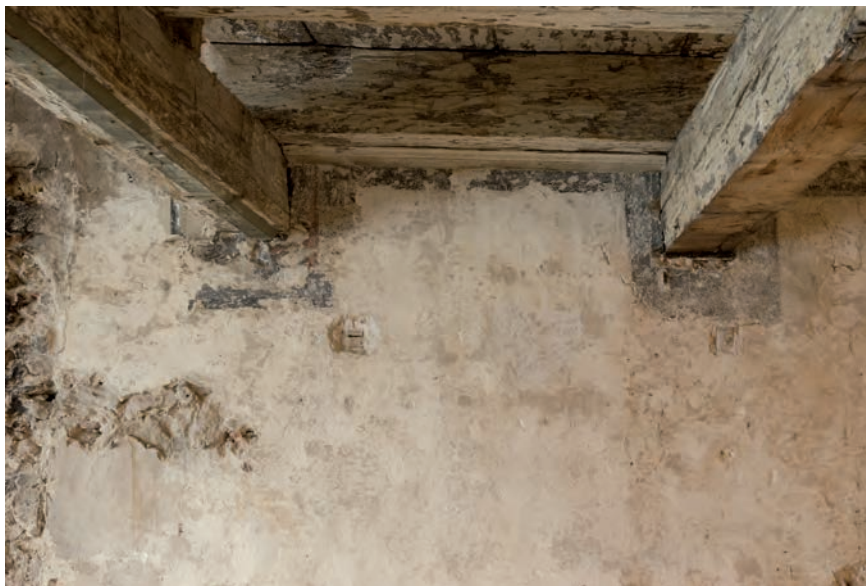
Abb. 24 Blumenrain 28. Bandfassungen an den Unterzügen des alten, rheinseitigen Dachwerks (Freilegung an der südlichen Brandmauer im rheinseitigen 2. OG). Ältere Malerieste mit schwarz umgrenztem Rotband fanden sich nicht nur als erste Fassung am ursprünglichen Dachwerk, sondern auch am rheinseitigen, nachträglich eingebauten Unterzug (links) von 1606 (siehe Kapitel 3.17). Der rechts daneben liegende Unterzug erhielt beim Einbau um 1647 wiederum dieselbe Fassung (siehe Kapitel 3.18). Mit der Bemalung der ganzen Decke um 1675 erhielten alle Unterzüge eine Umrahmung mit Grauband (siehe Kapitel 3.19). – Foto: Bernard Jaggi.
