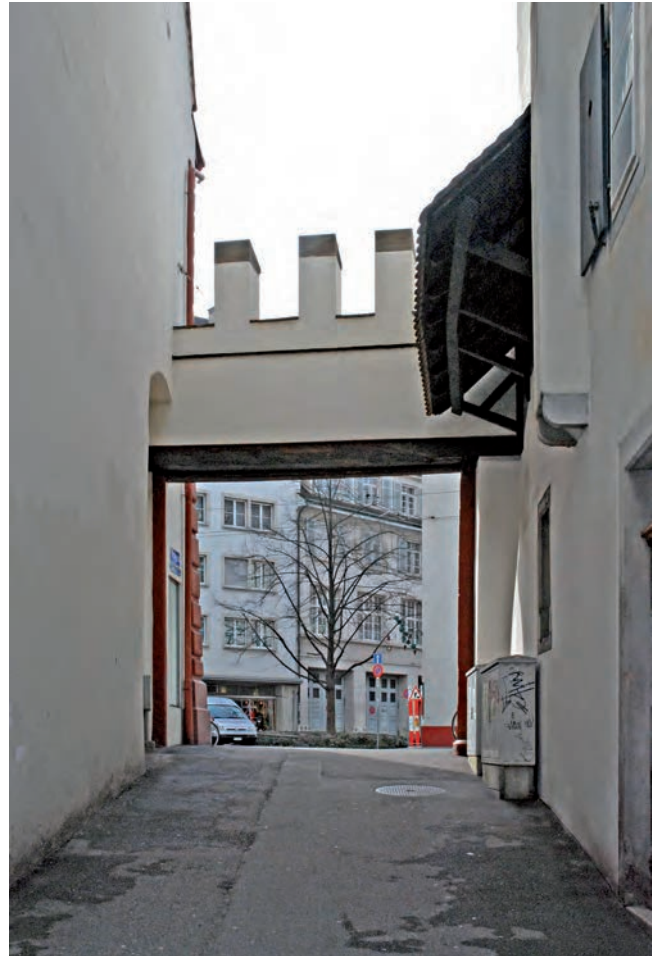
Abb. 6 Tor zur Vesalgasse zwischen den Häusern Spalenvorstadt Nr. 14 und 16. Blick von der Vesalgasse hinauf zur Spalenvorstadt. Zu sehen ist die Torrückseite. Links in der Giebelwand des «Mueshus» gibt es zum Schutz des einen Torflügels vor Witterungseinflüssen eine Aussparung. Rechts ist für den andern Flügel entsprechend an die Giebelmauer von Haus Nr. 16 ein Klebedächlein montiert. – Foto: Stephan Tramèr.
