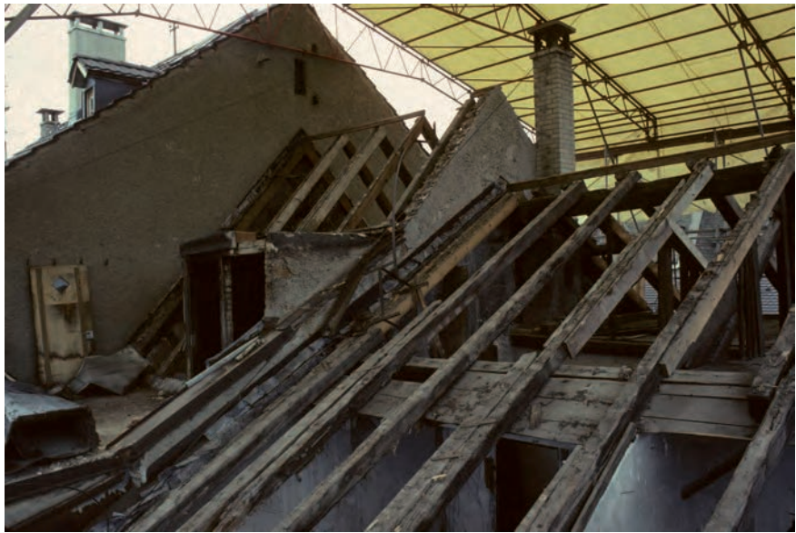
Abb. 19 Unterer Heuberg 7. Dächer der beiden Hausteile West und Ost. Dem steileren Sparrendach von Haus Ost wurden 1841 auf beiden Seiten Dachterrassen vorgelagert. Dabei entstand gleichzeitig ein drittes OG. Der Ausstieg auf die gartenseitige Dachterrasse befindet sich auf Kehlbalkehöhe. Die meisten Hölzer der alten Dachkonstruktionen wurden 1979 ersetzt. – Foto: Bernard Jaggi, 1978, Archiv DPFBS.
