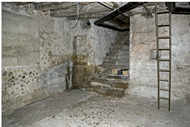
Abb. 8 Klosterberg 9. Keller, Blick gegen die Hausmitte mit dem breiten Abgang und den beiden originalen untersten Sandsteinstufen. Rechts des Abgangs die kleine, originale Lichtnische, links die sekundäre, neuzeitliche Schranknische. Links aussen die moderne, betonierte Vormauerung, in deren unteren, feuchten Zone wegen der abgebröckelten Oberfläche auch grössere Kieselsteine zum Vorschein kommen. – Foto: Matthias Merki.
