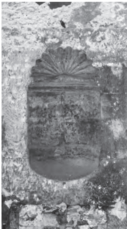
Abb. 18 Schützenmattstrasse 56. Originale Lavabonische in der Ostwand zwischen den Fenstern über dem Portal. – Foto: Alfred Abegg-Metbauer, 1961, Archiv DPFBS.
