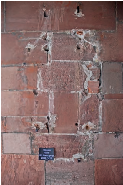
Abb. 6 Münster. Durchgang von der Halle zum kleinen Kreuzgang. Grobe Meisselhiebe lassen vermuten, dass die zu einer späteren Zumauerung gehörenden fünf Quader im eingebauten Zustand auf die Wandflucht zurückgeschlagen wurden. – Foto: Matthias Merki.
