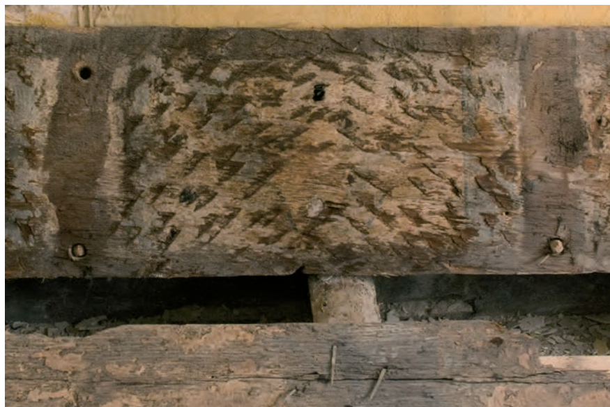
Abb. 25 Blumenrain 28. Bodenbrett des dritten Geschossbodens im strassenseitigen Hausabschnitt (Untersicht eines gelösten Bretts im heutigen 3. OG). Die mit Holznägeln befestigten Bretter gehören vermutlich zum ursprünglichen Boden von 1335 (siehe Kapitel 3.3). Die viel jüngere Deckenbemalung zeigt Graubänder und zusätzlich rautenförmige Felder (siehe Mitte). Die Malerei könnte im Rahmen des Umbaus von 1587 entstanden sein (siehe Kapitel 3.16) und ist heute durch die Täfeldecke im 2. OG verdeckt. – Foto: Bernard Jaggi.
