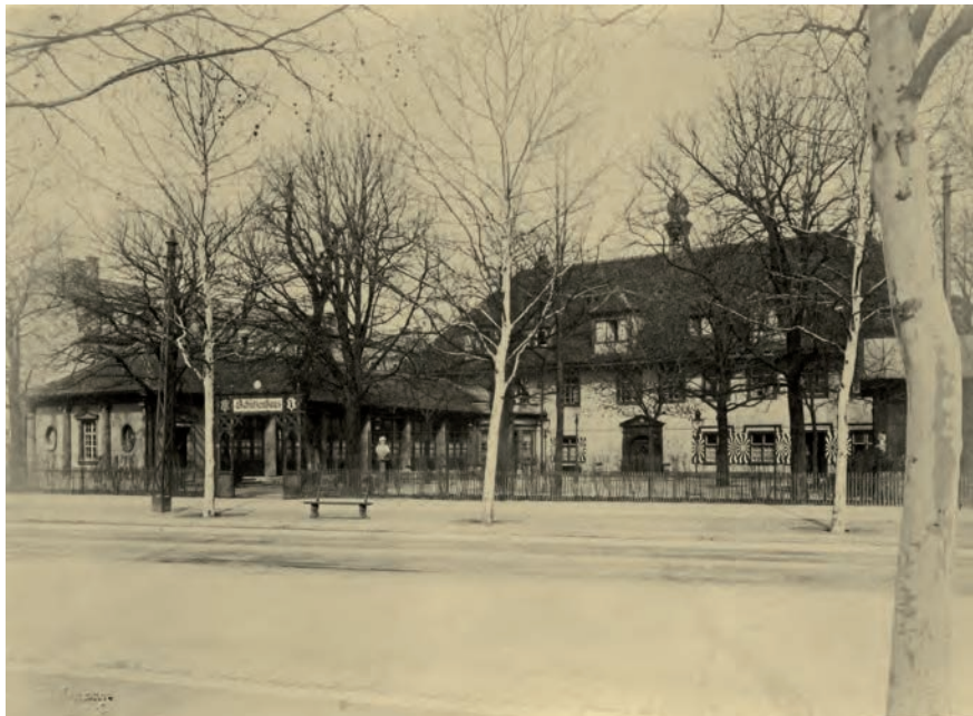
Abb. 7 Schützenmattstrasse 56. Ansicht von Südwesten. Rechts der 1916 nach Norden (links) erweiterte Altbau mit drei nicht mehr erhaltenen Dachhäusern unter Walmdächern; links der gleichzeitig angebaute Gartensaal. – Foto: A. Teichmann, um 1918, Archiv DPFBS.
