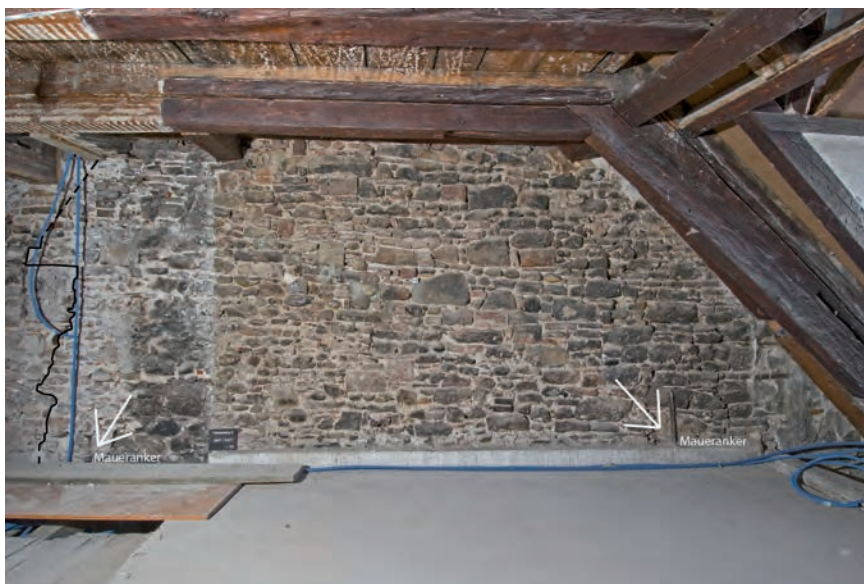
Abb. 16 Klosterberg 9. Erstes DG, Westbrandmauer. Strassenseitiger Teil des Brandmauerschildes, der wahrscheinlich nach dem grossen Brand mit wiederverwendeten Steinen neu errichtet werden musste. Der linke Pfeil weist auf den mittleren, der rechte auf den strassenseitigen Maueranker. – Foto: Philipp Ryffel.
