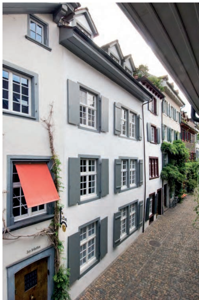
Abb. 2 Unterer Heuberg 7. Die beiden Fassaden am Unteren Heuberg. Links das breitere Haus West mit einfachen und doppelten Rechteckfenstern auf zwei Achsen sowie drei Dachlukarnen. Rechts das schmalere Haus Ost mit dem Hauseingang, dem spätgotischen Dreierfenster darüber und dem im 19. Jh. aufgestockten obersten Geschoss, das die Plattform für die Dachterrasse bildet. – Foto: Piero Knecht, 2010.
