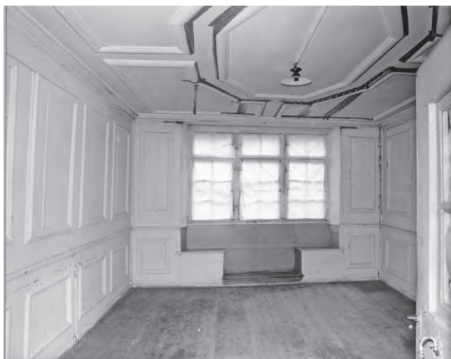
Abb. 3 Unterer Heuberg 7. Zimmer im 1. OG des schmalen Hausteils. Die barocke Vertäfelung an Wänden und Decke war 1978 weiss gestrichen. Gegen die Strassenseite das dreiteilige spätgotische Fenster mit Sitzbänken. – Foto: Christoph Teuwen, 1978, Archiv DPFBS.
