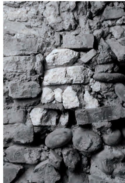
Abb. 7 Lindenberg 17/19. Detailansicht der nördlichen Hofmauer. Die Kalkmörtelformsteine sind optisch hervorgehoben. – Foto: Matthias Merki.
