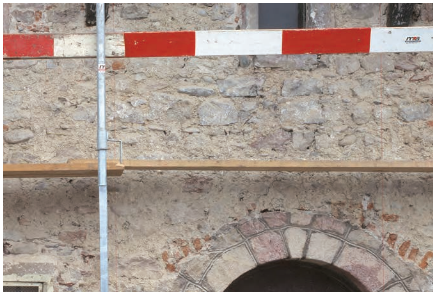
Abb. 18 Blumenrain 28. Mauerbild des Mauerwerks C des rheinseitigen Baukörpers von 1335 (Freilegung an der rheinseitigen Aussenwand, 2. UG). Das Mauerwerk ist eher ungleichmässig, aber dennoch lagig gemauert. Baukeramik wurde fast ausschliesslich in den Gewänden und Entlastungsbögen verwendet. – Foto: Conradin Badrutt.
