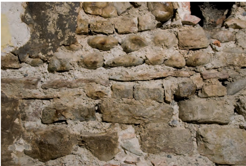
Abb. 8 Blumenrain 28. Mauerbild der Uferbefestigung A an der inneren, der Stadt zugewandten Seite (Freilegung an der Binnenmauer im strassenseitigen Hausteil, EG). Oberhalb der hier horizontal durchziehenden Arbeitsfuge fanden neben Bruchsteinen vermehrt Flusswacken Verwendung. – Foto: Conradin Badrutt.
