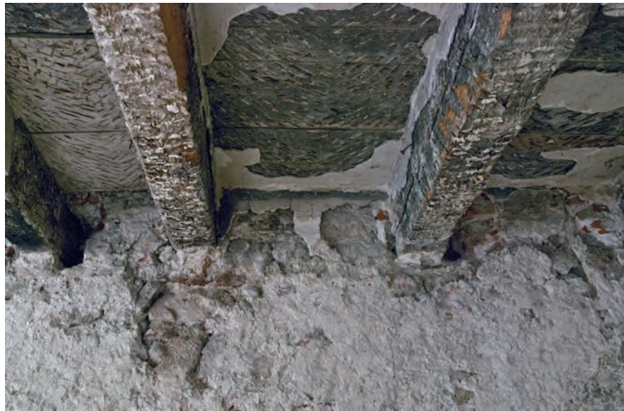
Abb. 15 Unterer Heuberg 7. Haus West, EG, strassenseitiger Raum. Graue Deckenbemalung ohne Rahmenfassung. Einzig die Wandfelder zwischen den Balken zeigen graue Fassungen. Später wurden die Holzoberflächen zwecks Verputzung aufgebeilt. Die Deckenbalken von 1383 sind in die mittelalterliche Brandmauer eingebrochen. – Foto: Bernard Jaggi, 2008.
