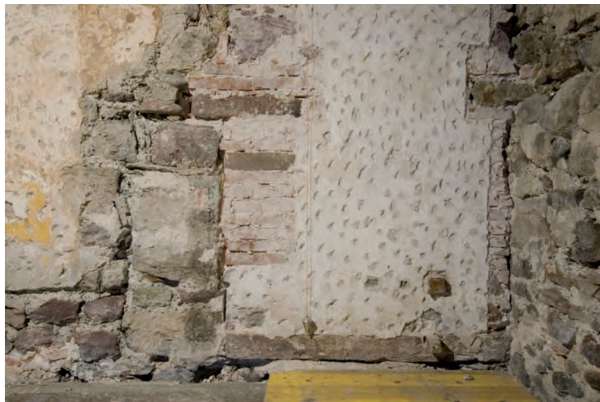
Abb. 12 Blumenrain 28. Einstige Türöffnung im Mauerwinkel des Mauerzugs A (Freilegung an der Binnenmauer im rheinseitigen Hausteil, EG). Das links sichtbare, nach aussen hin liegende Gewände besteht aus grösseren Sandsteinen. Oben zeichnet sich die Position des einstigen Sturzes ab (siehe Kapitel 3.1). – Foto: Conradin Badrutt.
