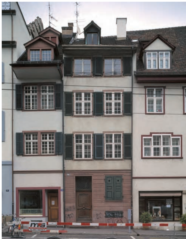
Abb. 2 Blumenrain 28. Die viergeschossige, barocke Strassenfassade vor dem aktuellen Umbau. Die Eingangstür wurde bei der Korrektur des Blumenrains um 1938 nach unten versetzt (siehe Kapitel 3.22). – Foto: Conradin Badrutt.
