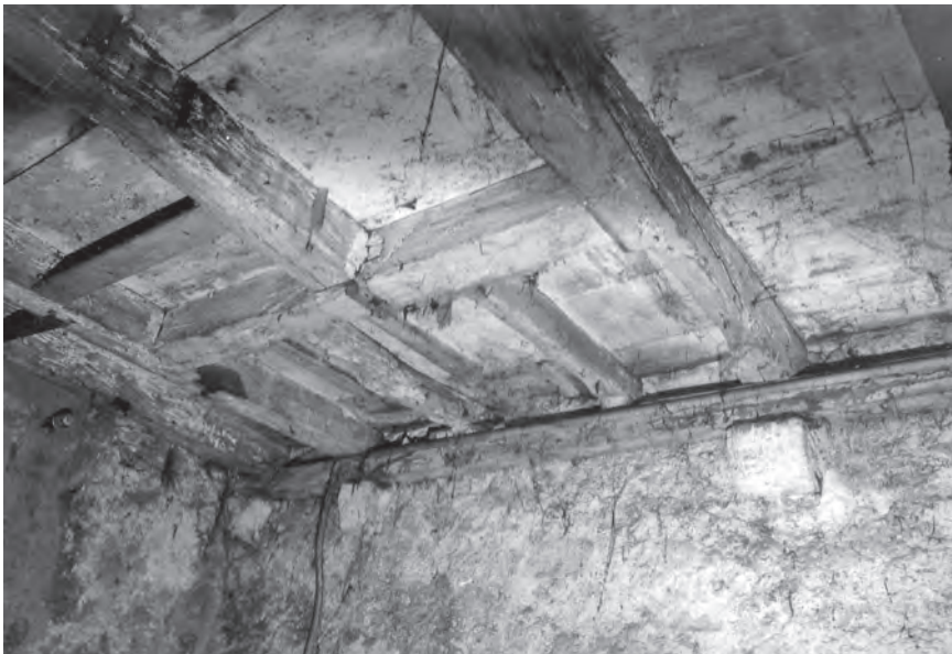
Abb. 18 Unterer Heuberg 7. Haus Ost, Deckenbalken auf Streichbalken über dem Keller. Der Wechsel im Gebälk an der westlichen Brandmauer nahe der Strassenfassade diente dem Durchlass der ehem. Kellertreppe. – Foto: Bernard Jaggi, 1978, Archiv DPFBS.
