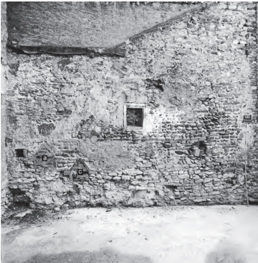
Abb. 4 Riehentorstrasse 11. Höflein mit der 1997 erfassten Südmauer gegen die Parzelle Lindenberg 19: Rückseite der 2008 untersuchten nördlichen Hofmauer. In der Bildmitte das hier noch sichtbare kleine Fenster. Die Nischenkonstruktionen (a und c) nehmen die ganze Mauerstärke von ca. 30 cm ein. Die Nähe der Lichtnischen zu einander lässt vermuten, dass die Mauer von Anfang an als gemeinsame Brandmauer für zwei Behausungen erstellt worden war. Die Nischen gehörten zu je einem der beiden Häuser und waren auf den entsprechenden Seiten mit einer dünnen Rückwand ausgestattet. Am linken Bildrand die ältere Ostmauer. – Foto: Matthias Merki.
