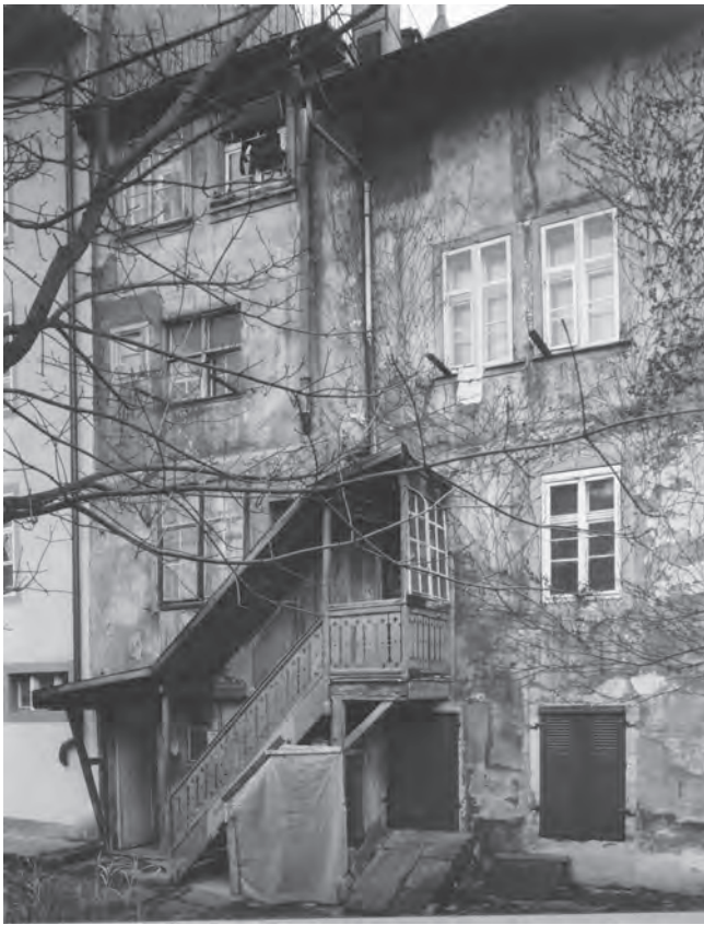
Abb. 5 Unterer Heuberg 7. Hoffassade vor dem Umbau 1978. Die gedeckte Aussentreppe führte vom EG des schmalen Gebäudes links im Bild entlang der Fassadenmauer hinauf ins 1. OG des breiten Hausteils rechts. Unmittelbar darunter befand sich die schräge Brettertüre, die den ehem. Kellerhals abdeckte. Beide Zugänge wurden 1979 abgebrochen und durch eine interne Haustreppe ersetzt. – Foto: Christoph Teuwen, 1978, Archiv DPFB.
