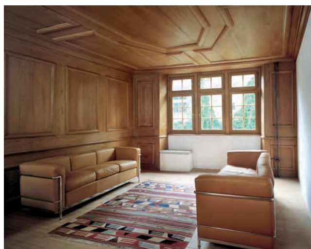
Der Raum nach der Renovierung. Das Täfelholz wurde von den Anstrichen befreit und dem ursprünglichen Zustand entsprechend natursichtig restauriert. – Foto: Ruedi Walti, 2008.
