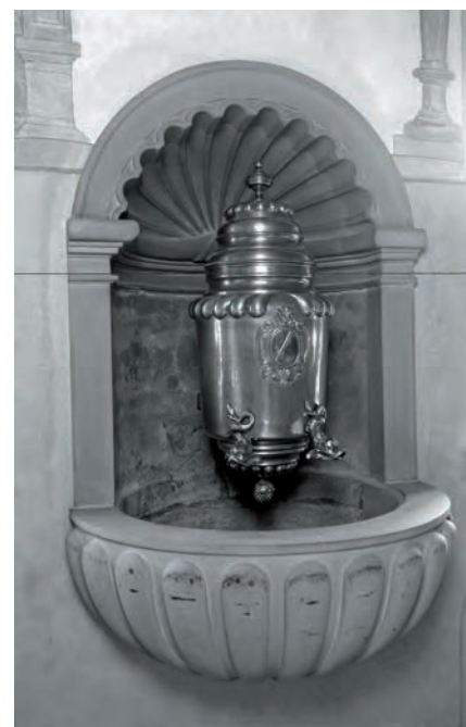
Abb. 11 Schützenmattstrasse 56. Schützensaal: Lavabo in der Ostwand. Die Nische ist original, der vortretende Teil des Lavabos, die Randpartie der Konche und das Wassergefäss sind Rekonstruktionen von 1961 (siehe Abb. 18). – Foto: Matthias Merki.
