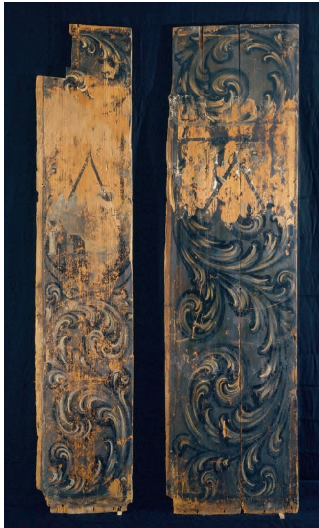
Abb. 23 Blumenrain 28. Zwei Wandbretter des einstigen Täfelzimmers von 1436 (siehe Kapitel 3.11). Unter der jüngeren Rankenmalerei ist eine dunkelrote, wohl bereits beim Einbau des Täfelwerks entstandene Fassung mit schwarzem Rautenmuster erkennbar. Erst im späten 17. Jh. wurde das Täfelwerk gesamthaft mit einer Grisaille bemalt (siehe Kapitel 3.19). Das schmalere Brett trägt in der Mitte zusätzlich zu den Ranken ein kreisrundes Medaillon mit Landschaftsmotiv. – Foto: Conradin Badrutt.
