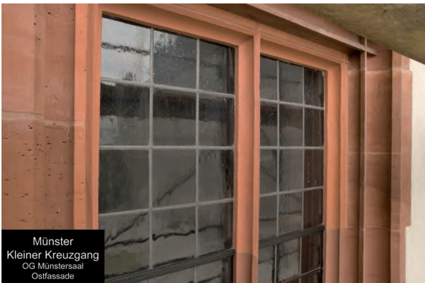
Abb. 5 Münster, Münstersaal-Ostfassade. Eines der fünf grossen Fenster mit reich gegliederter Rahmung. Heller hervorgehoben sind die aus einer einzigen Platte gehauenen Gewände-, Sturz- und Mittelstabteile. Dieser Bereich wurde ursprünglich von Masswerk geziert (siehe auch Abb. 1). – Foto: Matthias Merki.
