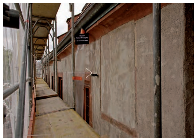
Abb. 2 Münster, Münstersaal-Ostfassade. Sandstein-Einfassung einer sekundär zugemauerten Öffnung unterhalb des Traufgesimses zwischen dem Konzilssaal der Niklauskapelle und dem nördlichsten der fünf Fenster in der Ostfassade des Münstersaals. – Foto: Matthias Merki.
