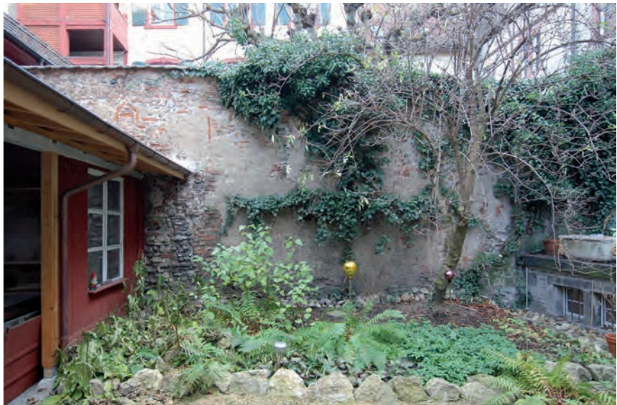
Abb. 5 Lindenberg 17/19. Östliche Hofmauer. Diese Mauer wurde nicht näher untersucht. Der Befund auf der Parzelle Riehentorstrasse 11 zeigt, dass die Ostmauer auf der Parzelle Riehentorstrasse 11 älter ist als die Nordmauer. Die zugemauerte Lichtnische auf der Höhe des 1. OG weist auf einen ehemaligen mindestens zweigeschossigen Bau. Die Lichtnische ist von derselben Bauart wie die Nischen in der Nordmauer. – Foto: Matthias Merki.
