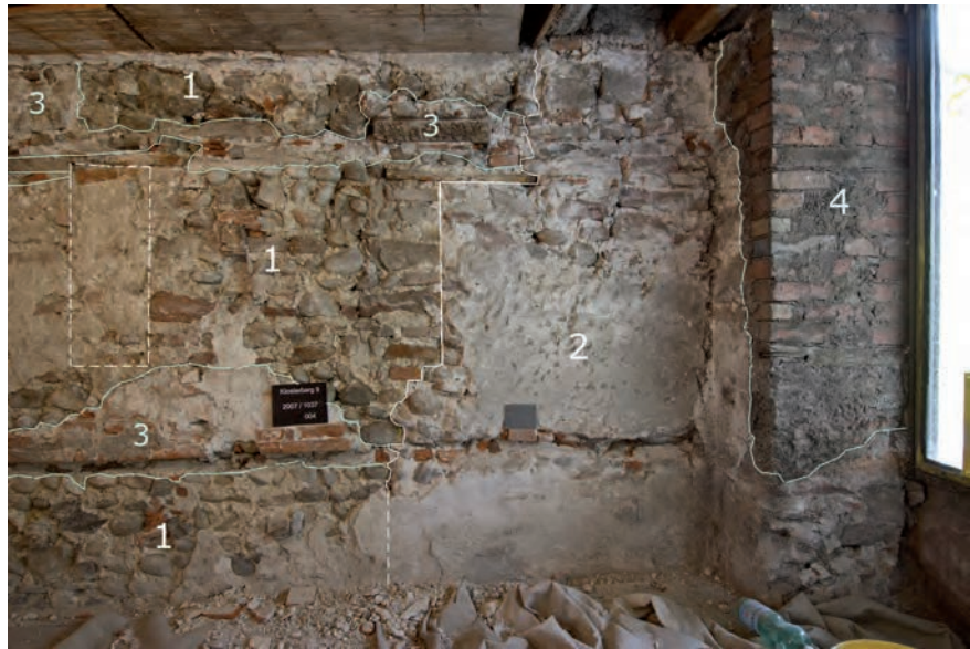
Abb. 13 Klosterberg 9, EG, Westbrandmauer. Originales Schartenfenster mit Sturzbrett über der Fensternische. Der Fensterschlitz ist deutlich schmaler und niedriger als die Nische. Im unteren Teil vermitteln Werkstücke aus Buntsandstein zwischen den Leibungen der Nische und des Fensterschlitzes. Die Einzüge sind breiter als die Falze, was vermuten lässt, dass der Verputz der Nischenwände vor allem links leicht trichterförmig und bündig mit den Falzen aufgemörtelt war. – Foto: Matthias Merki.
