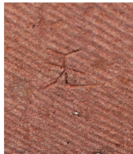
Abb. 5 Münster. Durchgang von der Halle zum kleinen Kreuzgang. Steinmetzzeichen an der Gewölbetonne. Dasselbe Zeichen mit der charakteristischen groben Scharrierung dieses Steinmetzen kommt auch am Martinsturm vor. – Foto: Matthias Merki.
