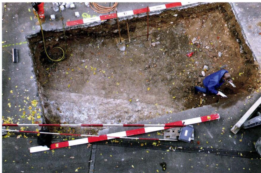
**Abb. 33** Wettsteinstrasse (A), 2007/65. Blick von der Wettsteinbrücken-Rampe auf die Baustelle. Deutlich ist die diagonal zur rechteckigen Baugrube verlaufende Kontermauer zu erkennen. – Foto: Roman Rosenberger.
