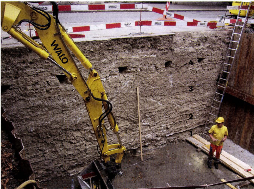
Abb. 16 Klingentalgraben (A) 28, 2006/29. Blick in die fertig ausgehobene Trafostation-Baugrube: Die gemauerte Wand hinter dem Baggerarm ist die äussere Grabenwall-Mauer. – Foto: Christoph Philipp Matt.
