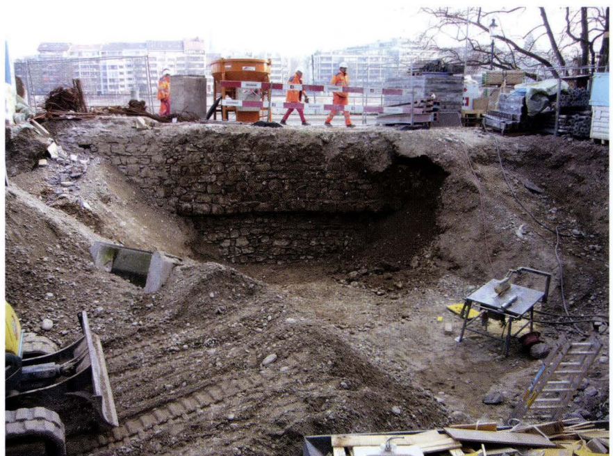
Abb. 3 St. Johannis-Rheinweg 115, 2005/29. Überblick über die Stadtmauer während der Freilegung: deutlich hebt sich die obere Bauetappe durch die vorspringende Mauerflucht von der untern ab. – Foto: Christoph Philipp Matt.
