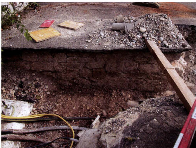
Abb. 20 St. Alban-Talstrasse (A) 19, 2006/39. Blick auf die Kontermauer der St. Alban-Schanze. – Foto: Christian Stegmüller.
