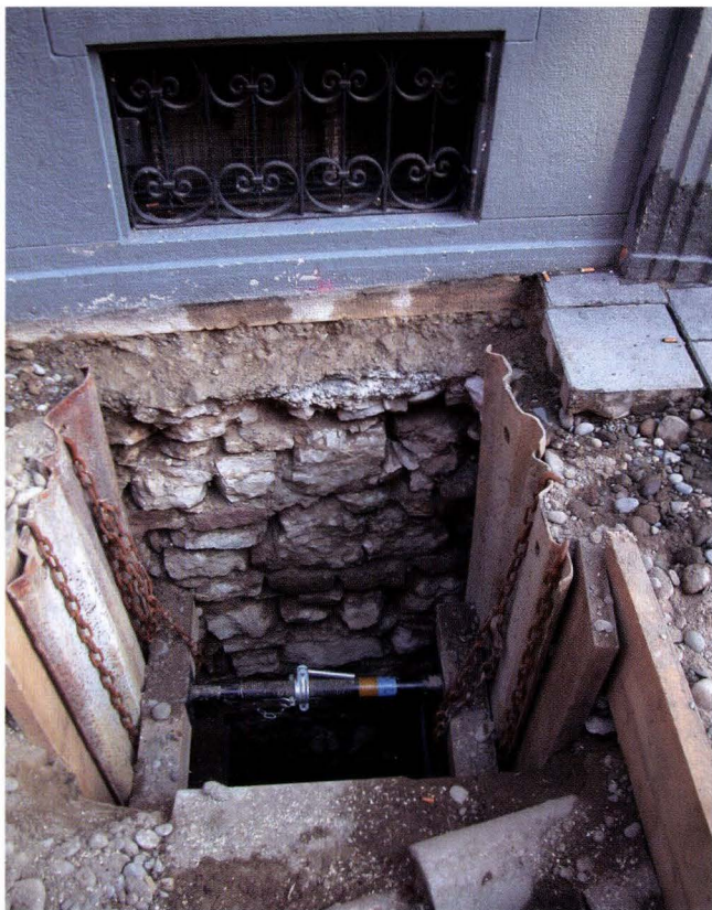
Abb. 19 Freie Strasse (A) 25, Zunfthaus zum Schlüssel, 2006/36. Blick auf das Fassadenfundament in der Nähe der Ecke am Schlüsselberg. – Foto: Christian Stegmüller.
