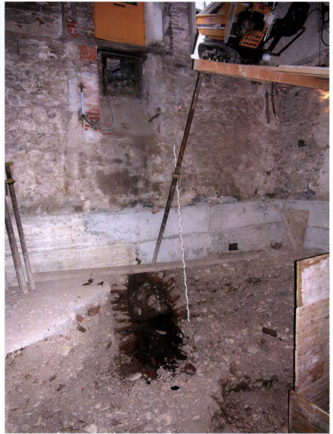
Abb. 21 Webergasse 25, 2006/42. Blick auf die dunkel verfüllte Sickergrube bei der Vorderfassade des Hauses. – Foto: Udo Schön.
