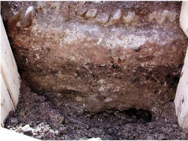
**Abb. 6** Marktplatz (A) 9–16, 2006/16. Innenansicht des unteren Teils der Kellermauer 3. Höhe des mit Mörtel verputzten Bereichs ca. 85 cm. – Foto: Roman Rosenberger.
