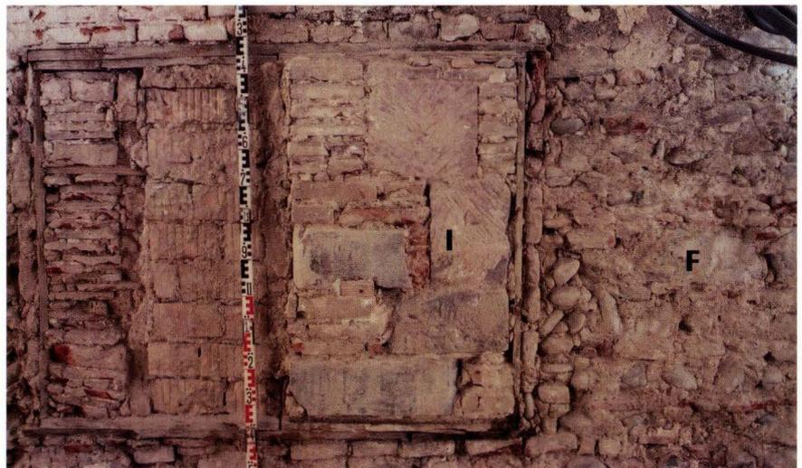
Die übrigen Mauerelemente gehören zu Erweiterungsphasen des nicht mehr existierenden Hauses Gerbergasse 59. Von der Kernbaumauer A weg erstrecken sich die jüngeren Mauerpartien F und G über elf Meter bis zur Gerbergasse. Ihr Mauerbild ist einander sehr ähnlich. Das nur 2,5 Meter lange Mauerstück G scheint jedoch dichter gemauert und etwas älter zu sein. Die Bauphasengrenze zu F kann nicht genau eruiert werden, da der fragliche Bereich gestört ist.
