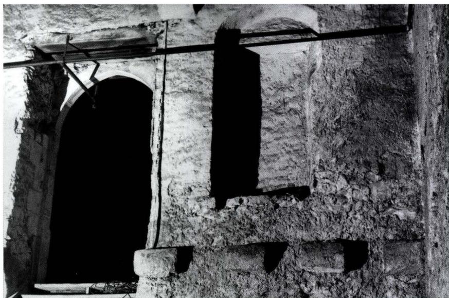
**Abb. 5** Nadelberg 6 – Schönes Haus. Ansicht der Mittelmauer vom Hauptkeller Richtung Vorkeller (Ost). Zustand vor dem Umbau 1966/70. Das Fenster rechts des mittleren Spitzbogentors war damals zugemauert und die Balkendecke des Zwischenbodens auf den alten Kragsteinen nicht mehr vorhanden. – Foto: Basler Denkmalpflege, 1966.
