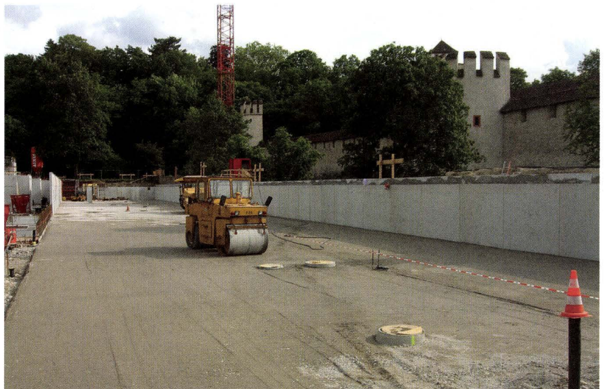
Abb. 15 St. Alban-Rheinweg 108–120, 2005/5. Blick aus dem gleichen Winkel wie bei Abb. 11. Die Baugrube ist nun ausgehoben. Eine neue Mauer schützt die Rückseite der Kontermauer. – Foto: Christoph Matt.
