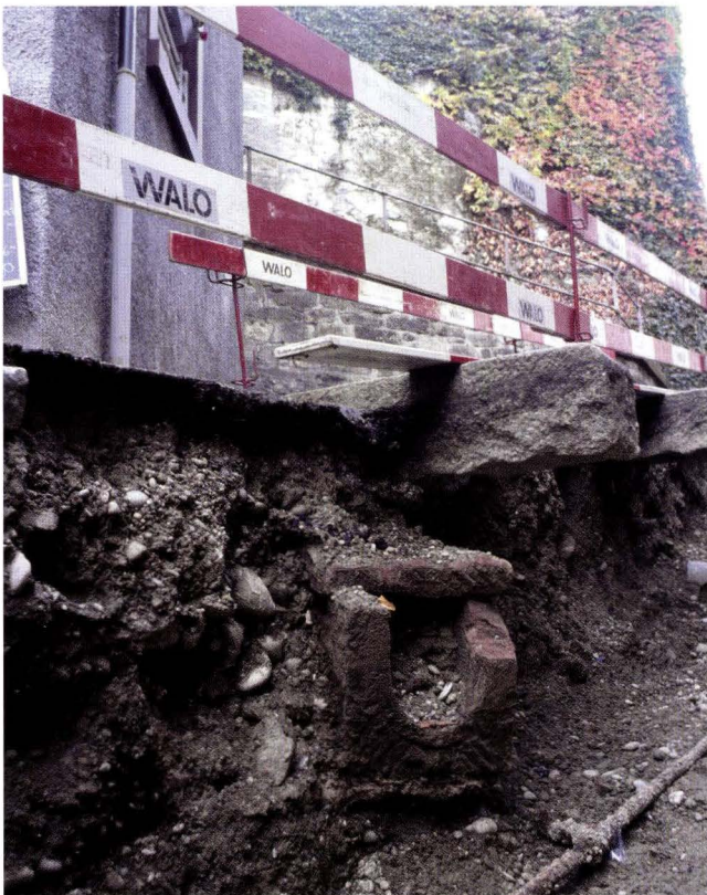
Abb. 26 Leonhardsstapelberg (A), 2005/30. Eine vom Hang her kommende sandsteinernerne Abwasserleitung mit Backsteinabdeckung. – Foto: Catrin Glaser.
