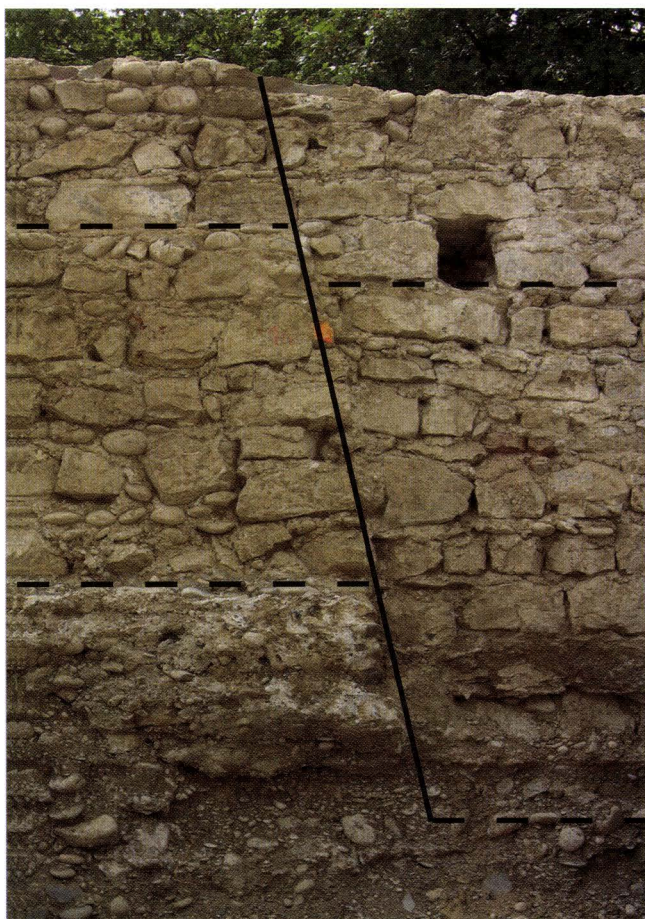
Abb. 17 St. Alban-Rheinweg 108–120, 2005/5. Blick auf die Grenze eines Bauloses (ausgezogene Linie), zweier Bauetappen-Grenzen in der Vertikalen (gestrichelte Linien) und auf ein Gerüsthebel-Loch. – Foto: Christoph Matt.
