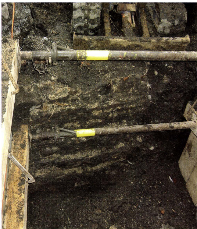
Abb. 12 Totengässlein 1/3, 2005/4. Blick auf das wohl spätmittelalterliche Hausfundament im unteren Höflein des Pharmazie-Historischen Museums. – Foto: Christoph Matt.
