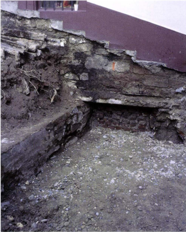
Abb. 25 Leonhardsstapelberg (A), 2005/30. Blick in den Rümelinbach-Kanal und an die Zumauerung an der Hausfassade nach dessen Trockenlegung. – Foto: Catrin Glaser.
