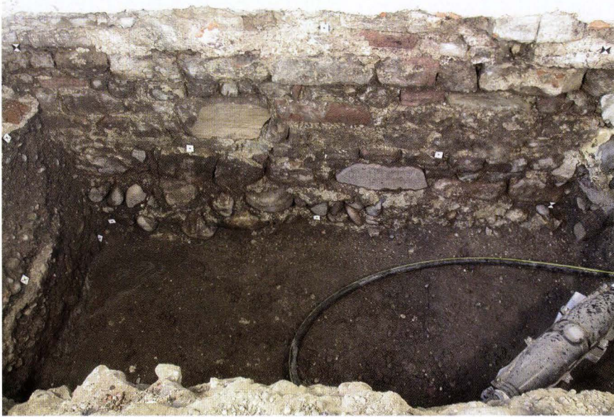
Abb. 22 Münsterplatz 19, 2005/13. Ansicht der Mauer des Rollerhof-Kernbaus. – Foto: Udo Schön.
