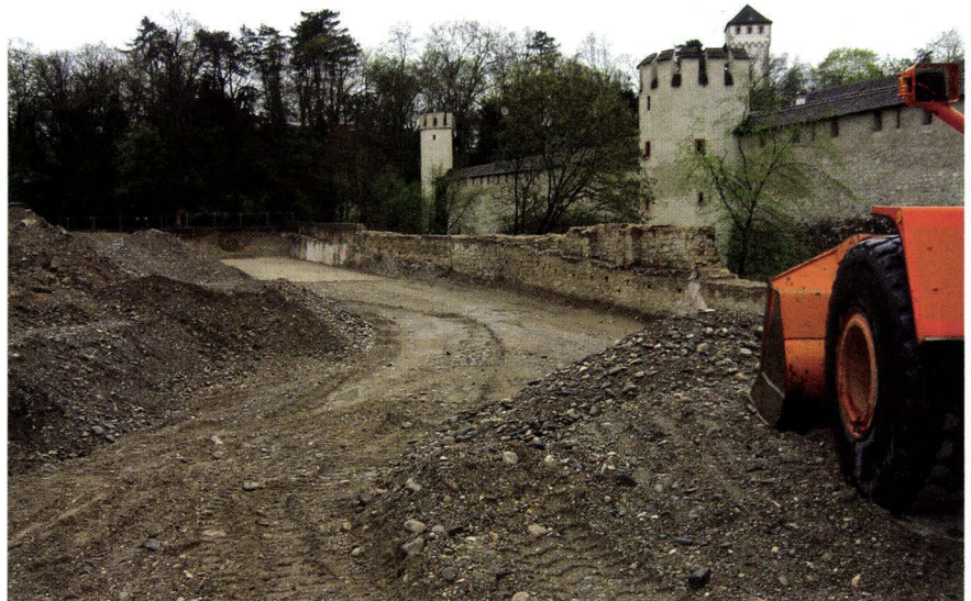
Abb. 14 St. Alban-Rheinweg 108–120, 2005/5. Blick über die Baugrube. – Foto: Christoph Matt.
