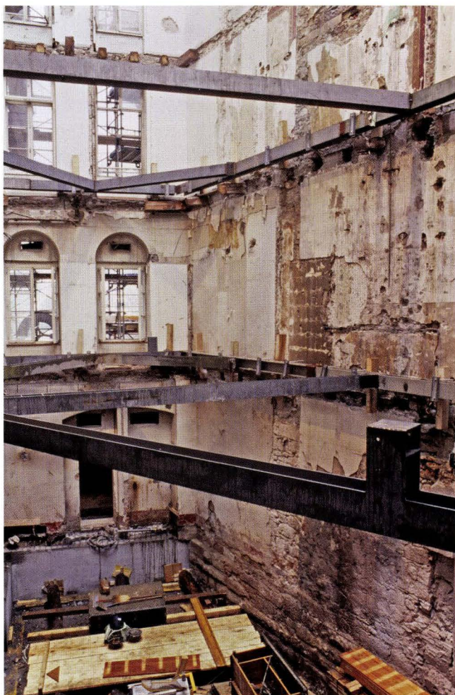
Abb. 9 Das Hotel «Drei Könige» wird fast vollständig ausgekernt, so dass die Reste des Salzturms zum Vorschein kommen. – Foto: Philippe Saurbeck.
