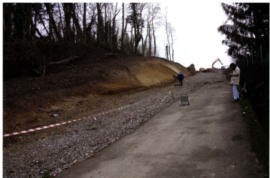
Abb. 1 Sierentz-Monenberg (F). Ansicht der beim Bau der Monenberggasse entstandenen Strassenböschung mit dem rund 80 m langen Profil, Blick Richtung Südwesten. – Foto: Philippe Rentzel.
