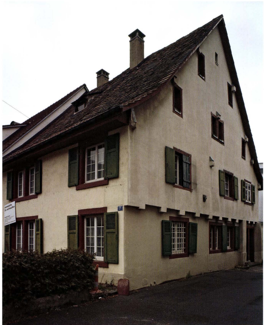
Abb. 10-5 Rössligasse 7, Riehen (2003/381). Giebfassade vor der Renovation 2004. Deutlich erkennbar ist das vorgeschobene Fachwerk über dem gemauerten EG. Sämtliche ursprünglich sichtbaren Holzteile wie Balken- und Pfettenköpfe sowie das gesamte Riegelfachwerk sind mit einem Zementverputz überzogen. – Foto: Basler Denkmalpflege.
