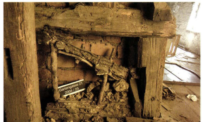
Abb. 4-15 Gartengasse 21, Riehen (2004/107). Rest einer mit Lehm verstrichenen Flechtwerk-Ausfachung nächst der Südwestecke der Hochstud-Konstruktion. – Foto: Hans Ritzmann.
