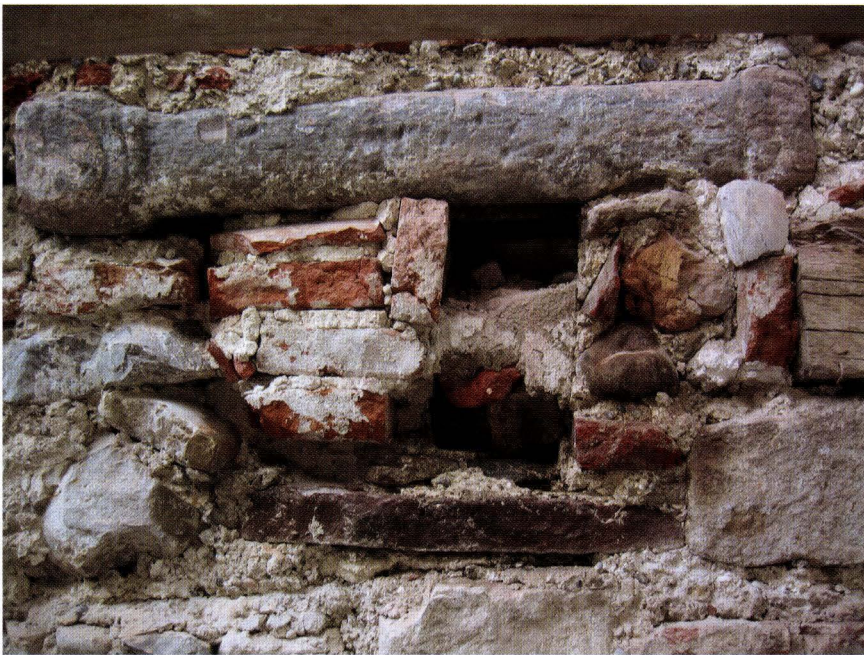
Abb. 11-13 Spalenberg 18 (2004/4). Strassenseitige Fassade, 3. Obergeschoss. Die zwei in der Mittelachse der Fassade angeordneten Balkenköpfe wurden im originalen Mauerwerk mit einer Spolie übermauert. Bei der späteren Entfernung des linken Balkens wurde der entstandene Hohlraum vermauert. Der rechte Balken wurde erst später entfernt. – Foto: Basler Denkmalpflege.
