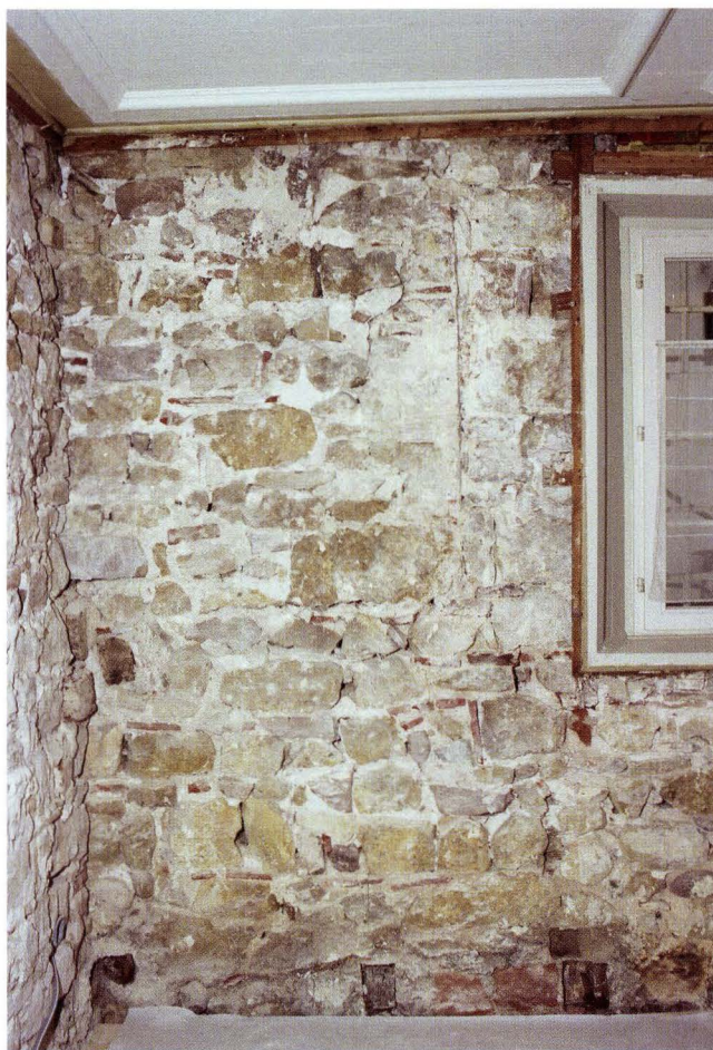
Abb. 10-25 Rössligasse 7, Riehen (2003/381). Teil der Ostfassade der Erweiterung im Eckraum zur Strasse. Das Mauerwerk entstand als Ersatz für eine ältere Fassadenkonstruktion. Neben dem erst im 19. Jahrhundert eingebauten Fenster zeigt sich eine originale Fensterleibung. In der Ecke links zieht das Mauerwerk an der nachträglich angefügten Quermauer vorbei. – Foto: Basler Denkmalpflege.
