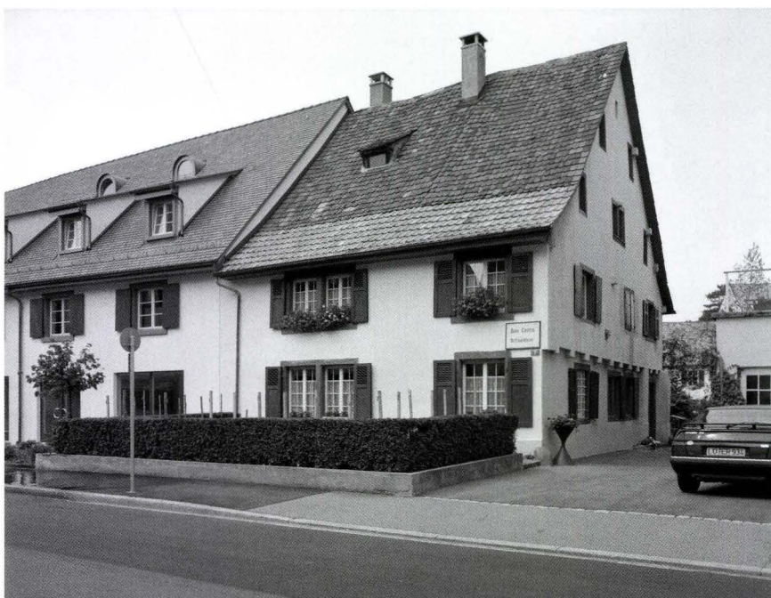
Abb. 10-2 Rössligasse 7, Riehen (2003/381). Haus mit Strassen- und Giebelfassade. Die beiden Fensterachsen repräsentieren zwei verschiedene Bauetappen: links der ältere Teil, rechts die jüngere Erweiterung mit der freistehenden Giebelfassade und dem vorgeschobenen Fachwerkstock über dem gemauerten Erdgeschoss. – Foto: Basler Denkmalpflege.
