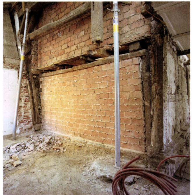
Abb. 4-14 Gartengasse 21, Riehen (2004/107). Die Westwand in der Übersicht (vgl. Abb. 4-13). Deutlich ist hinten links beim Wandständer P die Nut zu sehen, worin ursprünglich die Bohlenwand eingelassen war. Die Backsteinmauern stammen frühestens aus dem 17. Jahrhundert. – Foto: Bernard Jaggi.
