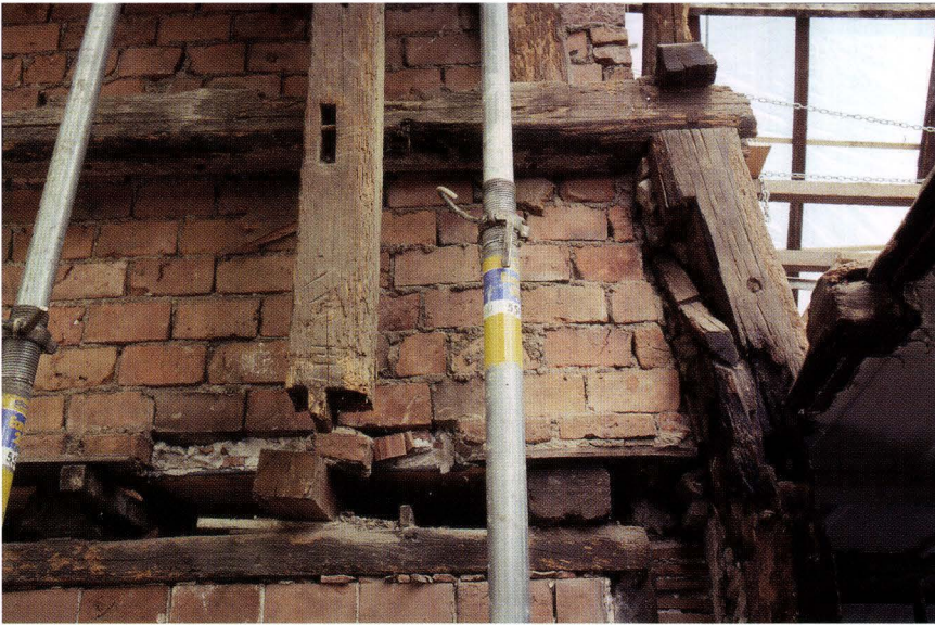
Abb. 4-6 Gartengasse 21, Riehen (2004/107). Blick auf die Westwand des Hochstudhauses (siehe Plan Abb. 4-13). Rechts der teilweise beschädigte Wandständer E. An seiner linken Seite schräg aufsteigend der Sperr-Rafen R. Parallel zum oberen Bildrand liegt der Rähmbalken U der Westwand. Der auf dem Bild erkennbare Bereich der Backsteinmauer trennt seit 1650 die Häuser Nr. 21 und 25. Der hängende Balken in der Bildmitte gehört zu einer Dachverstärkung des 19. Jahrhunderts. – Foto: Stephan Tramèr.
