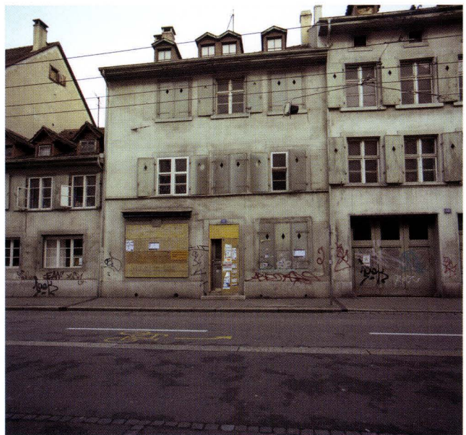
Abb. 7-2 Rebgrasse 11 (2003/435). Strassenfassade vor der Sanierung. Das 2. OG entstand erst 1852 durch «Aufklappen» der Dachschräge. – Foto: Basler Denkmalpflege.
