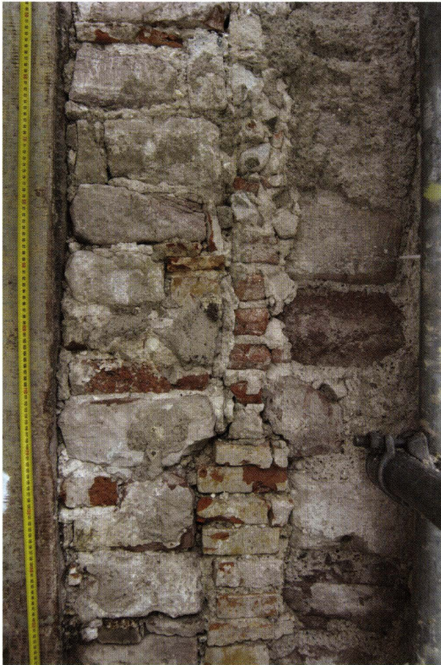
Abb. 8-2 Rheingasse 11 (2004/410). Einbaustreifen eines ehemaligen Fensters an der rechten Seite der Fassade im 1. OG. Am linken Rand des Streifens konnte der Abdruck eines Gewändesteins festgestellt werden. Links davon zeigt sich das Einbaumauerwerk des bestehenden Fensters aus dem 19. Jahrhundert. – Foto: Basler Denkmalpflege.
