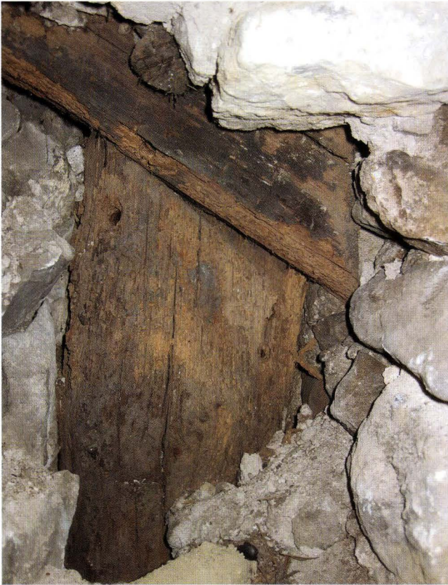
Abb. 10-20 Rössligasse 7, Riehen (2003/381). Befundsituation Westbrandmauer, 1. OG. Die beiden Hölzer (Ständer und angeblattete Strebe) der Fachwerkwand von 1404. Rechts ist die um 15 cm vorstehende Giebelmauer angefügt. Nachträglich wird sie links davon (das Fachwerk zudeckend) ergänzt. – Foto: Basler Denkmalpflege.
