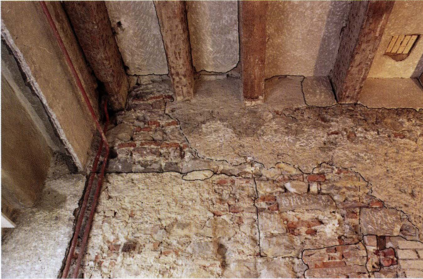
Abb. 2-4 Blumenrain 30 (2004/450). Brandmauer im EG gegen Westen nach partieller Freilegung. Der senkrecht verlaufende Mauerabbruch ist eingezeich- net. Auf dem Plan Abb. 2-3 ist diese Situation schematisch festgehalten. – Foto: Basler Denkmalpflege.
