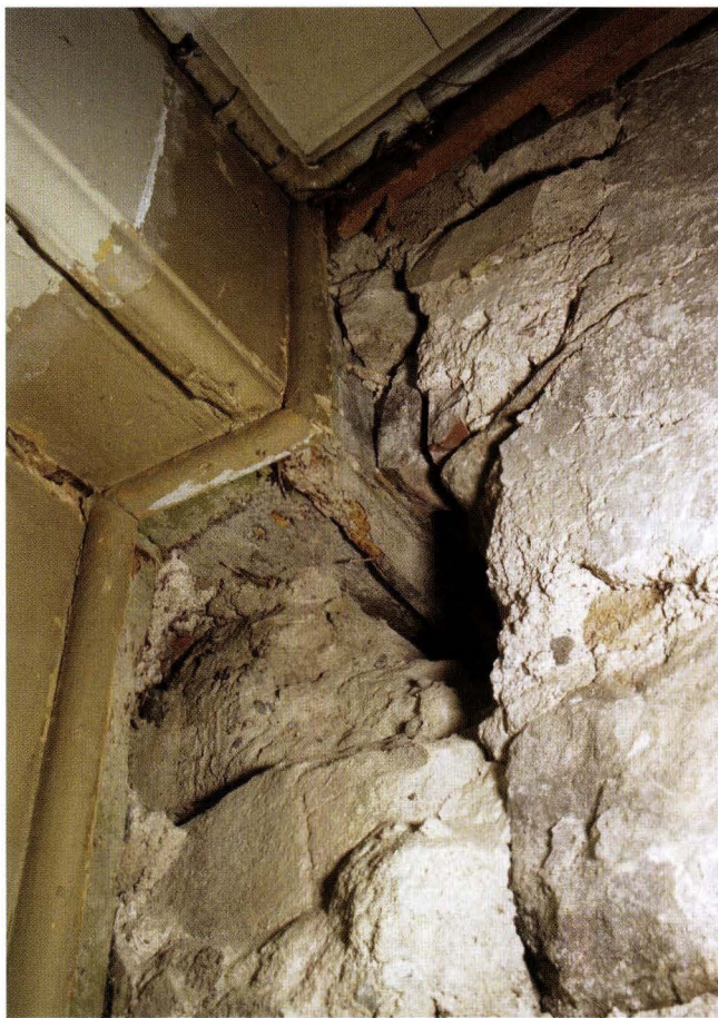
Abb. 10-26 Rössligasse 7, Riehen (2003/381). Der um 1724 in die alte Fassadenmauer eingebaute Unterzug und die seitlich angebaute Quermauer, die den vorderen Eckraum der Erweiterung von 1707 rückseitig begrenzt. Der Unterzug diente einer breiten Öffnung und musste die massive Fassade des 1. OG über eine Spannweite von 2,5 m abfangen. Unterhalb und auch seitlich zieht die Verkleidung in die Einmauerungsöffnung hinein. – Foto: Basler Denkmalpflege.
