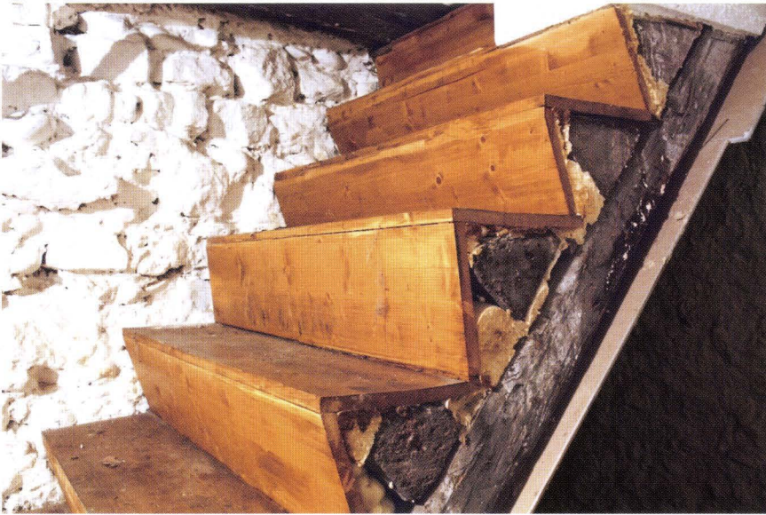
Abb. 12-2 Spalenberg 28 (2004/325). Eine von drei Blockstufentritten, die noch bis zum Umbau 2004 bestanden. Die Stufen der Kellertreppe sind schon früher mit Brettern und Schaumstoffkleber fixiert und «verschönert» worden. – Foto: Basler Denkmalpflege.
