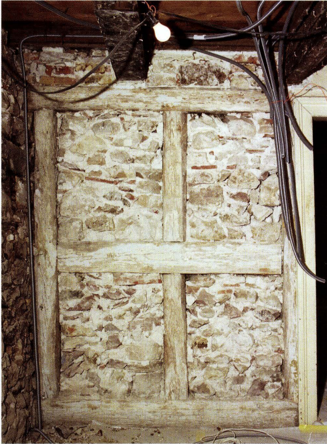
Abb. 10-24 Rössligasse 7, Riehen (2003/381). Fachwerkwand im 1. OG vom Treppenhaus zum strassenseitigen Zimmer des westlichen Gebäudeteils. Die Wand ist nachträglich an die Innenseite der ehem. Fassadenmauer (links) angefügt. Vermutlich lag die ursprüngliche Raumteilung weiter vorne. Die bestehende Wand passt in die Zeit der Erweiterung von 1707. – Foto: Basler Denkmalpflege.
