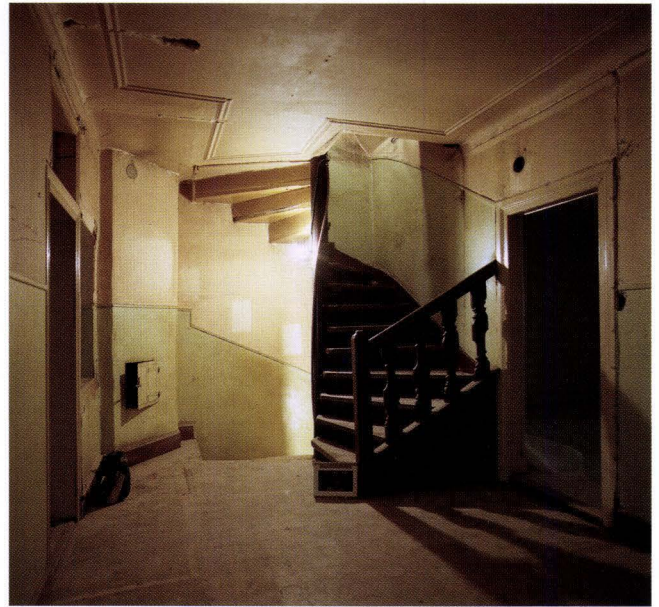
Abb. 7-4 Rebgasse 11 (2003/435). Gang im 1. OG mit Wendeltreppe und Geländerteil mit barocken Brettbalustern. Der Aufgang führt ins (ehem.) Dachgeschoss. – Foto: Basler Denkmalpflege.
