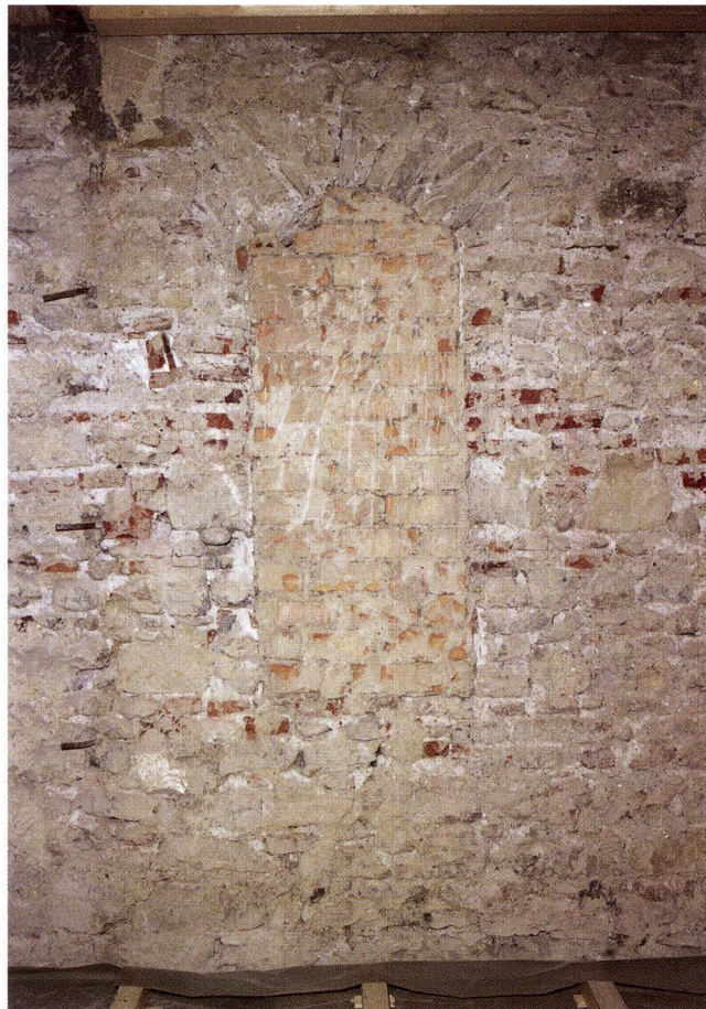
Abb. 11-11 Spalenberg 18 (2004/4). Bergseitige Brandmauer im 2. Obergeschoss. Original im Mauerwerk angelegte Öffnung oder Nische in der Giebelachse. Dieser Gebäudebereich überragte wahrscheinlich an dieser Stelle ursprünglich die benachbarte bergseitige Bebauung. – Foto: Basler Denkmalpflege.
