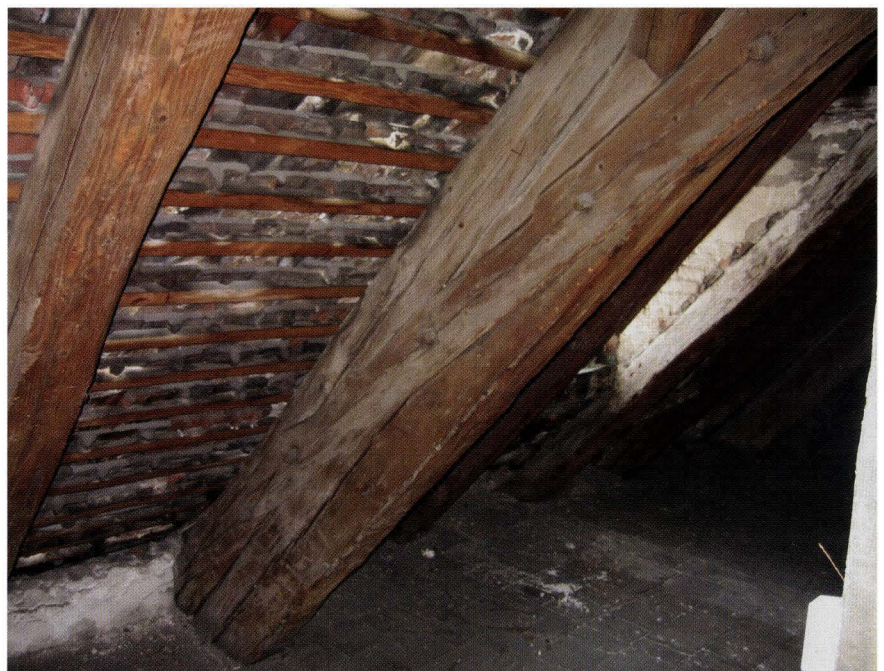
Abb. 13-13 Spalenvorstadt 11 (2004/168). Dachwerk über dem linken Hausteil. Die an die Stuhlsäule angeblatteten Streben führen ins stehende 2. Dachgeschoss. Die spezielle Ausprägung des Dachwerks verweist in die erste Hälfte des 15. Jahrhunderts. – Foto: Basler Denkmalpflege.
