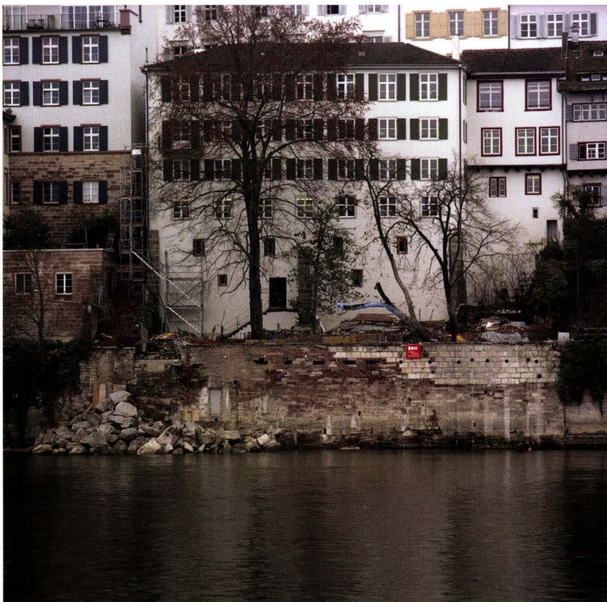
Abb. 9-2 Rheinsprung 21 (2003/448). Übersichtsaufnahme der Stützmauer vor der Sanierung. – Foto: Basler Denkmalpflege.
