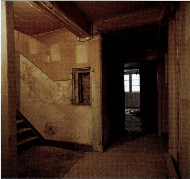
Abb. 7-3 Rebgasse 11 (2003/435). Mittelgang im EG mit Blick gegen die Hinterfassade. In dieser Mauer hat sich links beim Antritt zur Treppe ein Fragment einer spätgotischen Fenstereinfassung erhalten. – Foto: Basler Denkmalpflege.
