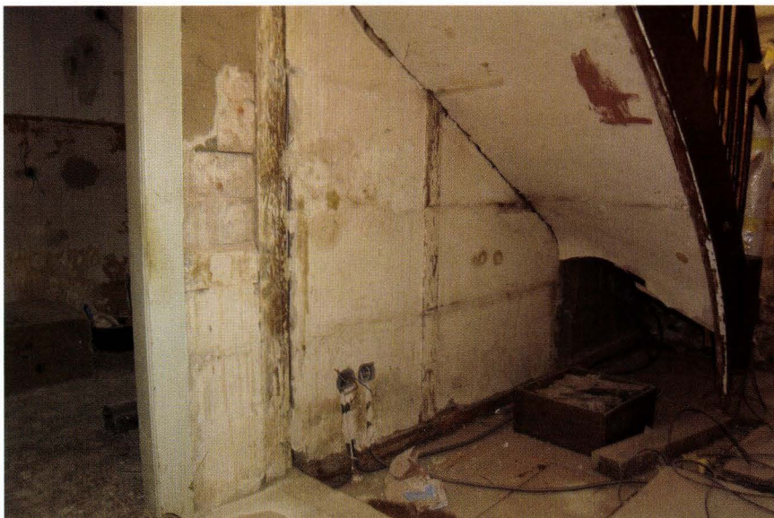
Abb. 10-18 Rössligasse 7, Riehen (2003/381). Alte Ständerwand im EG zwischen Treppenaufgang (von 1925) und hinterem westlichem Raum. Die Wand gehört zu den darüber quer laufenden Deckenbalken, die dendrochronologisch auf 1406 datiert wurden und damit den ältesten, im nordwestlichen Viertel des Gebäudes liegenden Hausteil repräsentieren. – Foto: Basler Denkmalpflege.
