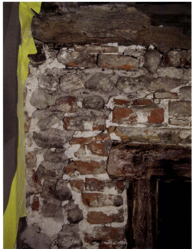
Abb. 12-7 Spalenberg 28 (2004 / 325). Ausschnitt der Hoffassade im Traufbereich. Deutlich sind die helle Einbau-Ausflickung für das mit Holz gefertigte Fenstergewände sowie der helle Einbaustreifen für die Dachschwelle zu sehen. Die Hofmauer selbst besteht v. a. aus Wackensteinen in grauem, grob gemagertem Kalkmörtel. – Foto: Basler Denkmalpflege.
