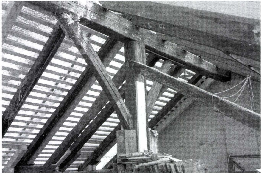
Abb. 11-17 Spalenberg 18 (2004/4). Stuhlkonstruktion von 1425 im Dachgeschoss. Firstständer und Firstpfette sind über Kopfbänder miteinander verstrebt. Die parallel zu den Rafen verlaufenden Steigbänder sind mit dem Firstständer verblattet. – Foto: Basler Denkmalpflege
