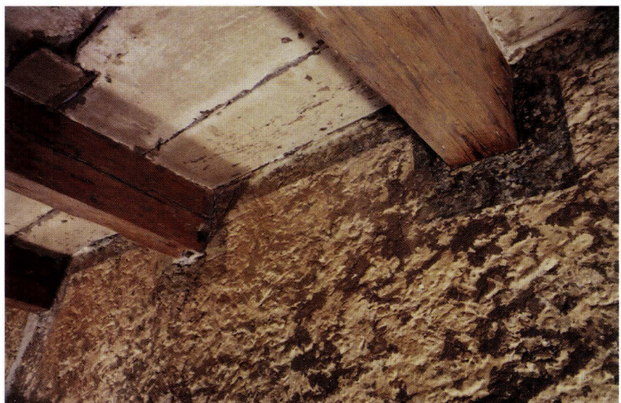
Abb. 12-1 Spalenberg 28 (2004/325). Brandmauerabschnitt talwärts im 2. OG, Gebäudemitte. Zu sehen sind Reste einer Graubandmalerei auf rauhem Putz. – Foto: Basler Denkmalpflege.
