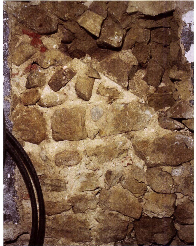
Abb. 10-21 Rössligasse 7, Riehen (2003/381). Befundsituation Westbrandmauer, 1. OG. Ausschnitt der Giebelmauer, die an den Fachwerkständer anbaut und mit einer nach Norden abfallenden Dachlinie abschliesst. In der Mauerschräge hat sich das Negativ des Dachsparrens erhalten. Der Anbau der Giebelmauer liegt zeitlich zwischen 1404 (Fachwerk) und 1406 (Deckenbalken). – Foto: Basler Denkmalpflege.
