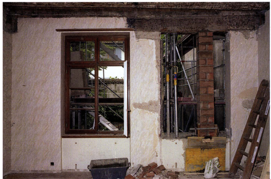
Abb. 11-3 Spalenberg 18 (2004/4). Hofseitige Mauer, Innenansicht im 1. Obergeschoss, Blick zum Hof. Der Fenstersturz blickt über die gesamte Gebäudebreite und ist bis auf die Tiefe der halben Mauerstärke in die Brandmauern eingelassen. Die neuzeitlichen Fensteröffnungen übernehmen die Balkenkante als obere Begrenzung. – Foto: Basler Denkmalpflege.
