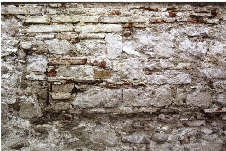
Abb. 8-3 Rheingasse 11 (2004/410). Oberer Abschluss der ursprünglichen Fassadenmauer, linke Hälfte. Unten zeugt eine schmale horizontale Struktur von einem Schwelleneinbau einer ehemaligen Öffnung, die ins Dach führte. Seitlich links zieht die alte Fassade auf Kniestockhöhe bis zur einstigen Dachtraufe. Das lagige Bruch- und Backsteinmauerwerk in der Mitte gehört zur Aufstockung von 1852. – Foto: Basler Denkmalpflege.
