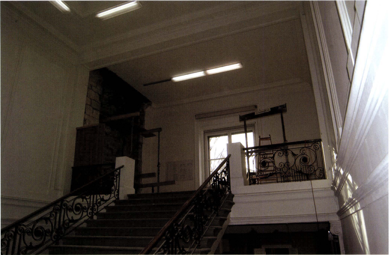
Abb. 16-3 Steinberg 7, Kunsthalle (2003/431). Treppenhaus 2. OG. Oben links die Baustelle für den neuen Lift: Die bestehende Nische für den Bilderaufzug wurde freigelegt und tiefer ausgebrochen. Die Vertiefung bedingte den Ausbruch einer dahinter stehenden älteren Brandmauer. – Foto: Basler Denkmalpflege.
