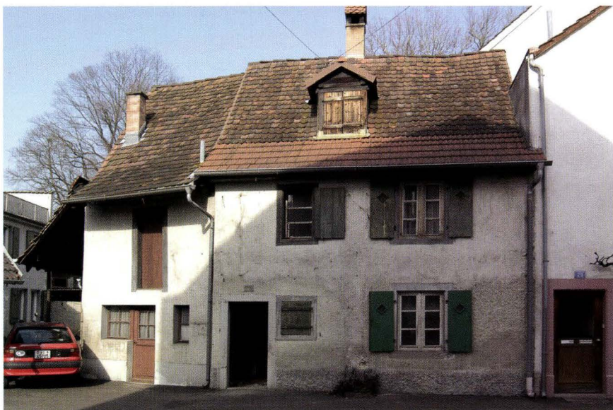
Abb. 3-2 Gartengasse 27, Riehen (2003/23). Strassenseitige Fassade vor der Sanierung. Der Anbau ist durch die abweichende Dach- und Fassadenflucht leicht erkennbar. – Foto: Basler Denkmalpflege.
