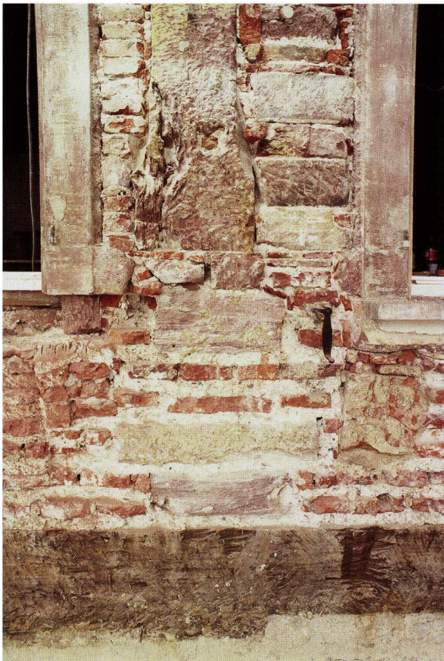
Abb. 11-9 Spalenberg 18 (2004/4). Strassenseitige Fassade, 1. Obergeschoss. Der zentrale Fensterpfosten aus Sandstein fusst auf einer Verstärkung im hier sonst aus licht gesetzten Backsteinen bestehenden Mauerwerk. Am Balken darunter ist die Ansatzstelle des einst vorhandenen hölzernen Mittelpfostens zu erkennen, der die Balkenmitte unterstützte. – Foto: Basler Denkmalpflege.
