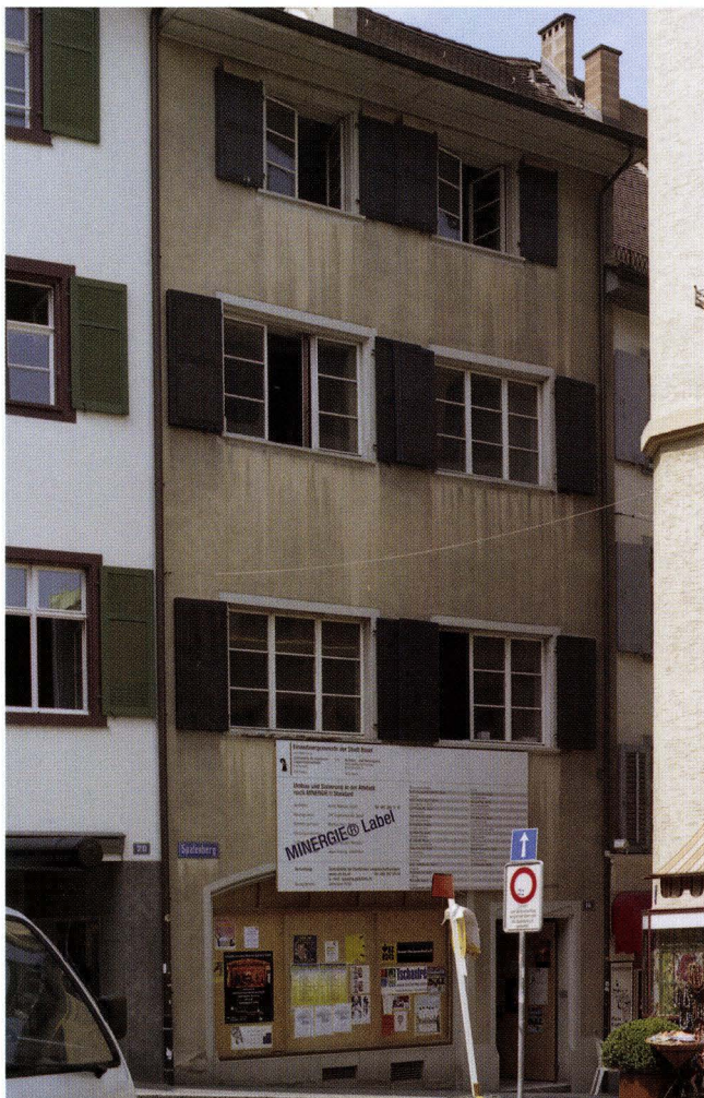
Abb. 11-2 Spalenberg 18 (2004/4). Fassade zum Spalenberg vor Beginn der Renovationsarbeiten. – Foto: Basler Denkmalpflege.
