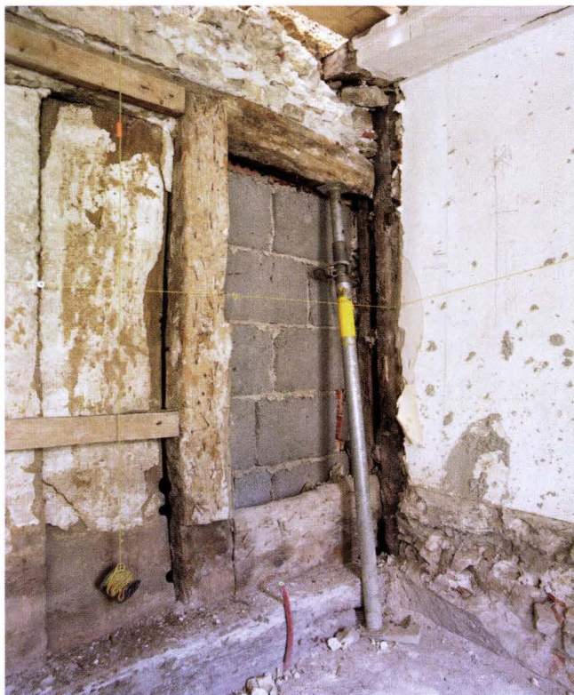
Abb. 4-9 Gartengasse 21, Riehen (2004/107). Der Wandständer der Ostseite mit breiter Nut (W) ist hinter dem Bauspriess sichtbar. Darin steckt ein Fragment einer 9,5 cm breiten Bohle (B), die ursprünglich zur Innenwand des Hochstudhauses gehörte. Der Bauspriess stützt, unten an die Querschwelle Q gelehnt, den Wandriegel A ab. – Foto: Bernard Jaggi.
