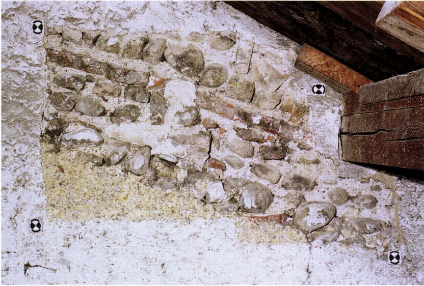
Abb. 11-12 Spalenberg 18 (2004/4). Bergseitige Brandmauer im Dachgeschoss, Hofseite. Die ursprüngliche, schwach geneigte Dachlinie zeigt sich heute noch in der Mauerkrone der originalen Giebelmauer. Die um 1425 durchgeführte, für die neue Dachkonstruktion benötigte Aufmauerung folgt in ihrem lagigen Aufbau der alten Neigung. – Foto: Basler Denkmalpflege.
