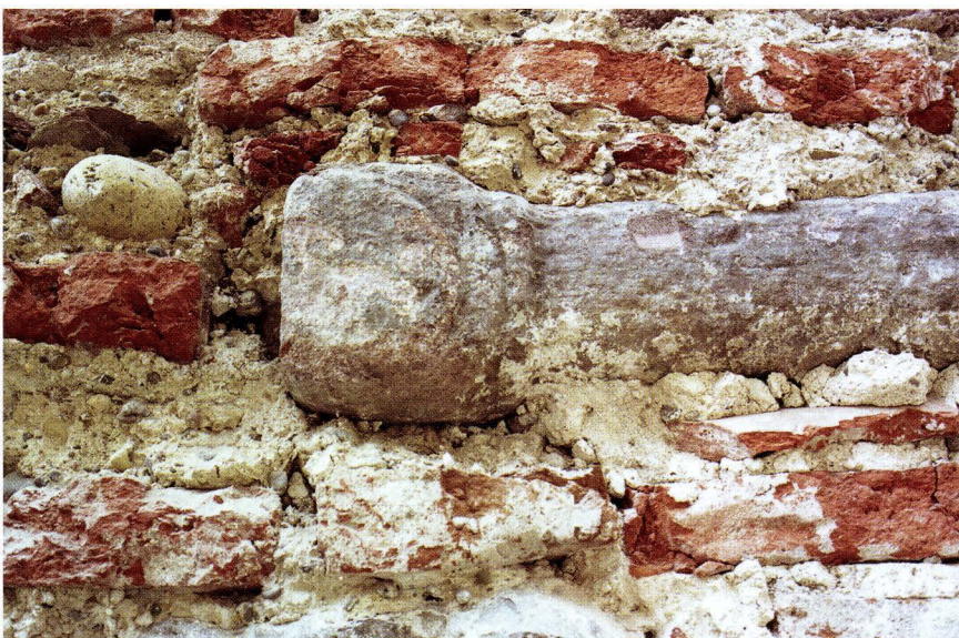
Abb. 11-14 Spalenberg 18 (2004/4). Strassenseitige Fassade, 3. Obergeschoss. Detail des Säulenkapitells der Spolie. Deutlich erkennbar ist die doppelt reliefierte Halbkreisform im Würfelkapitell. – Foto: Basler Denkmalpflege.
