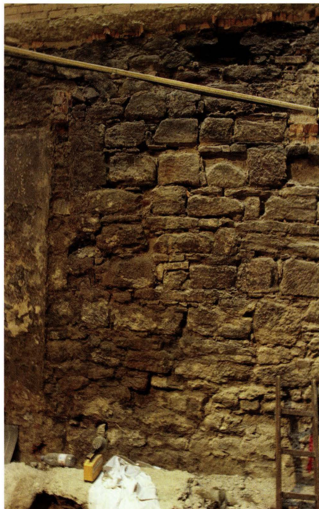
Abb. 16-2 Steinenberg 7, Kunsthalle (2003/431). Stützmauer im rückwärtigen Teil des Kunsthallenkomplexes gegen die Elisabethenstrasse (Befundort A). Das locker gelagerte Quadermauerwerk besteht vorwiegend aus Degerfelder Sandstein. Im oberen Teil der ca. 3,5 m hohen Mauer zeigen sich Rauchverfärbung und splittrige Steinköpfe. Die ursprüngliche Längsausdehnung des Mauerzugs konnte nicht eruiert werden. – Foto: Basler Denkmalpflege.
