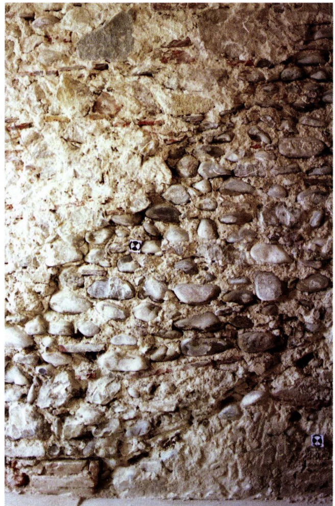
Abb. 14-4 St. Alban-Vorstadt 16 (2004/108). 2. Obergeschoss, westliche Brandmauer. Die untere Dachlinie zeigt noch Dachlattennegative und einige Dachlattenfragmente. Während dieses Dach der untersuchten Mauerseite zuzuordnen ist, gehört die darauf bauende Aufmauerung mit Dachlinie zu der benachbarten westlichen Liegenschaft. – Foto: Basler Denkmalpflege.
