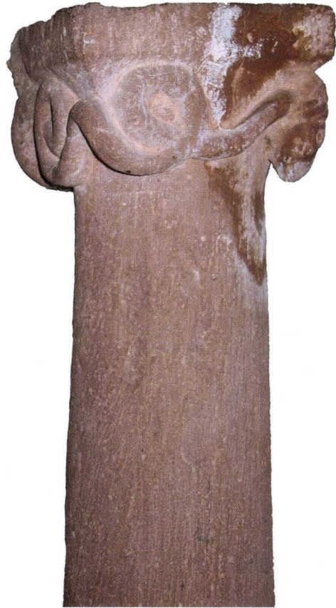
Abb. 13-10 Spalenvorstadt 11 (2004/168). Knauf des obersten Treppenpfostens des Treppenwendels in Sandstein. Die im Portal des Treppenturms eingehauene Jahrzahl 1574 dürfte auch dafür datierend sein. – Foto: Basler Denkmalpflege.
