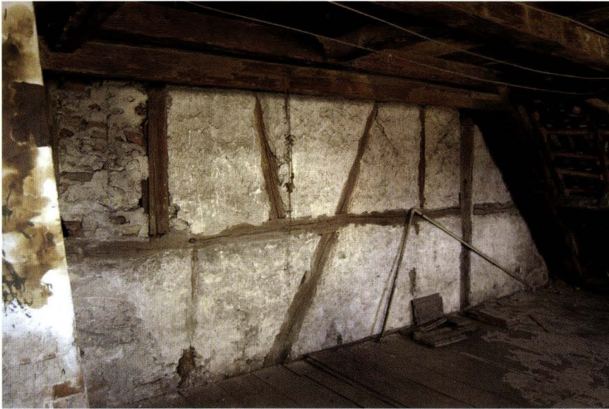
Abb. 10-15 Rössligasse 7, Riehen (2003/381). Ansicht des alten Giebelfachwerks von 1609 im Dachstock des 1707 angebauten Ostteils. Die Fachwerkhölzer sind grösstenteils in Eiche, vereinzelt sogar aus Kirschbaumholz. Die Gefache haben sich mit dem ursprünglichen Verputz bis heute erhalten. Links über dem Riegelhorizont ein zugemauertes Fenster. – Foto: Basler Denkmalpflege.
