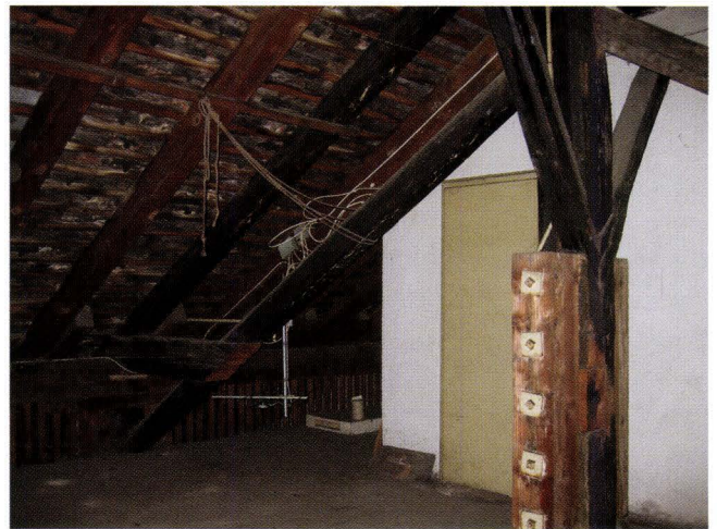
Abb. 7-6 Rebgasse 11 (2003/435). Das dreigeschossige Dachwerk von 1489 ist in den unteren Geschossen mit liegendem Stuhl und im obersten mit einer stehenden Firstabstützung ausgeführt. Der Blick gegen die Hofseite zeigt einen Binder mit durchgesägtem Kehlbalken und Steigbandverstrebung. Im Vordergrund der mit angeblatteten Kopfbändern längsverstrebte Firstständer. – Foto: Basler Denkmalpflege.
