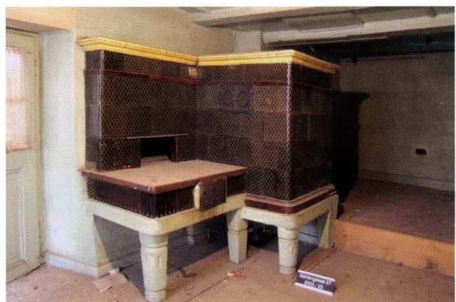
Abb. 3-5 Gartengasse 27, Riehen (2003/23). Der Kachelofen aus Raum 003, mit dunkelbraunen, fast schwarzen Kacheln, welche rautenförmige Muster in heller Farbe aufweisen. Die «Kauß», die Füsse sowie die Grundplatte bestehen aus übermaltem Buntsandstein. Der aus dem 19. Jahrhundert stammende Ofen wurde bei der jetzigen Sanierung aus Platzgründen leider abgebrochen. – Foto: Basler Denkmalpflege.
