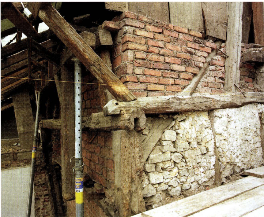
Abb. 4-7 Gartengasse 21, Riehen (2004/107). Blick von Südwesten auf den am besten erhaltenen Bereich der Hochstudkonstruktion von 1547. Auf dem Ständer E (links im Vordergrund) liegt der Rähmbalken U der Westwand mit sichtbarem Zapfenschlitz. Über Eck ist darauf der grob behauene Bundbalken S gelegt. Der Sperr-Rafen R steigt dahinter schräg auf. Backsteine, Riegelauflagen und alle übrigen Balken/Bretter sind jüngeren Datums und trennen Haus Nr. 21 von Nr. 25. – Foto: Bernard Jaggi.
