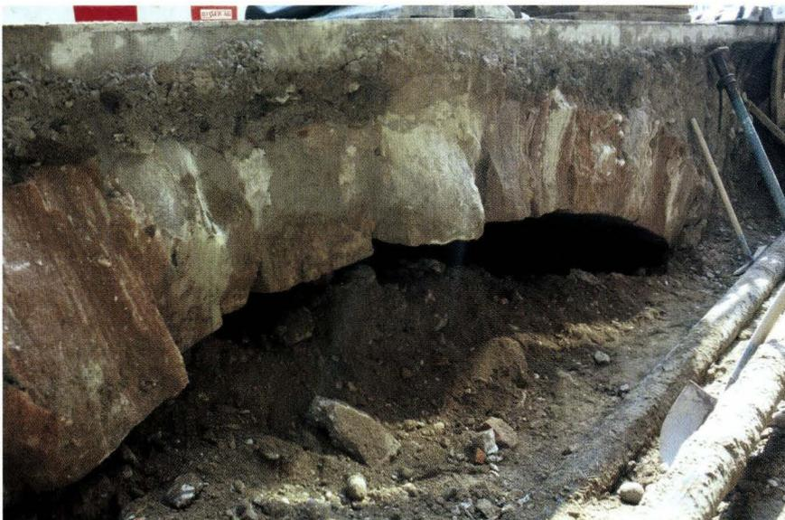
**Abb. 18** Untere Rebgrasse 16–22, 2003/18. Das wenig unter dem Trottoir liegende Gewölbe des Gewerbetichts. – Foto: Catrin Glaser.
