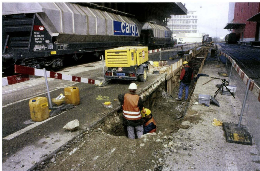
Abb. 9 Rheinhafen St. Johann, Bodensanierung, 2003/19. Freilegen des Westprofils mit teilweise intakter Stratigraphie im rund 80 m langen Leitungsgraben. – Foto: Philippe Wernher.
