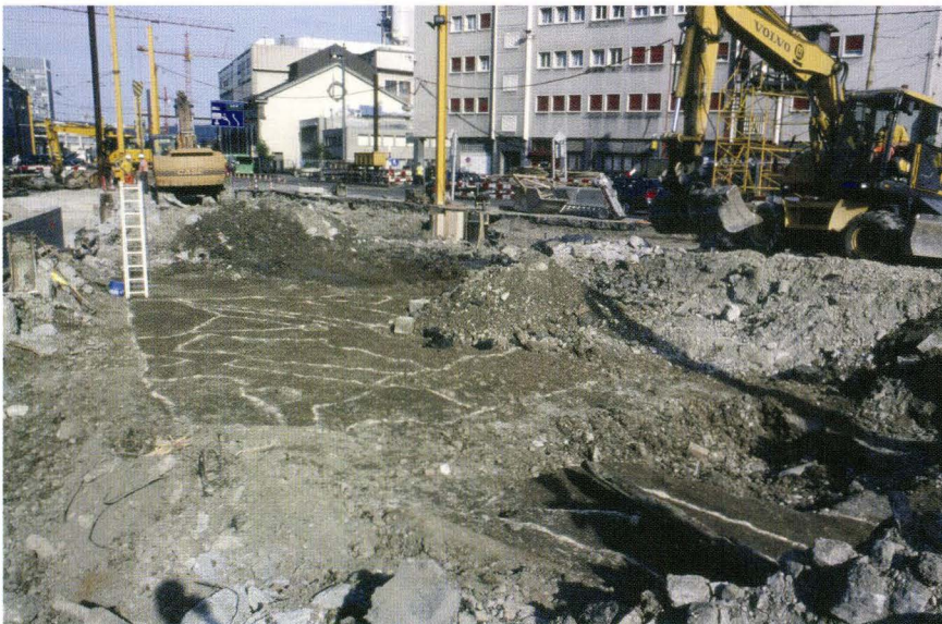
Abb. 11 Voltastrasse (A), Brückeneinbau, 2003/24. Blick über die freigelegten Flächen. Deutlich sind die mittels Sägemehl markierten Strukturen zu erkennen. – Foto: Norbert Spichtig.
