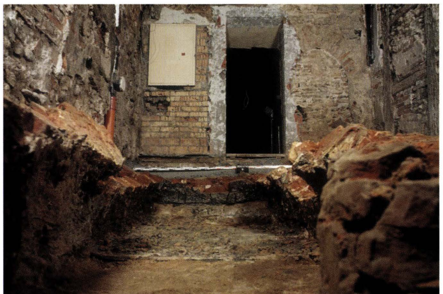
Abb. 35 Klosterberg 21: Brennofen. Blick vom vorderen zum hinteren Feuerungsraum mit dem Gewölbeansatz der Brenntenne. – Foto: Christian Stegmüller.
