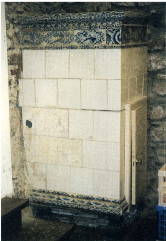
Abb. 21 Neu und unkorrekt gesetzter Ofen in Tscheggenbürlins Hus (heute wieder abgebaut). – Foto: Walter Higy.
