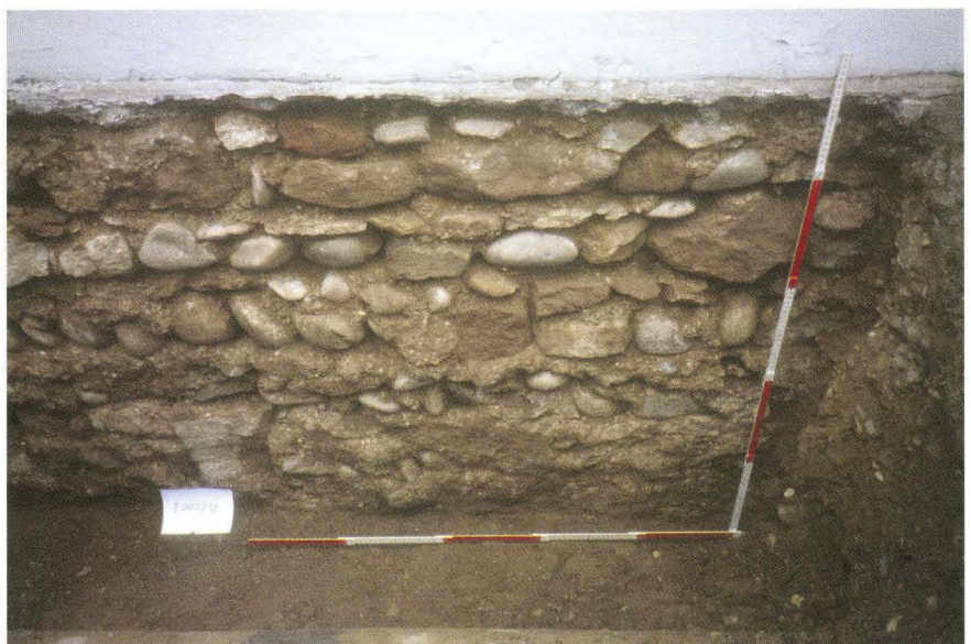
Abb. 13 Theodorskirchplatz (A), 2002/32. Blick auf das freigelegte Fundament der Umfassungsmauer der Kartause (heute Waisenhaus). – Foto: Christoph Matt.
