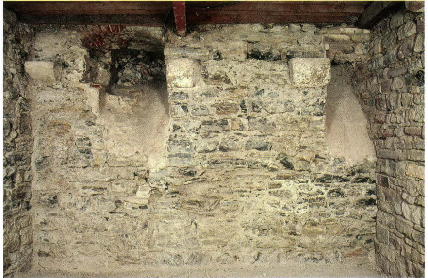
Abb. 12 Nadelberg 12 (Griebenhof) 2002/31. Die vom Putz befreite Westwand des neu ausgegrabenen mittelalterlichen Kellers. Die drei Konsolsteine sind original, die beiden Fensterschächte jüngeren Datums. Am rechten Bildrand die 1885 vorgebaute Brandmauer. – Foto: Christian Stegmüller.
