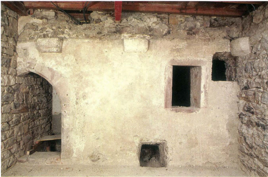
Abb. 11 Nadelberg 12 (Griebenhof) 2002/31. Blick auf die Ostwand des neu ausgegrabenen mittelalterlichen Kellers. Deutlich ist links die beim Hausbau 1885 neu aufgezugene Kellerwand zu erkennen, welche die nördliche Leibung des Spitzbogenportals gewissermassen verschluckt. Am oberen Rand des Putzes sind drei Konsolen für den Streichbalken der Deckenkonstruktion eingelassen. Die beiden oberen Fenster sind jüngerer Datums. Das untere öffnet sich zum immer noch mit Bauschutt verfüllten Tiefkeller. – Foto: Christian Stegmüller.
