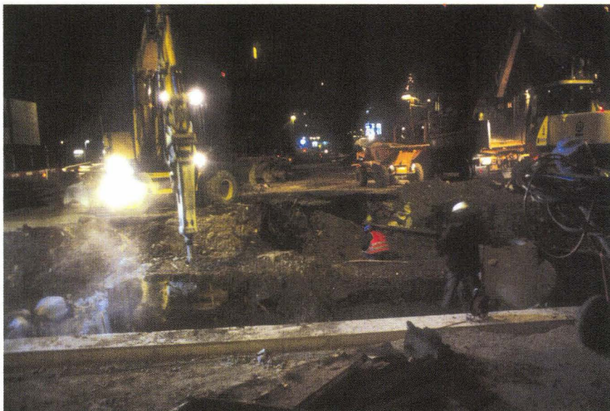
Abb. 15 Elsässerstrasse (A), Brückeneinbau, 2002/40. Baubegleitende Untersuchung während der frühen Morgenstunden.
