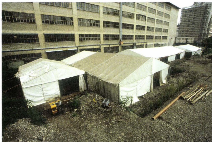
Abb. 8 Lichtstrasse 35, Novartis Bau 231. Übersicht über die Grabungsfläche südlich des Werkstattgebäudes. Von links nach rechts erkennt man die Flächen der Grabungen 2002/14, 2001/25 und 2002/13.
