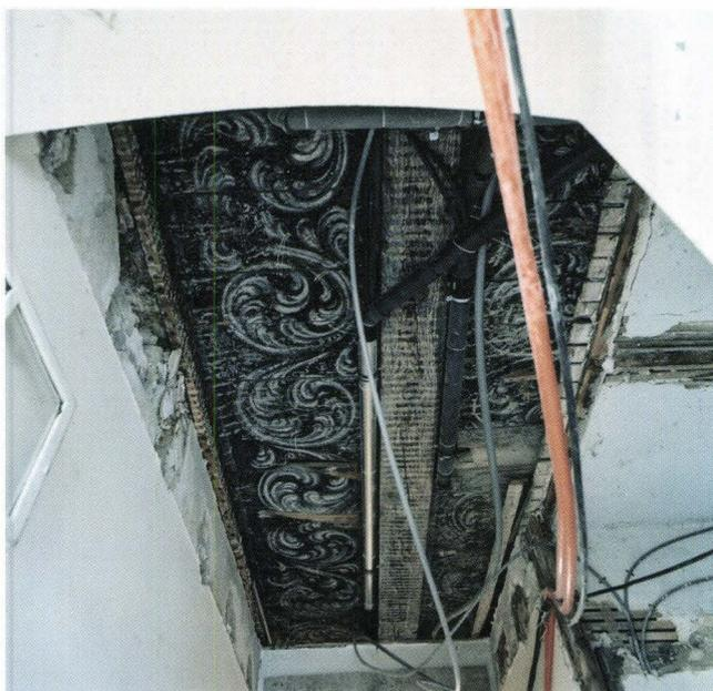
grosse Spannweite des Gebindes. Etliche Hölzer wurden bei der Renovation ersetzt oder verstärkt.
