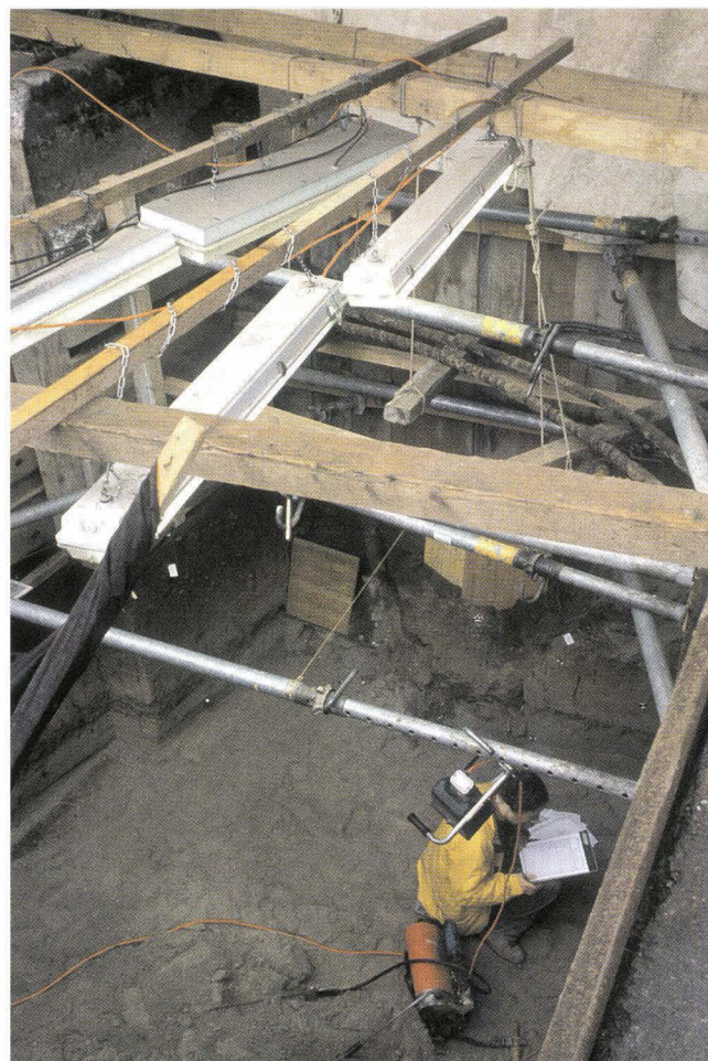
Abb. 3 Voltastrasse (A), LT-Querung, Etappe 1, 2001/2. Grabungssituation von Süden.
