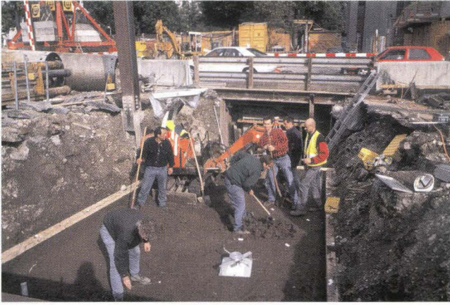
Abb. 8 Voltastrasse (A), LT-Querung, Etappe 2, 2001/19. Grabungssituation von Süden.
