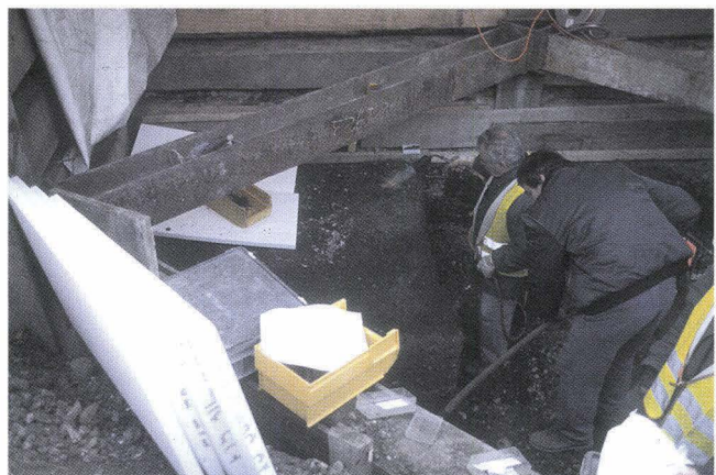
Abb. 18 Voltastrasse (A), Kanalisationsschacht, 2001/47. Der Boden war gefroren.
