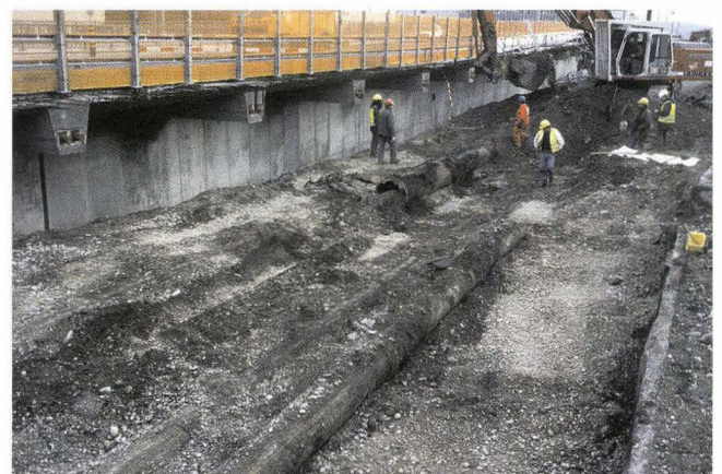
Abb. 11 Voltastrasse (A), Vorlandbauwerk, Etappe 3, 2001/42. Übersicht über den mittleren Bereich des Grabungsgeländes. Teilweise sind die Leitungen schon entfernt.
