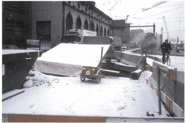
Abb. 17 Voltastrasse (A), Kanalisationsschacht, 2001/47. Stimmungsbild mit Schnee.
