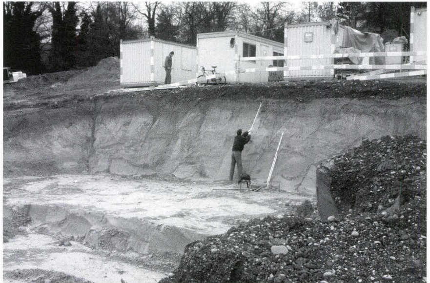
Abb. 3 Riehen, Ludwig-Courvoisier-Strasse (1999/45). Das hangseitige Lössprofil an der Gehrhalde nach Abschluss des Aushubes der terrassenartig abgetreptten Baugrube. – Foto: Christian Bing.
