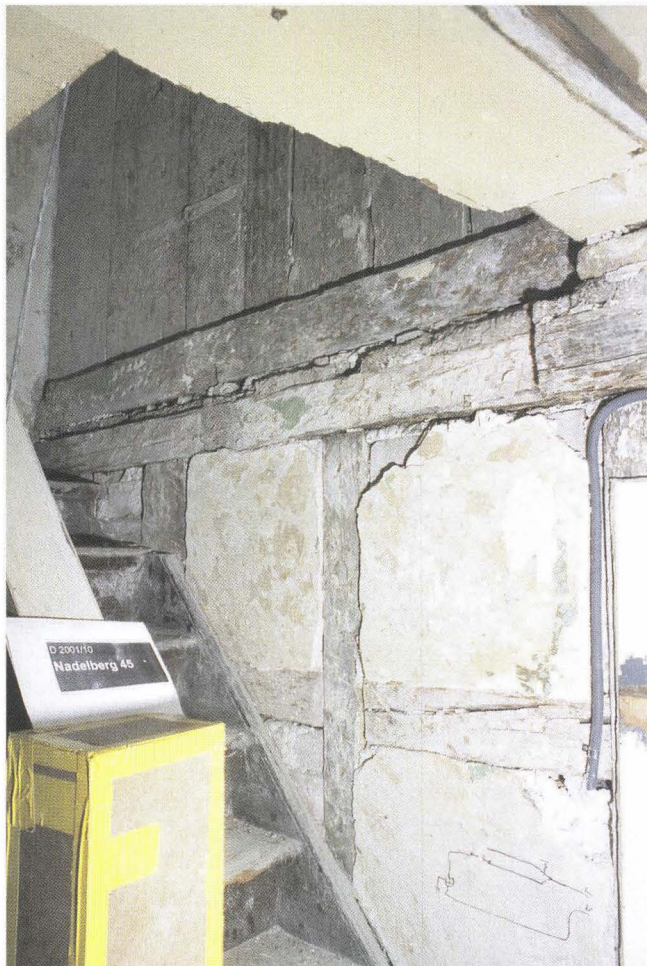
Abb. 25 Nadelberg 45 (D 2001/10). Brandmauer im 2. OG gegen Haus Nummer 47, konstruiert als einfache Fachwerkwand mit Mauergefachen unten und Bretterschaltung im Dachgeschoss. Links davon liegt das einzige Zimmer des Geschosses. Unmittelbar dahinter folgt ein kleiner Lichthof. – Foto: Basler Denkmalpflege.
