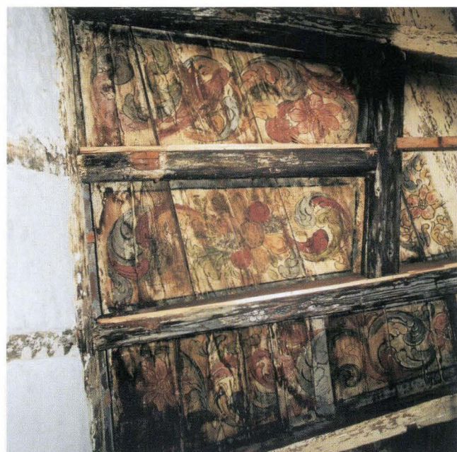
Abb. 8 Barfüsserplatz 23 (D 2001/12). Drittes Obergeschoss. Sicht auf die bemalte Decke aus der Zeit um 1700. – Foto: Basler Denkmalpflege.
