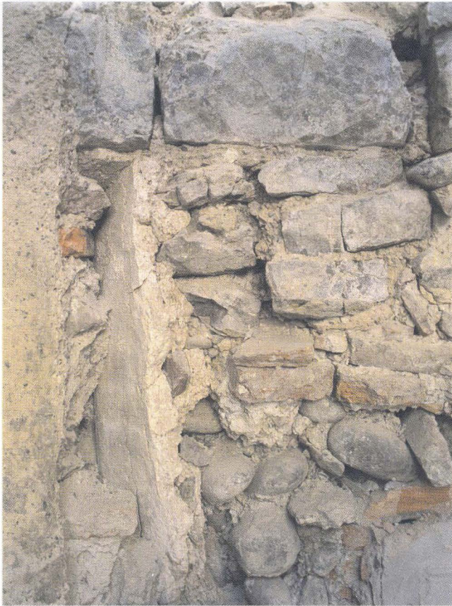
Abb. 14 Gerbergässlein 10 (D 2001/9). Fragment eines originalen Fensters in der Kernbau-Mauer auf Höhe des heutigen 1. OG. Leibung und Sturzansatz in Mörtel, zweischichtig. Die Leibungsfläche läuft ca. um 45 Grad schräg nach innen. Trotz der unterschiedlichen Beschaffenheit von Leibungsmörtel und Mauermörtel ist das Fenster zusammen mit dem Mauerwerk entstanden. – Foto: Basler Denkmalpflege.
