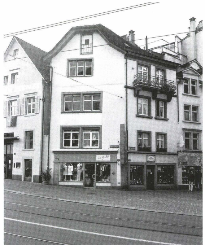
Abb. 4 Barfässerplatz 23 (D 2001/12). Ansicht des Hauses. Zu sehen ist die Giebelseite. Die Traufseite gehört zum Haus Gerbergasse 83. – Foto: Basler Denkmalpflege.
