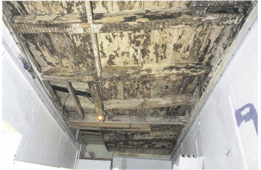
Abb. 37 Untere Rheingasse 12 (D 2000/11). Die freigelegte Balkendecke im mittleren Teil des 1. OG. vor der Sanierung. – Foto: Basler Denkmalpflege.
