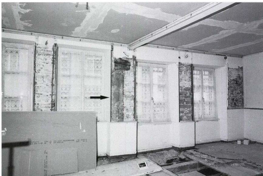
Abb. 39 Untere Rheingasse 12 (D 2000/11). Strassenfassade im 1. OG von innen. Zwischen den beiden mittleren Fenstern die Sandsteinsäule einer früheren Fensteranlage, deren Nischenstürze mittig abgestützt waren (Pfeil). Ein Reststück des Sturzes ist im Mauerwerk erhalten. – Foto: Basler Denkmalpflege.
