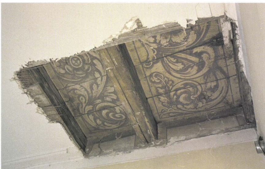
Abb. 17 Gerbergässlein 20 (D 2001/1). Bemalte Balkendecke über dem 2. OG: Barocke Ranken in Rottönen auf Ocker- grund. – Foto: Basler Denkmalpflege.
