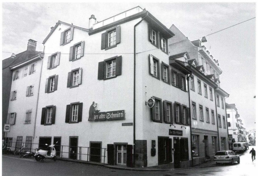
Abb. 33 Untere Rheingasse 12 (D 2000/11). Ansicht der Liegenschaft im heutigen Zustand. – Foto: Basler Denkmalpflege.
