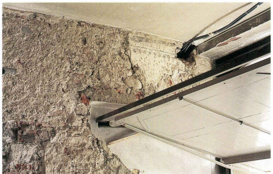
Abb. 68 Lohnhof. Leonhardskirche, Marienkapelle, Aussenseite der Südfassade. Rechts oben Rest einer Putzfläche mit Bollenband-Dekor. – Foto: Basler Denkmalpflege.
