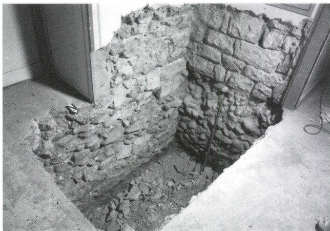
Abb. 11 Lohnhof. Fundament und aufgehendes Mauerwerk des romanischen Stiftsgebäudes (rechts), daran ansetzend die um 1330 erbaute Uhrturm-Nordfassade (links). – Foto: Basler Denkmalpflege.
