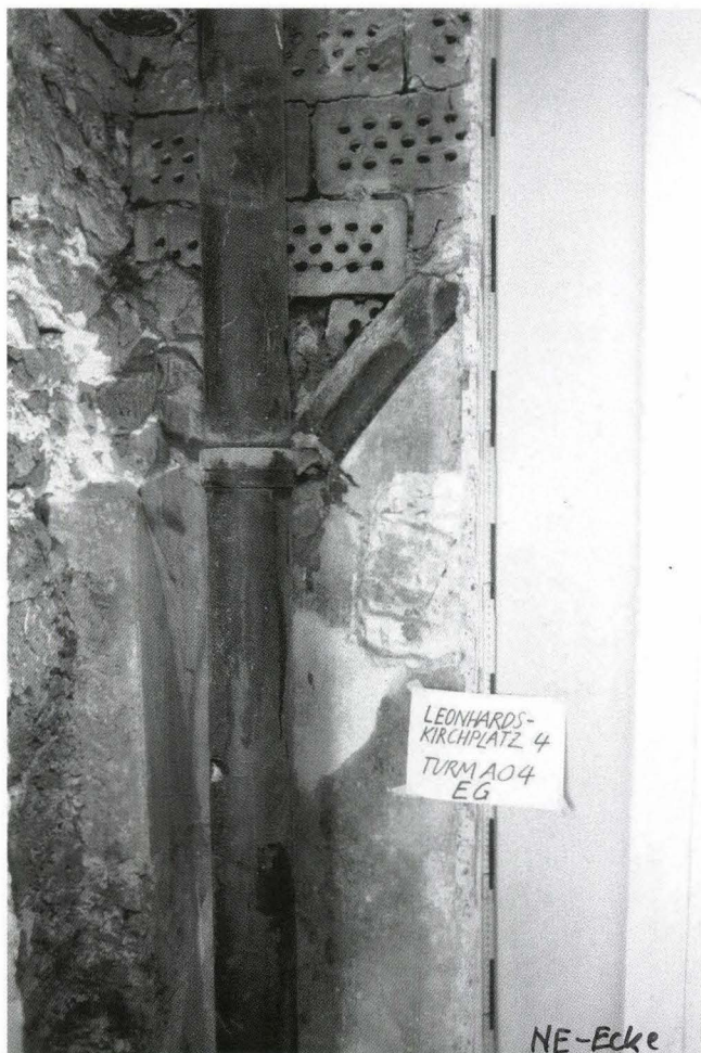
Abb. 78 Lohnhof. Latrinenturm, Erdgeschoss, Nordostecke der Turmkammer. Hinter dem Rohr zeigt sich der Kreuzgrat-Anfänger in Sandstein. Am Innenverputz der Ostwand ist ein Stück der plastisch gemalten Schildbogenrahmung erhalten. – Foto: Basler Denkmalpflege.
