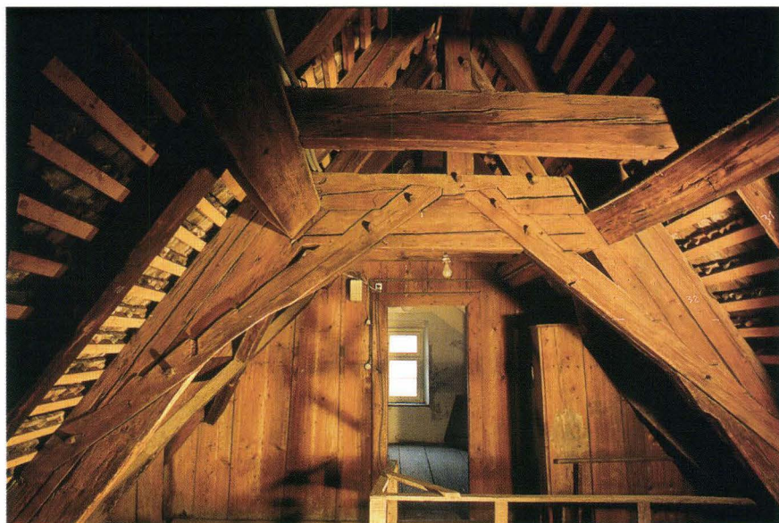
Abb. 74 Lohnhof. Pförtnerhaus, Dachwerk. Binder mit doppelt liegendem Stuhl. Oberhalb des Kehlbalkens ausnahmsweise – nur im Winkel des Dachwerks beim Eckbereich zum Quertrakt – zusätzliche Firstabstützung. Der liegende Binder ist in der Tradition der älteren Dachkonstruktionen mit verbläteten Strebehölzern verstärkt. – Foto: Richard Bucher, Basel.
