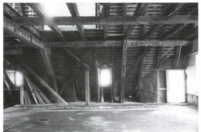
Abb. 42 Lohnhof. Dachwerk des Hüglin-von-Schöneegg-Hauses, Blick gegen den Barfüsserplatz. Bei den auf der linken Seite deponierten Hölzern handelt es sich um einen Teil des Dachstuhls von 1363, der im abgebildeten Dachboden zum Aufschriften verwendet worden war. – Foto: Basler Denkmalpflege.
