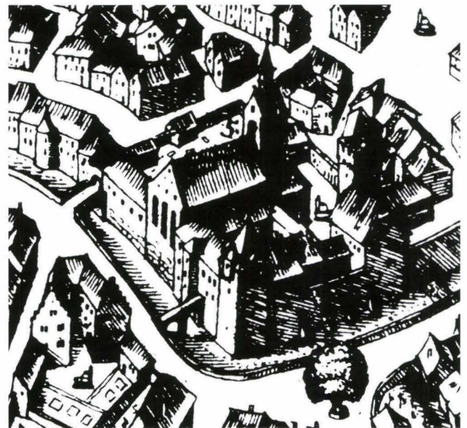
Abb. 3 St. Leonhard von Südwesten. Zwischen dem Eckturm im Vordergrund und der Westfassade der Kirche sind zwei Gebäude – getrennt von einem Risalit-Turm – zu sehen: An die Kirche schliesst das Armarium an, an das Armarium der ehem. Verwaltungstrakt des Klosters, der bis zum Eckturm reicht. In diesen Trakt führte einst die Brücke mit der Wasserleitung über den Graben. Rechts das Hüglin-von-Schöneegg-Haus mit Krüppelwalmdach, dahinter der Latrinenturm. Ausschnitt aus dem Stadtprospekt Süd von Matthäus Merian, um 1615/1642.
