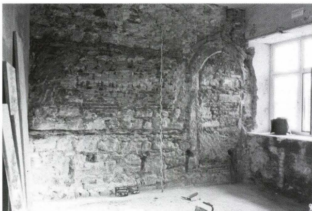
Abb. 33 Lohnhof. Trennmauer von 1358 zwischen den Trakten D und C, mit zugemauertem Spitzbogenportal. Blick Richtung Osten. – Foto: Basler Denkmalpflege.
