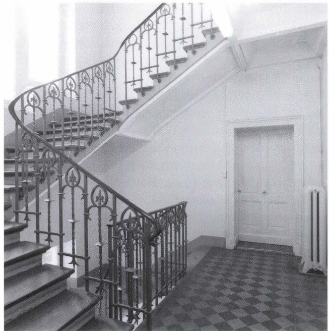
Abb. 79 Lohnhof. Verwaltungsbau von Viktor Flück, erstellt um 1897. Treppenhaus vor dem Umbau. – Foto: Basler Denkmalpflege.
