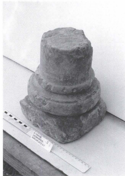
Abb. 93 Lohnhof. Spolie 12. Fragment einer romanischen Zwergsäule mit Basis 102 . Das Fragment war im spätmittelalterlichen Mauerwerk im Bereich des Traktes D in Höhe des Erdgeschosses eingemauert. – Foto: Basler Denkmalpflege.
