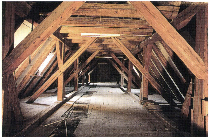
Abb. 57 Lohnhof. Armarium, Dachwerk aus dem Jahr 1440. Blick vom Kehlgeschoss Richtung Norden (gegen die Leonhardskirche). Dreigeschossige, kombinierte Dachkonstruktion mit unten liegenden Stuhlsäulen, im mittleren Geschoss doppelt stehend, über dem 2. Kehlgeschoss nicht abgestützter First mit verblatteten Sparren (Hahnenbalken). Steigbänder von unterer Stuhlstrebe bis zum oberen Kehlbalken. Die Dachkonstruktion wurde 1853 nach der Gebäudeaufstockung wieder aufgerichtet. – Foto: Richard Bucher, Basel.
