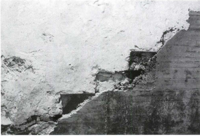
Abb. 54 Lohnhof. Ehemaliger Süd-Zugang zum Gewölbekeller unter dem Armarium. Im Verputz des alten Kellerhalses erkennt man die Stufen der Kellertreppe, die über die Abbruchkrone der Burkhardtschen Stadtmauer gelegt waren. Der Zugang war mit einem Gewölbe überdeckt. – Foto: Basler Denkmalpflege.
