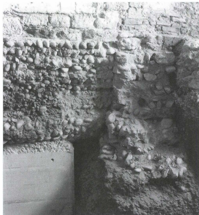
Abb. 14 Lohnhof. Ein Teil der Südfassade des Stiftsgebäudes und der Anschluss des Arealmauer-Fundaments (vorne). Dessen Fortsetzung ist abgebrochen. – Foto: Basler Denkmalpflege.
