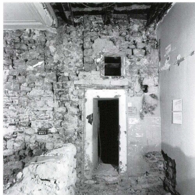
Abb. 6 Lohnhof. Aussenansicht des Abschnitts der Burkhardtschen Stadtmauer neben dem Eckturm (rechts), mit dem ehemaligen Durchlass (Pfeil). Vorn die Nordmauer einer ehemaligen Zelle nördlich des Eckturms (teilweise abgetragen). – Foto: Basler Denkmalpflege.
