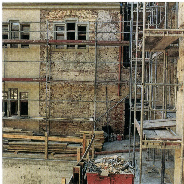
Abb. 59 Lohnhof. Ostfassade des Armariums. Der freigelegte Fassadenabschnitt im nördlichen Teil beim Anschluss an die Leonhardskirche zeigt die Bauphase des Bibliotheksbaus von 1440 (unterer Teil = 1. OG) und das 1853 aufgestockte Geschoss mit dem nachträglich eingebauten Stufenfenster, das die «echten» spätgotischen Fenster des unteren Geschosses imitiert. – Foto: Basler Denkmalpflege.
