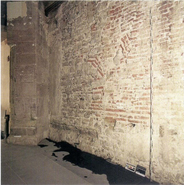
Abb. 67 Lohnhof. Leonhardskirche, Marienkapelle, Aussenansicht der Südfassade im Erdgeschoss. Man erkennt in der mittleren Zone eine in Backstein gemauerte Fläche sowie schräg ansteigende Backsteinlagen. Der Bereich bildet die Rückmauer einer schlanker ausgeführten Nischenzone auf der Innenseite. Im Hintergrund der diagonal gestellte Eckpfeiler der Hallenkirche (um 1490), der eindeutig jünger ist als die Südmauer der Kapelle. – Foto: Basler Denkmalpflege.
