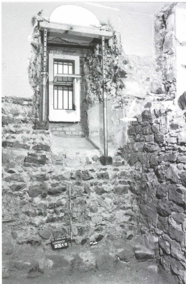
Abb. 15 Lohnhof. Zelle nördlich des Eckturms mit Blick an die Innere Stadtmauer. Zu erkennen eine Fensterleibung des 14. Jahrhunderts (glatte Fläche, unterer Pfeil). Mit diesem Fenster wurde eine ältere Öffnung teilweise verschlossen. (Der obere Pfeil verweist auf deren Sturz). – Foto: Basler Denkmalpflege.
