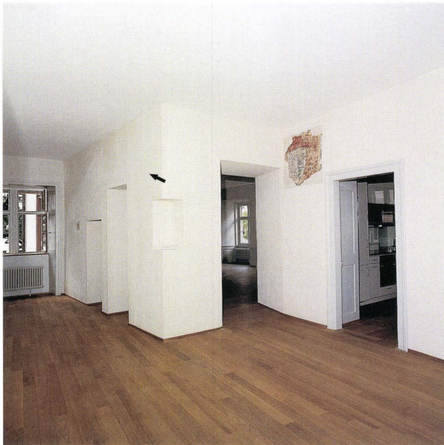
Abb. 37 Lohnhof. Vorhalle im 1. Obergeschoss vor dem Eckturm; restaurierter Zustand. Der Pfeil markiert die Stelle mit dem Wappen Wighus. – Foto: Basler Denkmalpflege.
