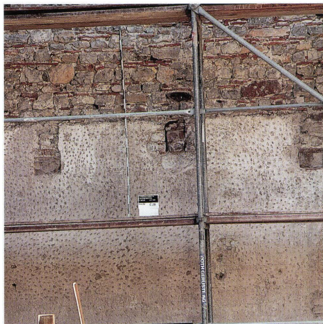
Abb. 62 Lohnhof. Leonhardskirche, Südfassade. Mauerbefund im Bereich des Kreuzgang-Obergeschosses. Der vorhandene Verputz gehörte zur Innenseite des an die Hallenkirche von 1490 angebauten zweigeschossigen Kreuzgangflügels. Am oberen Rand zeigen sich die abgeschlagenen Kragsteine, welche die Pfette des Pultdachs trugen. Darüber gut erkennbar ist die Art des Mauerwerks der Kirchenfassade. – Foto: Basler Denkmalpflege.
