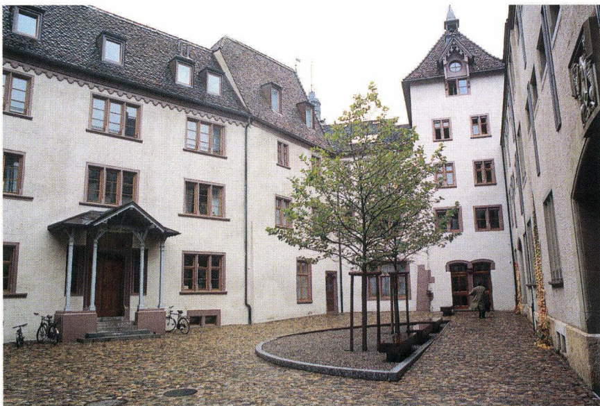
Abb. 43 Lohnhof. Südhof im restaurierten Zustand, Blick zum Uhrturm. Links Trakt C. – Foto: Basler Denkmalpflege.
