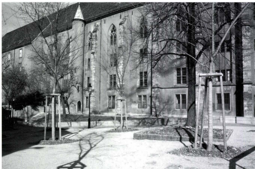
Abb. 75 Kasernenstrasse, Grünanlage (2000/36). Sicht über den neu gestalteten Platz auf die ehemalige Klosterkirche. Deutlich ist die erhöhte Lage des westlichen Chorteils und der dahinter ansetzenden Leutkirche zu sehen. – Foto: Catrin Glaser.
