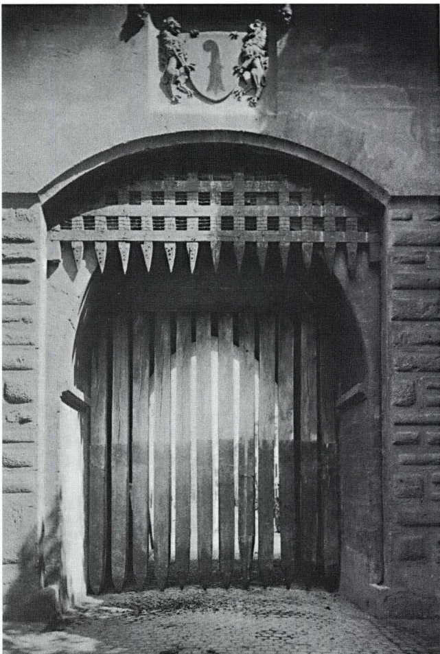
Abb. 54 Herabgelassenes inneres Fallgitter des Spalentors. (Nach KDM BS 3, 265 Abb. 183).
