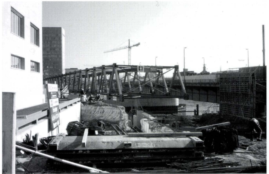
Abb. 7 Der neue Rheinübergang der Nordtangente (A2): Thema einer Spezialführung der ARGE Dreirosenbrücke für die MitarbeiterInnen der Archäologischen Bodenforschung am 29.6.2000. – Foto: Peter-A. Schwarz.
