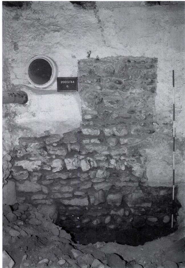
Abb. 76 Rheingasse 57 / Oberer Rheinweg 62 (2000/44). Blick in Richtung Südwesten an die Innenseite der Kleinbasler Stadtmauer. – Foto: Catrin Glaser.
