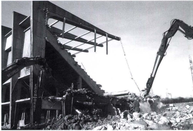
Abb. 47 St. Jakobs-Strasse 395–397 – Stadion St. Jakob (1999/4). Abbruch des alten Stadions. – Foto: Christian Bing.
