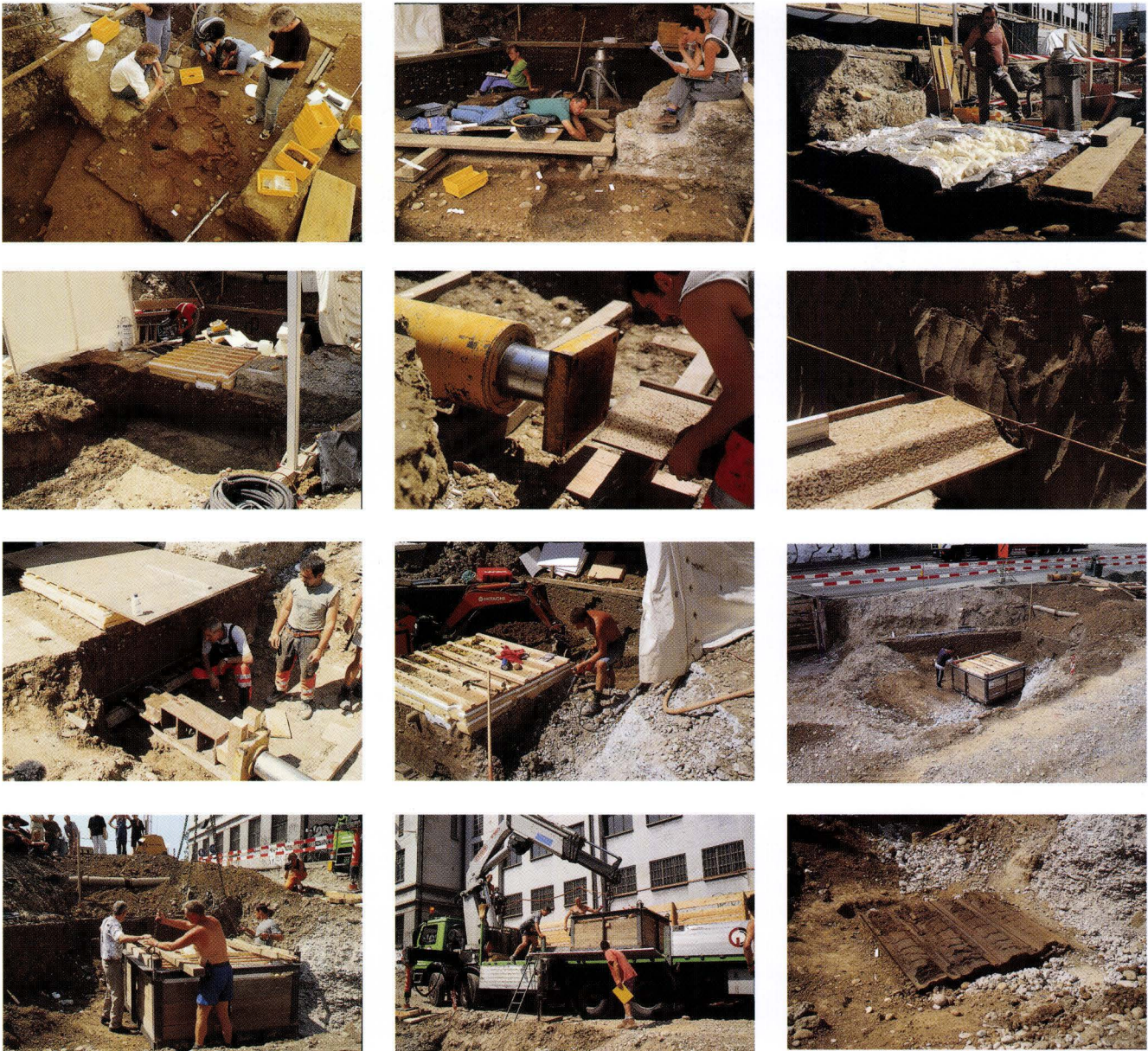
Abb. 46 Voltastrasse (A), Deckel Nord, Etappe 3 (2000/18). En bloc-Bergung des im Trassee der Nordtangente gefundenen spätlatènezeitlichen Töpferofens. – Fotos: Michael Balmelli.
