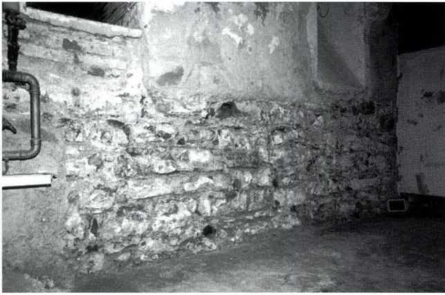
Abb. 71 Nadelberg 10, Zerkindenhof (2000/24). Blick in den Westkeller des Flügelbaus: Mauerwerk des 13. Jahrhunderts. – Foto: Catrin Glaser.
