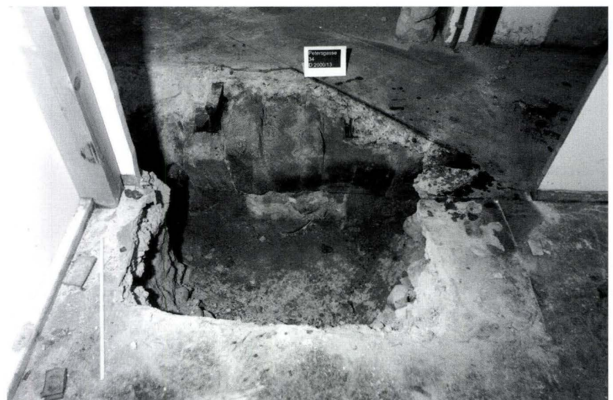
Abb. 19 Scheitel des originalen Kellerportalbogens, Ansicht vom Erdgeschoss her. – Foto: Basler Denkmalpflege.
