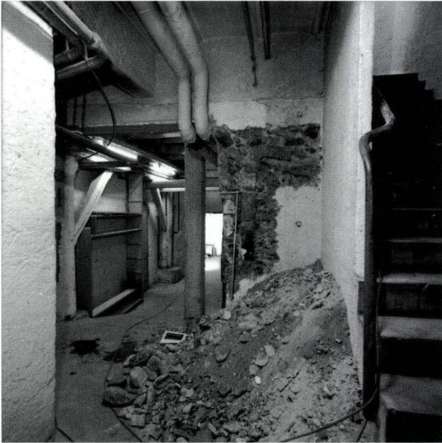
Abb. 16 Blick in den Keller, von der modernen Treppe aus gegen Westen zur Quermauer. Im Hintergrund die Stützen von 1360. – Foto: Basler Denkmalpflege.
