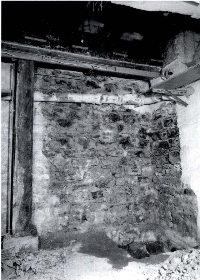
Abb. 18 Teilfreilegung des Originalmauerwerks in der Südwestecke des Kellers. – Foto: Basler Denkmalpflege.
