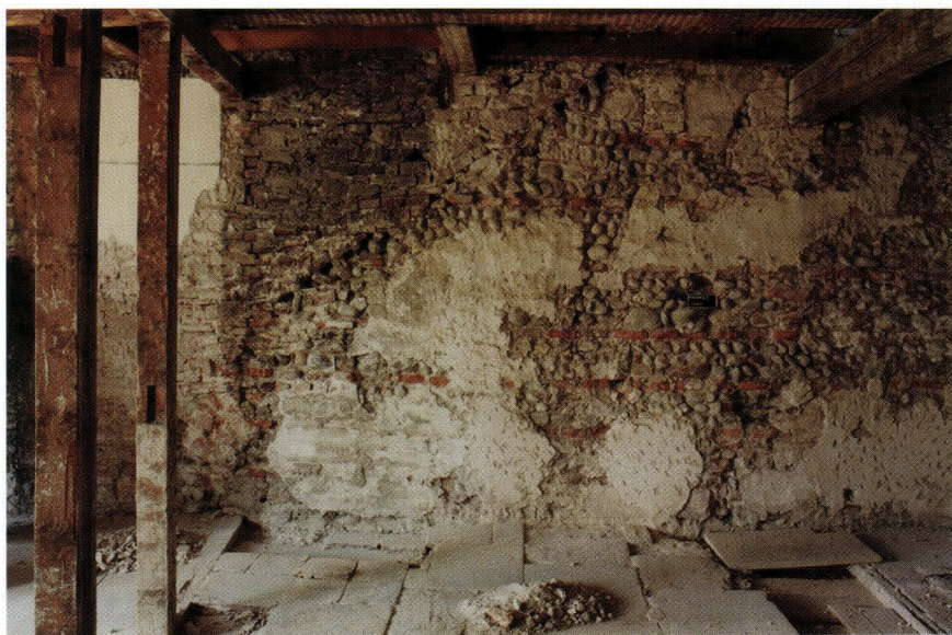
Abb. 8 Heuberg 4/Leonhardsgraben 21 (D 1999/02). Westbrandmauer im Hinterhaus, 3. OG. Der Verlauf des ehemaligen Daches ist anhand der Dachlattenlöcher nachvollziehbar. Deutlich sichtbar ist auch das Mauerwerk aus Rheinwaggen und Bruchsteinen mit Ausgleichlagen aus Backsteinen. Links die grabenseitige Erweiterung des 19. Jahrhunderts. – Foto: Basler Denkmalpflege.
