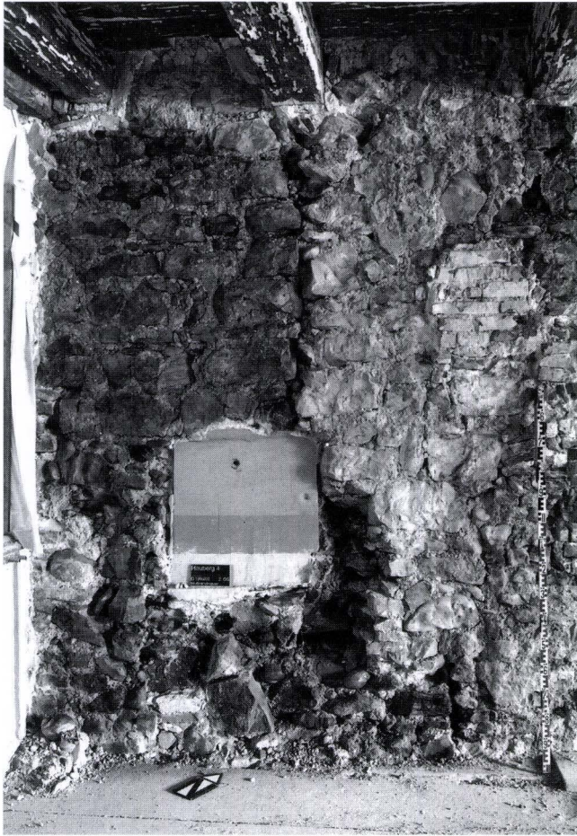
Abb. 6 Heuberg 4/Leonhardsgraben 21 (D 1999/02). Westbrandmauer im Vorderhaus, 2.OG, Detail. Links der senkrechten Baunaht das Mauerwerk des Kernbaus, rechts die daran ansetzende Erweiterung in Richtung Heuberg. – Foto: Basler Denkmalpflege.
