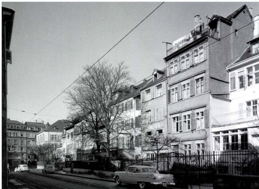
Abb. 2 Heuberg 4/Leonhardsgraben 21 (D 1999/02). Ansicht Leonhardsgraben im Jahr 1957. Die Häuserzeile am Leonhardsgraben (Nr. 21 ist das zweite Haus von rechts) zeigt das unterschiedliche Ausmass der Grabenbebauung. Der Verlauf der Inneren Stadtmauer ist anhand der Rücksprünge in den Fassadenfluchten nachvollziehbar. – Foto: Peter Heman.
