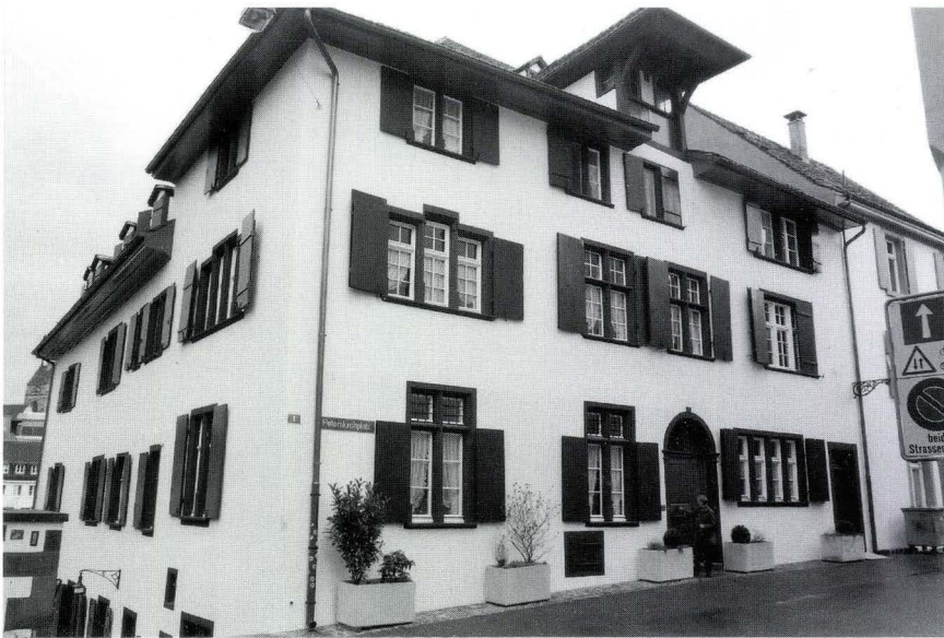
Abb. 7 Ansicht des Hauses von der Petersgasse her mit dem Haupteingang am Nadelberg. – Foto: Basler Denkmalpflege.
