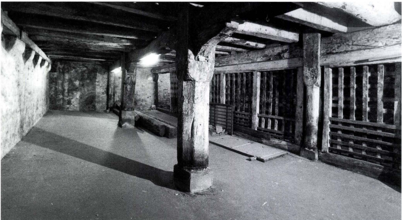
Abb. 4 Der grosse Raum im untersten Kellergeschoss (4. UG) mit Blick gegen Westen. Rechts die spätmittelalterliche Unterteilung des Kellers mit «Grätting»-Wänden (die Bezeichnung für diese Art von Wänden ist der Seemannssprache entlehnt). – Foto: Kurt Wyss 1989.
