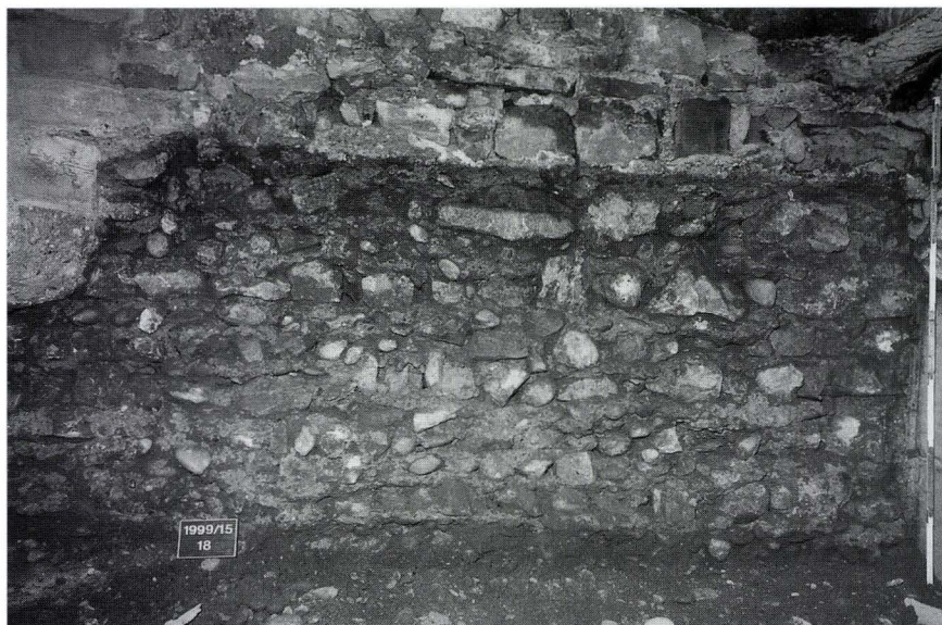
Abb. 73 Petersplatz 4 (1999/15). Blick auf das (Haus- oder Stadtmauer-?)Fundament (dunkel) unter dem barocken Hausfundament (hell). – Foto: Catrin Glaser.
