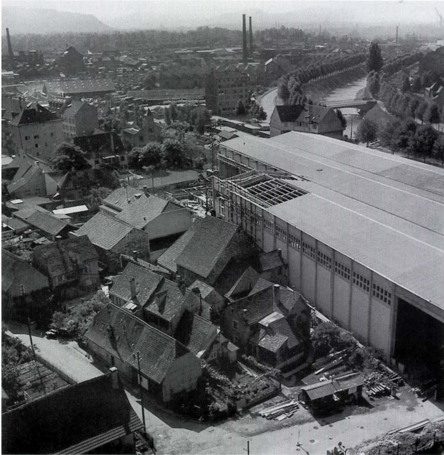
Abb. 82 Schulgasse 27 (1999/45). Kleinhüningen im Jahre 1954: das Quartier zwischen Schulgasse, Bonergasse und ehe- maliger Pfarrgasse. Links vorne das lang- gestreckte Fischerhaus (Wohnteil mit ange- bauer Scheune) an der Schulgasse 27. – Foto aus: Bürgerkorporation Kleinhüningen (Hrsg.), Kleinhüningen – Fischer, Hafen, Industrie, Quartier, Stadt, Dorf (Basel 1999), Seite 41.
