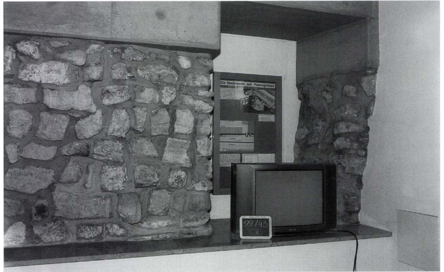
Abb. 83 Petersgraben 45 (1999/48). Blick in den Aufenthaltsraum der neuapostolischen Kirche mit den Fundamenten der Inneren Stadtmauer. – Foto: Catrin Glaser.
