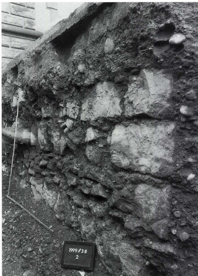
Abb. 77 Spalenvorstadt (A) (1999/38). Fundamentecke des alten Kornhauses aus dem späten 16. Jh. Im Hintergrund die Alte Gewerbeschule. – Foto: Christoph Ph. Matt.
