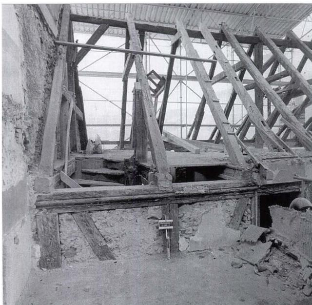
**Abb. 17** Webergasse 7. Die Dachkonstruktion des Hinterhauses von 1689 während den Sanierungsarbeiten, mit Blick gegen Nordwesten. – Foto: Basler Denkmalpflege (M665-18).
