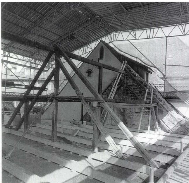
**Abb. 16** Webergasse 7. Die Dachkonstruktion des Vorderhauses während den Sanierungsarbeiten, mit Blick von der Strasse gegen Nordwesten; dendrodatiert 1452. – Foto: Basler Denkmalpflege (M703-16).
