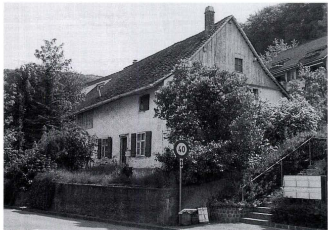
Abb. 13 Hauptstrasse 74. Ansicht. – Foto: Hans Ritzmann.
