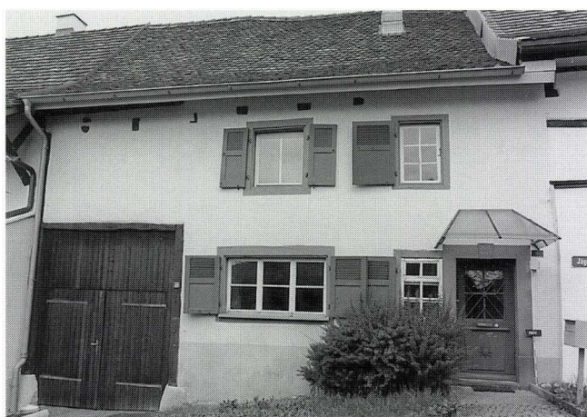
Abb. 8 Jägerweg 9. Ansicht Strassenfassade. – Foto: Hans Ritzmann.
