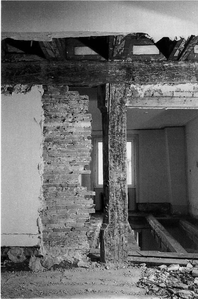
Abb. 12 Bäumleingasse 14. Freigelegte Stütze des Ausbaus von 1498 im 3. Obergeschoss. Bemalung der Decke aus dem 17. Jahrhundert. – Foto: BaDpfl B 764–10.
