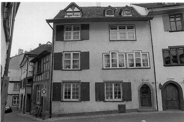
Abb. 1. Gemsberg 7. Hauptfassade des Gebäudes (am Unteren Heuberg). – Foto: BaDpfl.
