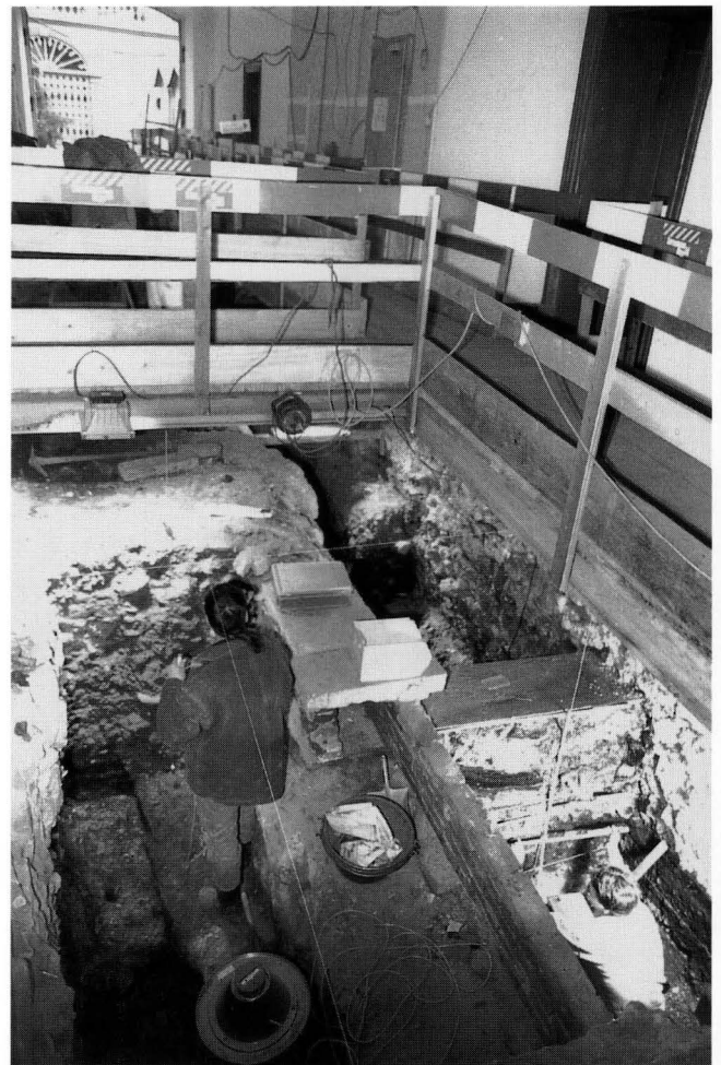
Abb. 2. Ausgrabungen im Stadthaus. Links Fläche SS V, rechts vorne SS VIII, rechts hinten FL 1. Im Hintergrund ist der hintere Ausgang zum Höflein sichtbar (Foto A 8).
