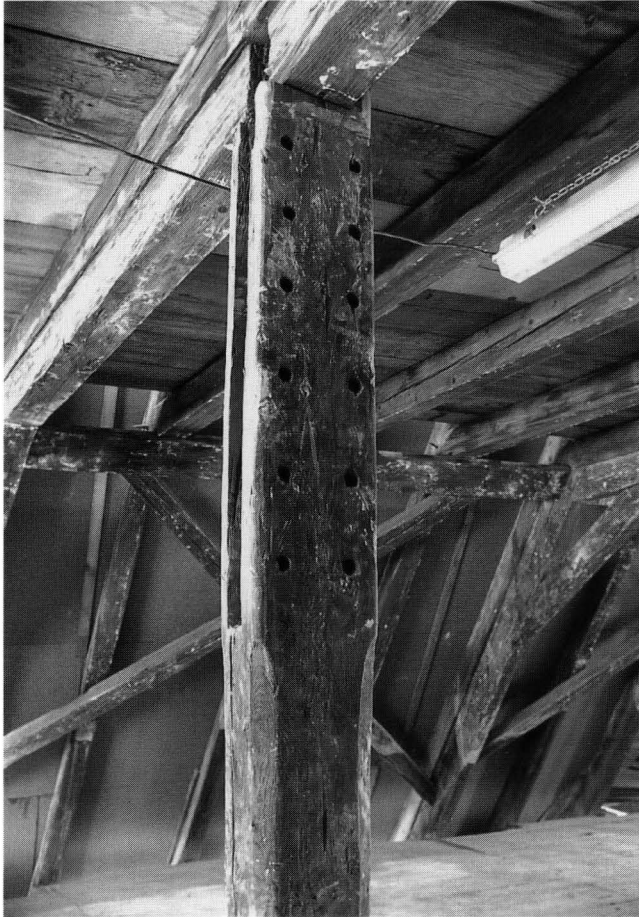
Abb. 12. Spuren einer Aufhängung für die Papiertrocknung im zweiten Dachboden (Detail). – Foto: BaDpfl.
