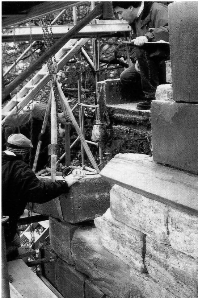
Abb. 1. Südöstliche Ecke der Pfalzmauer beim Neuversetzen der Steine. – Foto: BaDpfl.
