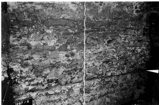
Abb. 6. Engelhof. Südfundament des Hauptbaus aus dem 14. Jh., Blick nach Norden. Der Pfeil bezeichnet die Oberkante des natürlichen Kiesel, darunter die als Unterfangung erstellte (und daher jüngere) spätmittelalterliche Kellermauer (vgl. Abb. 3: Profil P 40, Mauer MR 1 a/b/c). – Foto: F 47.
