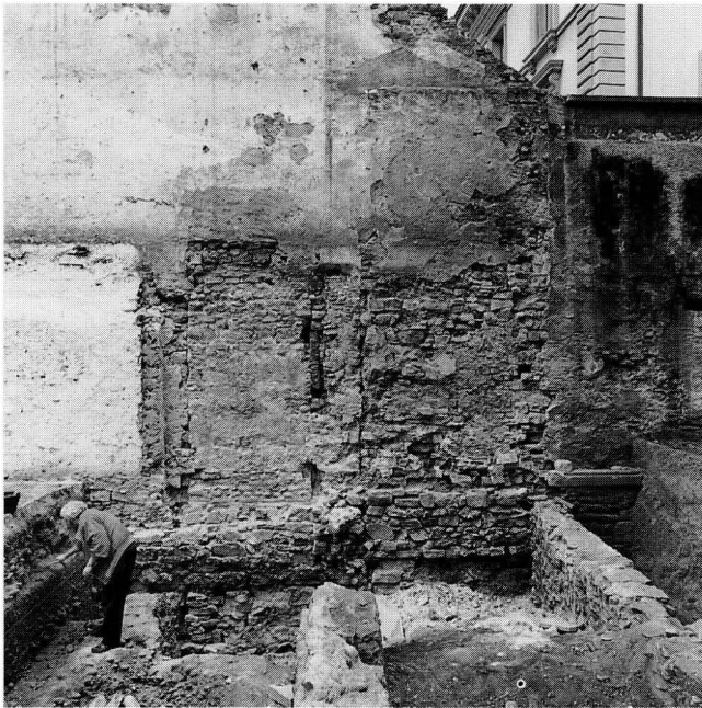
Abb. 3. Rittergasse 29/31. Die südliche Brandmauer nach Abbruch der Remise (Ausschnitt) mit dem ehemaligen Kellerportal (vgl. Abb. 2,5), Blick von Norden. – Foto: BaDpfl.
