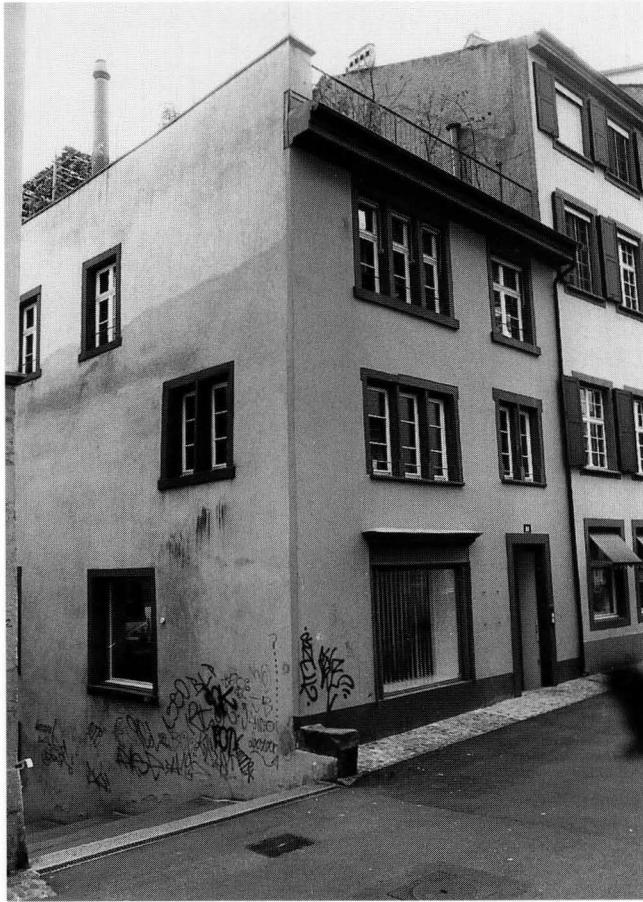
Abb. 1. Nadelberg 21. Die beiden Fassaden des Gebäudes am Nadelberg (rechts) bzw. am Imbergässlein (links) nach dem Umbau 1993
