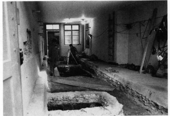
Abb. 1. Ausgrabung in der Garage im Vorderhaus (Sektor S I), Blick nach Osten. Im Vordergrund Sondierschnitt SS II; unter dem Absatz am rechten Grabungsrand sind die obersten Steinlagen von Kellermauer MR 1 zu erkennen. – Foto: F 5a.
