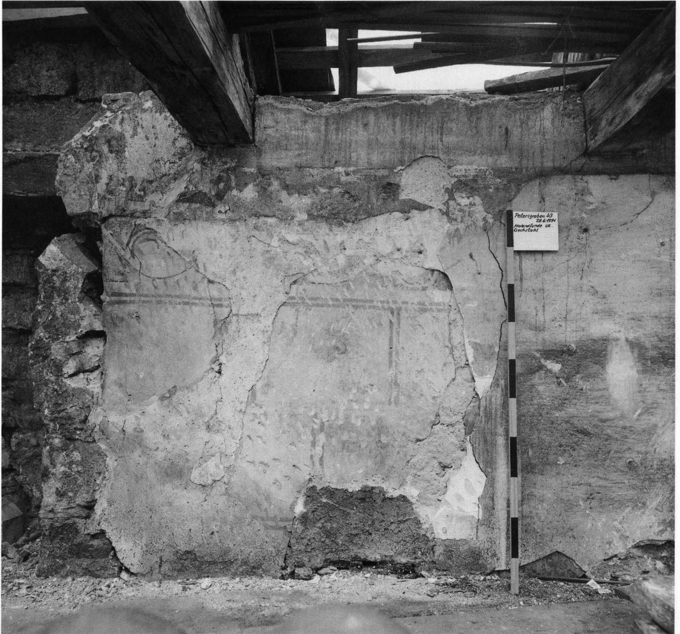
Abb. 8. Gesamtansicht der Südwand unter dem Dach. Der originale Innenputz enthält noch grosse Partien der ursprünglichen Quadermalerei, die mit einem Rankenfries unter der ehemaligen Bretterdecke abschloss (vgl. auch Abb. 6). Die Mauerkrone darüber entstand im Zuge der Errichtung des neuen Dachstuhls.
