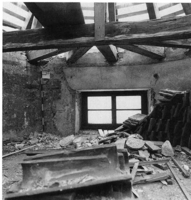
4b. Über der originalen Fensteröffnung fächert die Bundbalkenlage des Dachstuhls von der runden Schalenturm mittels eingewechselter Stichbalken zur polygonalen Abwalmung auf. Die Sturzhöhe über dem Fenster markiert ca. die Aufhöhung des Turms bei der Errichtung des neuen Dachstuhls (14./15. Jh.).
