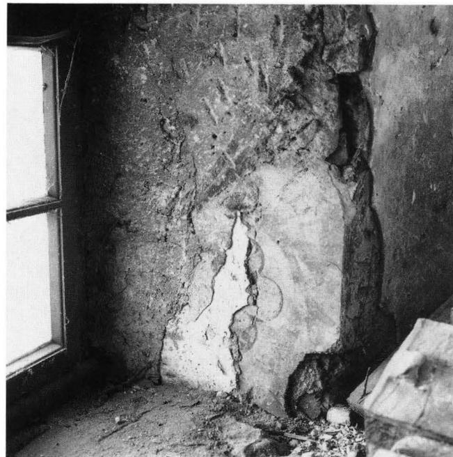
Abb. 7. Reste des Originalverputzes an der nördlichen Leibung des Mittelfensters unter dem Dach. In der Mitte der Fläche war eine grosse Rose aufgemalt, deren innere Hälfte erhalten ist. Die Verputzflächen gegen aussen und darüber sind erneuert.
