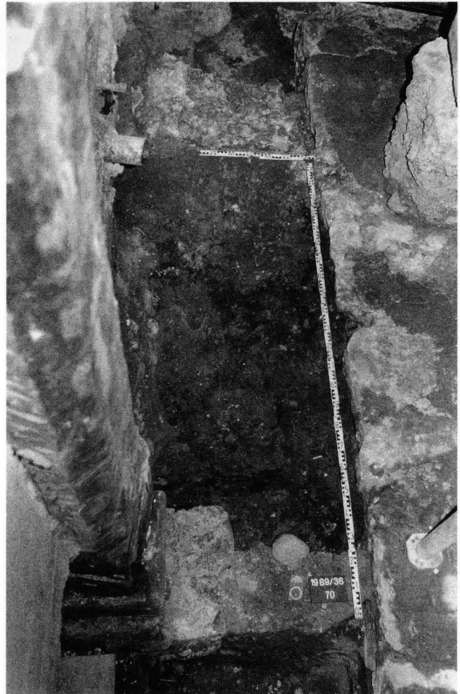
Abb. 11. Alte Landvogtei, Überreste des Bretterbodens und Tresterschicht (Sondierschnitt V). Hinter dem Fundament des Sandsteinsockels ein Unterzug des Bretterbodens; rechts anschliessend das gemauerte Trottenfundament. Blick nach Norden.
