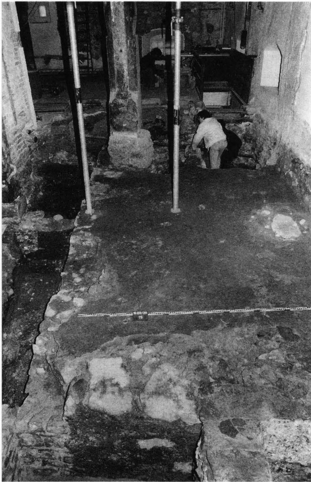
Abb. 12. Alte Landvogtei, gemauertes Fundament der Trotte (Sondierschnitte I und III–V). Im Vordergrund des Bildes ist die Kellergrube angeschnitten. Blick nach Norden.
